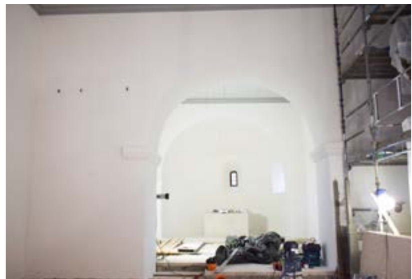
Nyputsade och nymålade väggar.
