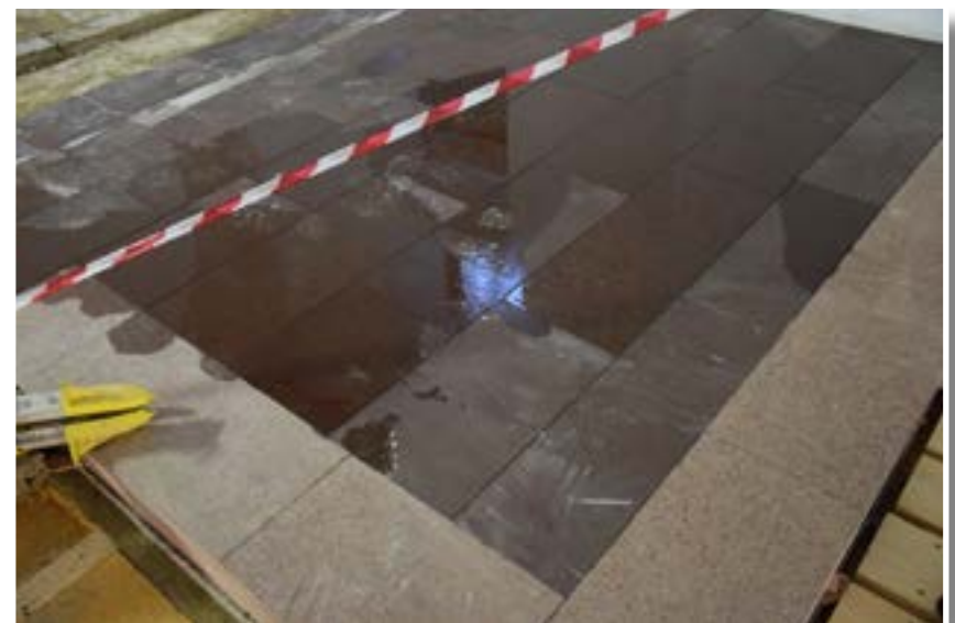
Bild från monteringen av det nya stengolvet i koret.
