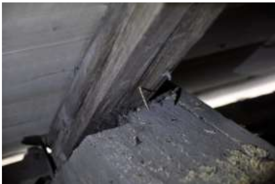
Mycket ovarsamma lagningar med alldeles för långa spik och skruv.
