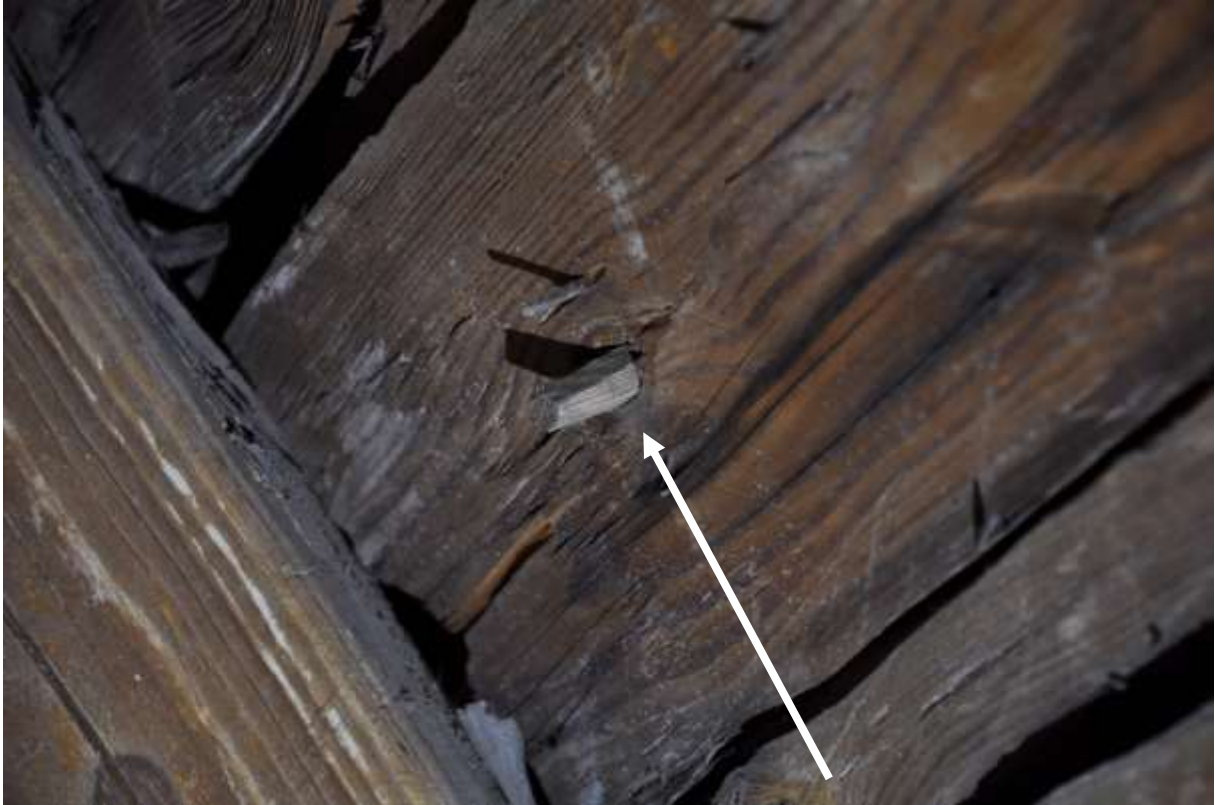
Det finns flera exempel på att man har pluggat mindre kvisthål.
