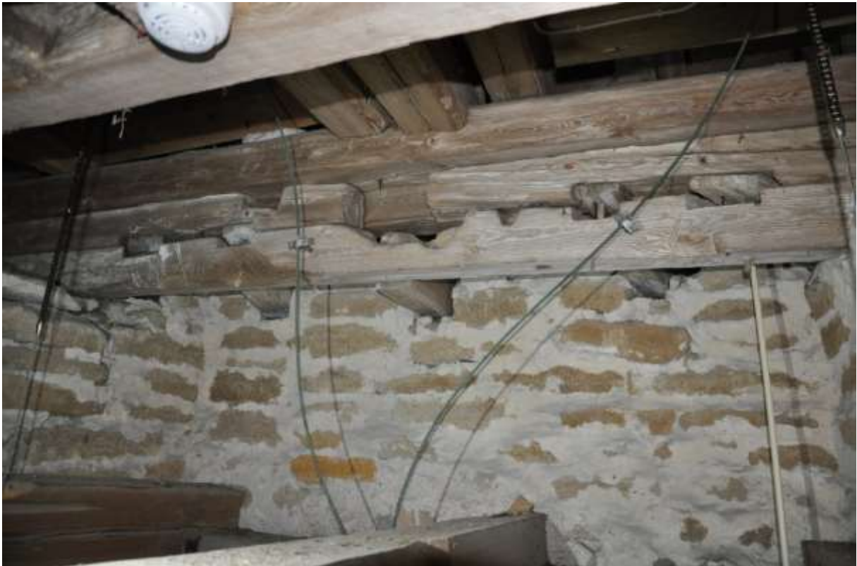
Del av den ursprungliga tornhuvsyllen med stickbjälkar som lyfts ur sina knutpunkter.
