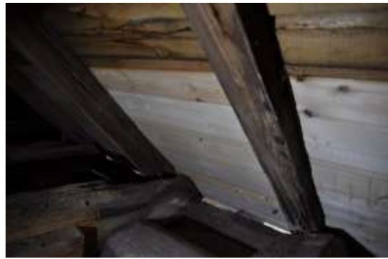
Bilderna visar undertaket före och efter omläggning. Numer finns inga ursprungliga brädor bevarade.
