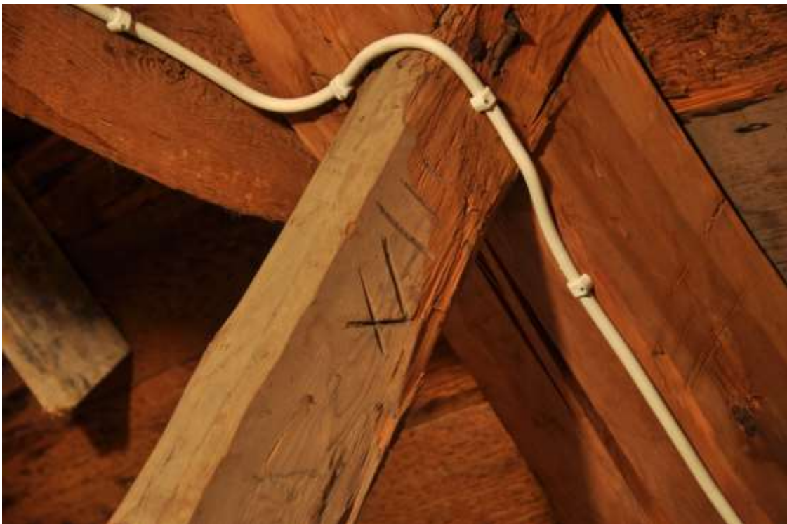
På detta stödben av återanvänt virke syns en timmermansmärkning. Möjligen senmedeltida.
