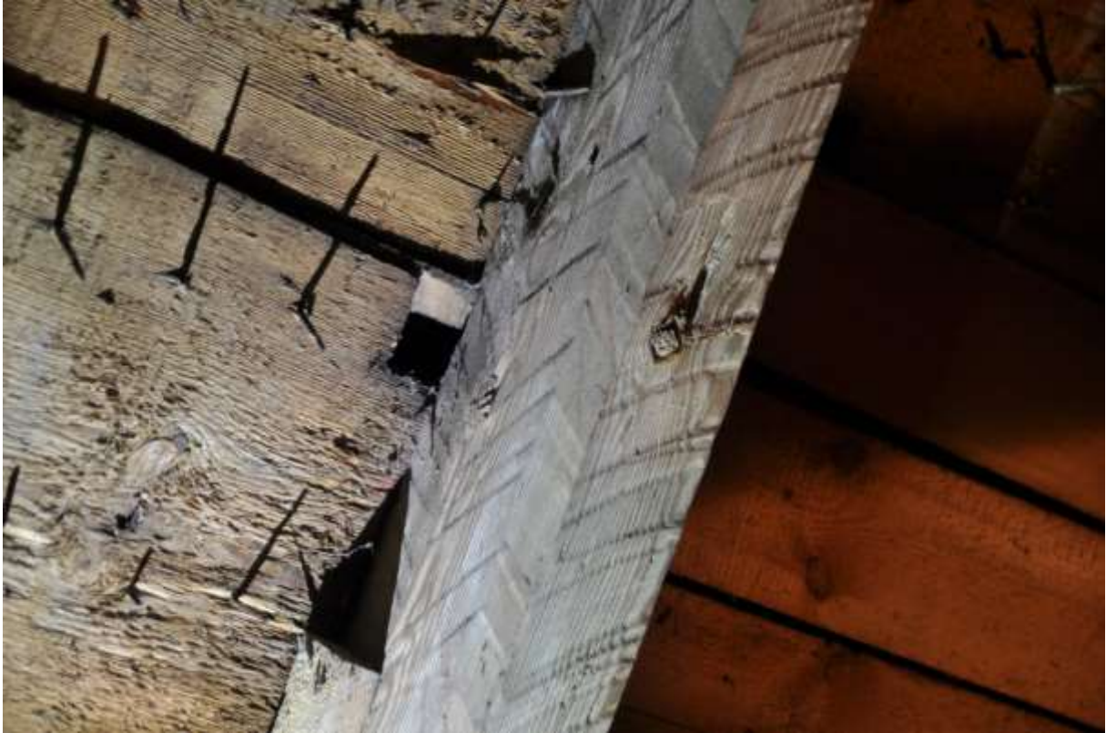
Sprätthuggning på ett högben, utförd i markant bandformation och fiskbensmönster.
