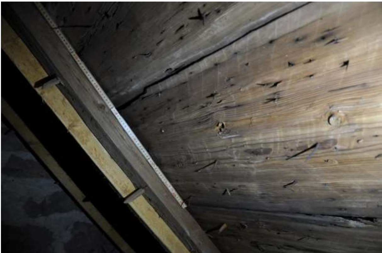
Tidigmedeltida bräda med tydlig sprätthuggning. Brädan är ca 410mm bred på mitten och uppskattningsvis ca 6,5 meter lång.
