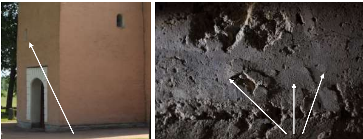
I fönsternischens valv syns vibrations märken från den tidigmedeltida skaven i bruket.
