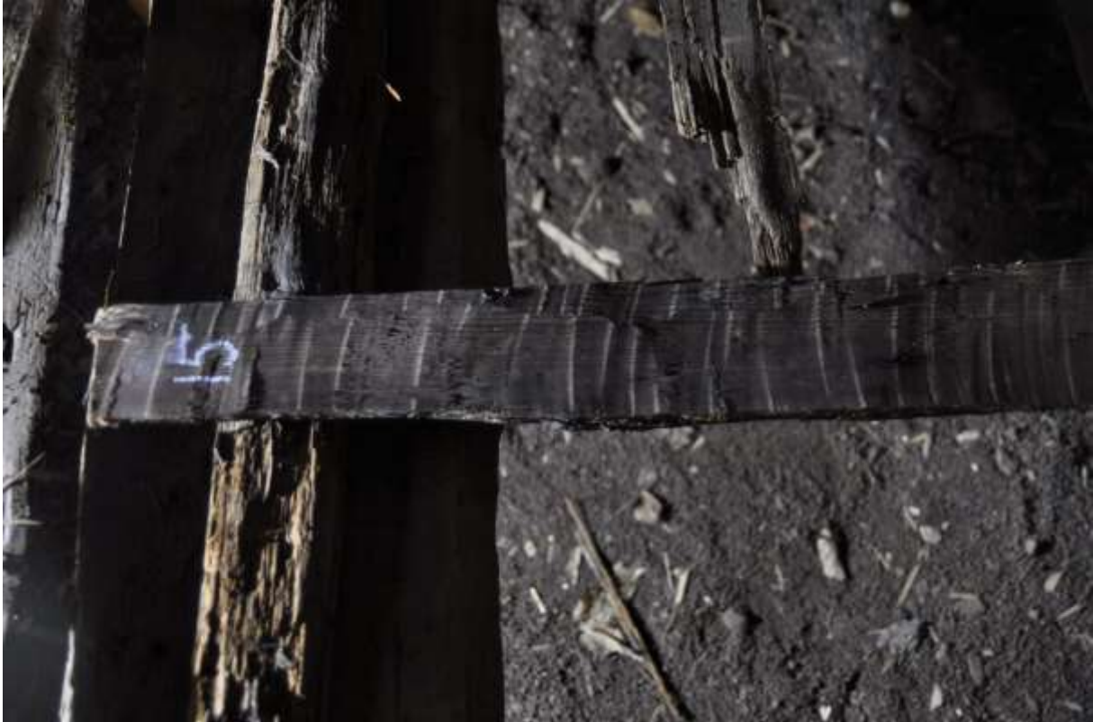
Brädorna numrerades. Se den mycket fina sprätthugningen som är gjord vinkelrätt mot fibrerna. Ett säkert tecken på att denna bräda är tidigmedeltida.
