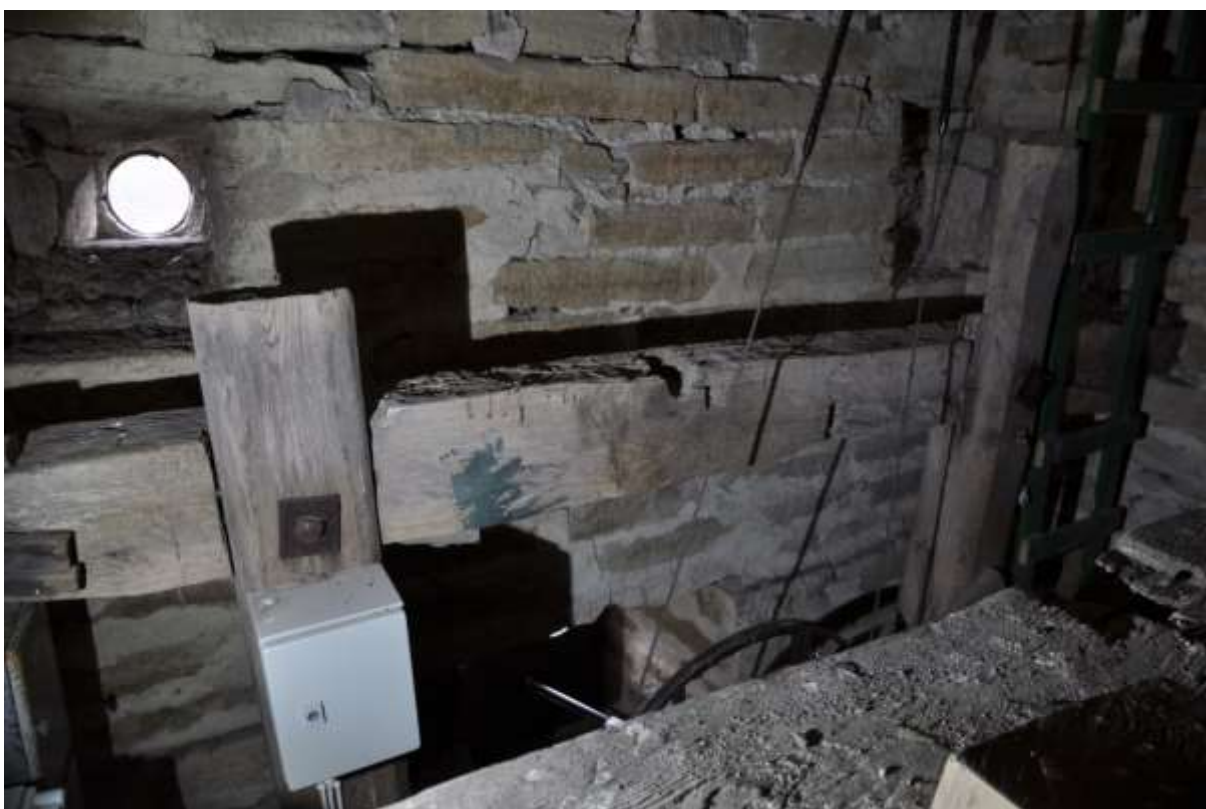
Gammal ekbjälke som i mitten har urtag för en tidigare klockupphängning. Uppe till vänster syns en av de små öppningarna i tornmuren.
