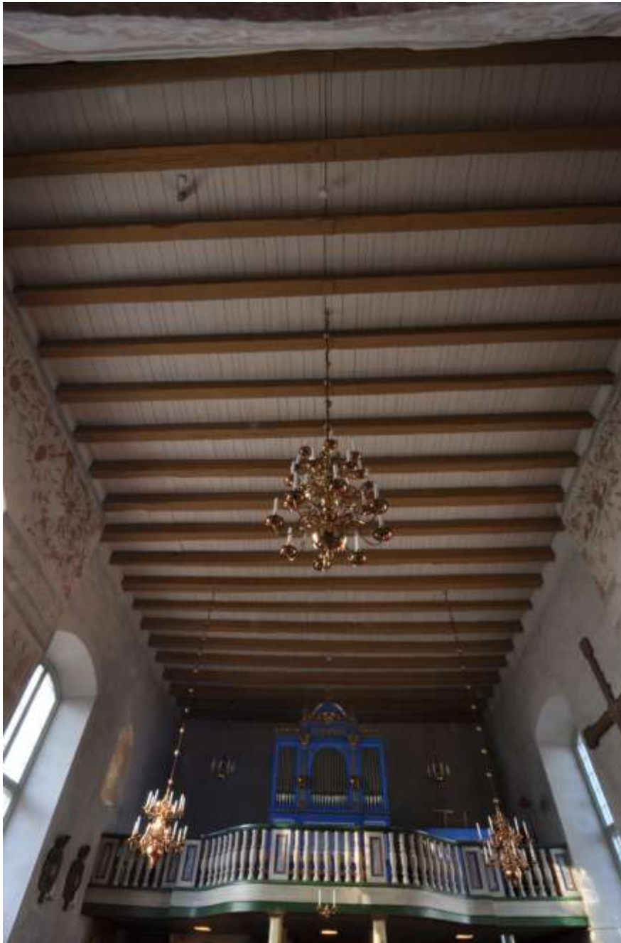
De tidigmedeltida bindbjälkarna är synliga från kyrkorummet, men numer med ett platt trätak ovanpå.
