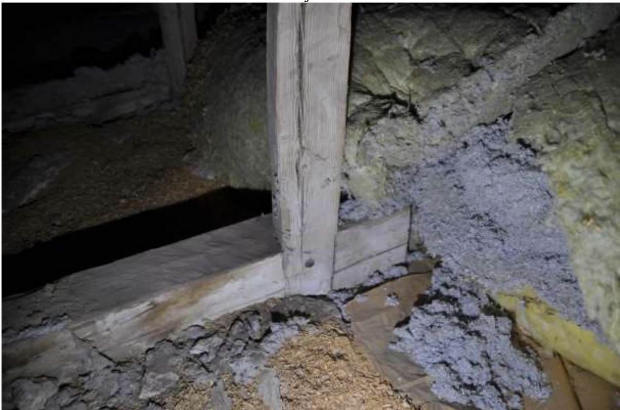
Stickstolpens möte med högbenet fixeras med en dymling. Här syns också den förmodligen avkapade bindbjälken.
