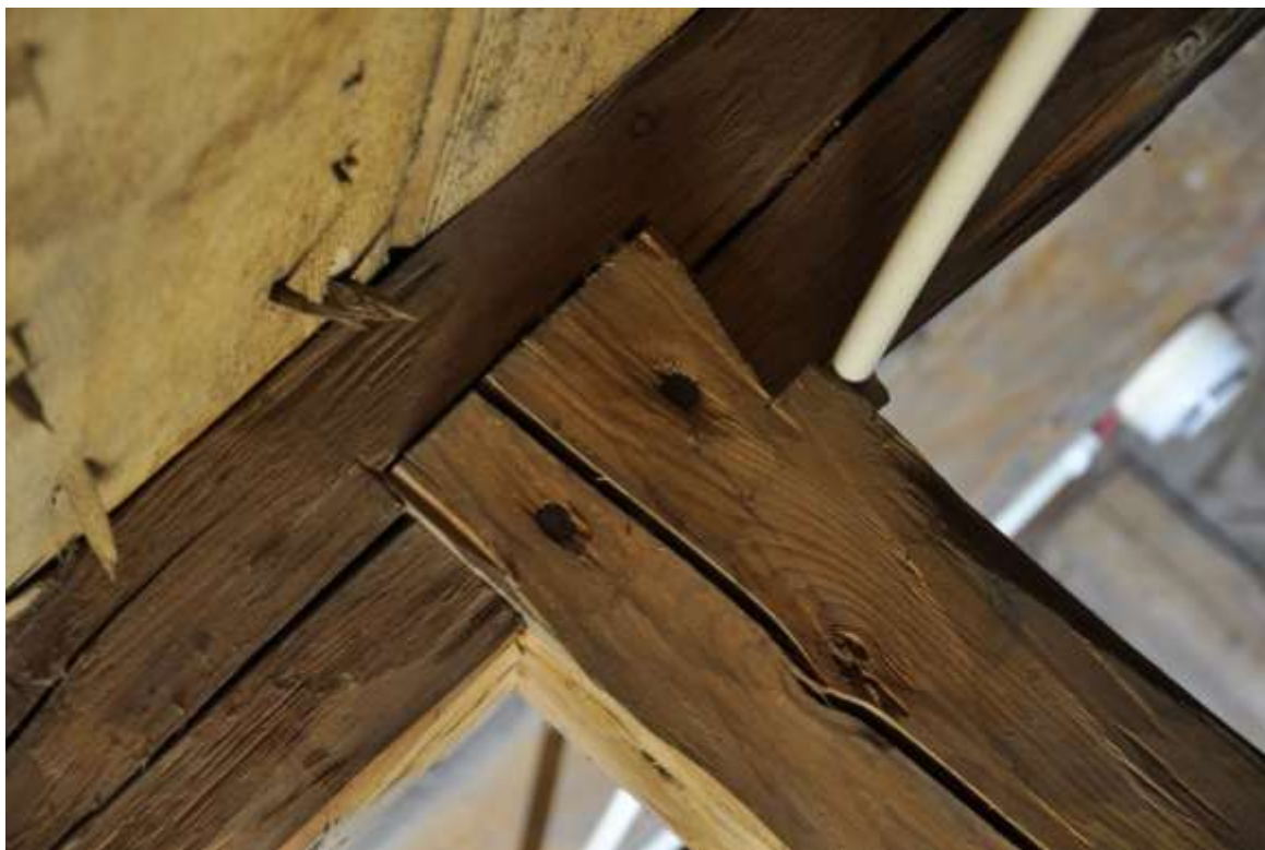
Ett sentida taklag med knutpunkter som är markerade med blyerts och sågade.
