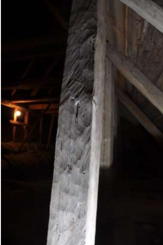
Virket är slinthusget, ofta med tydliga drag av sprätthuggning.
