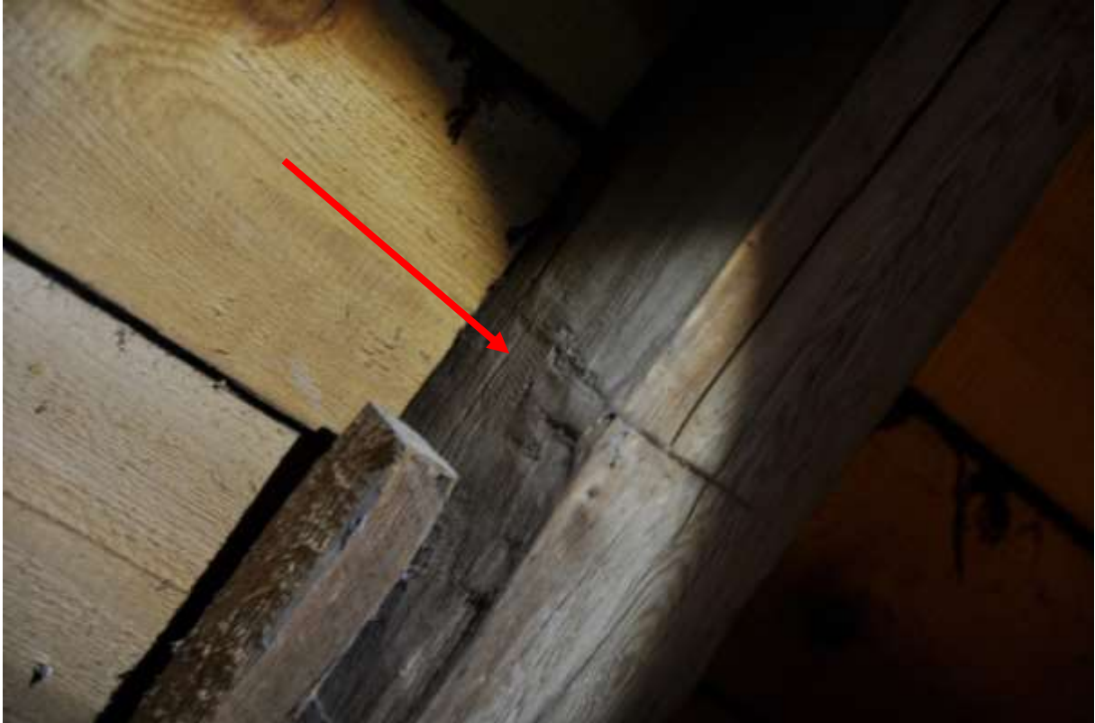
På bilden synd de vibrationsspår som lätt uppstår vid bearbetning med skave (hyvel).
