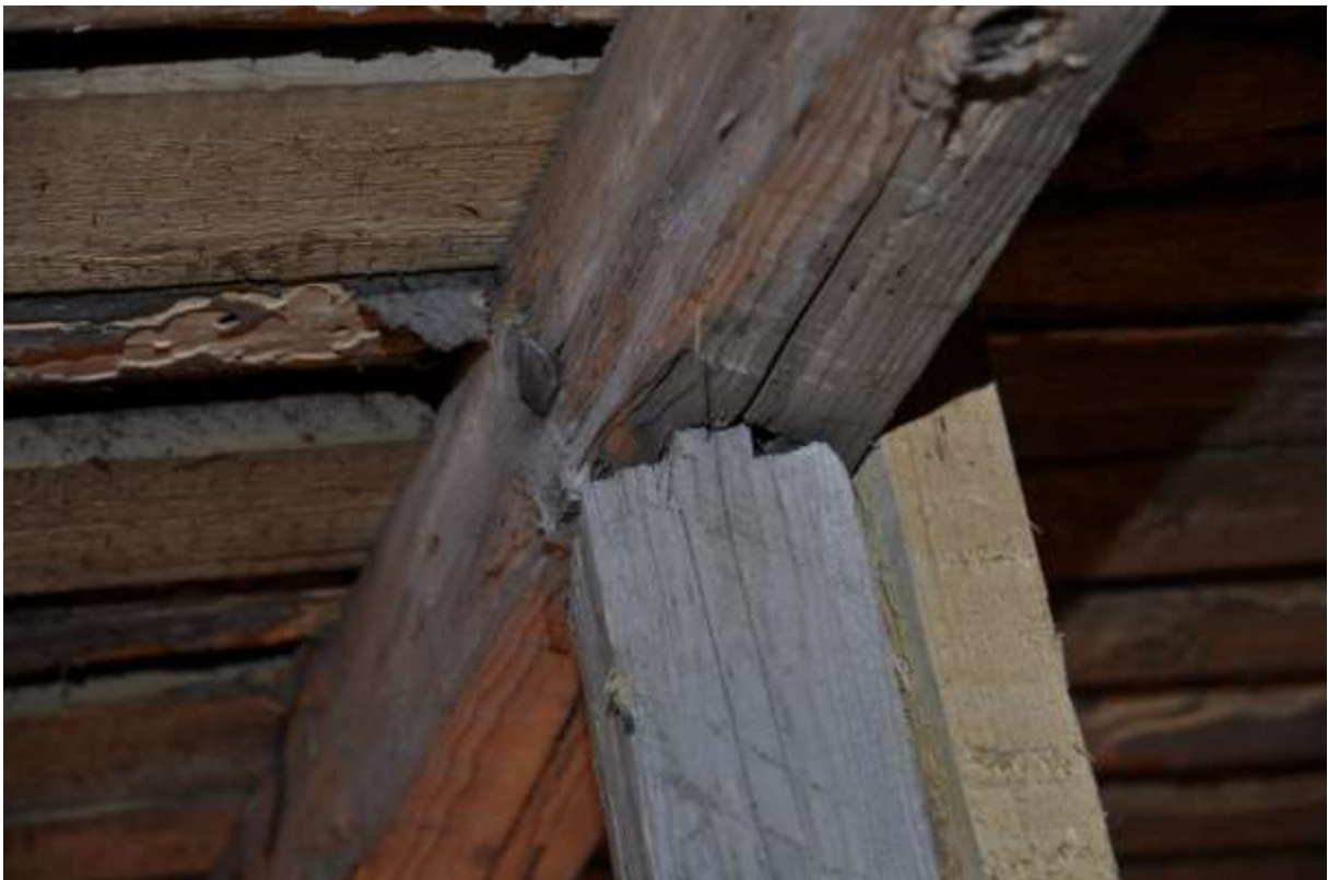
Stödben möter högben med tapp, tapphål och spik. Till höger om stödbenet syns en påspikad förstärkning.
