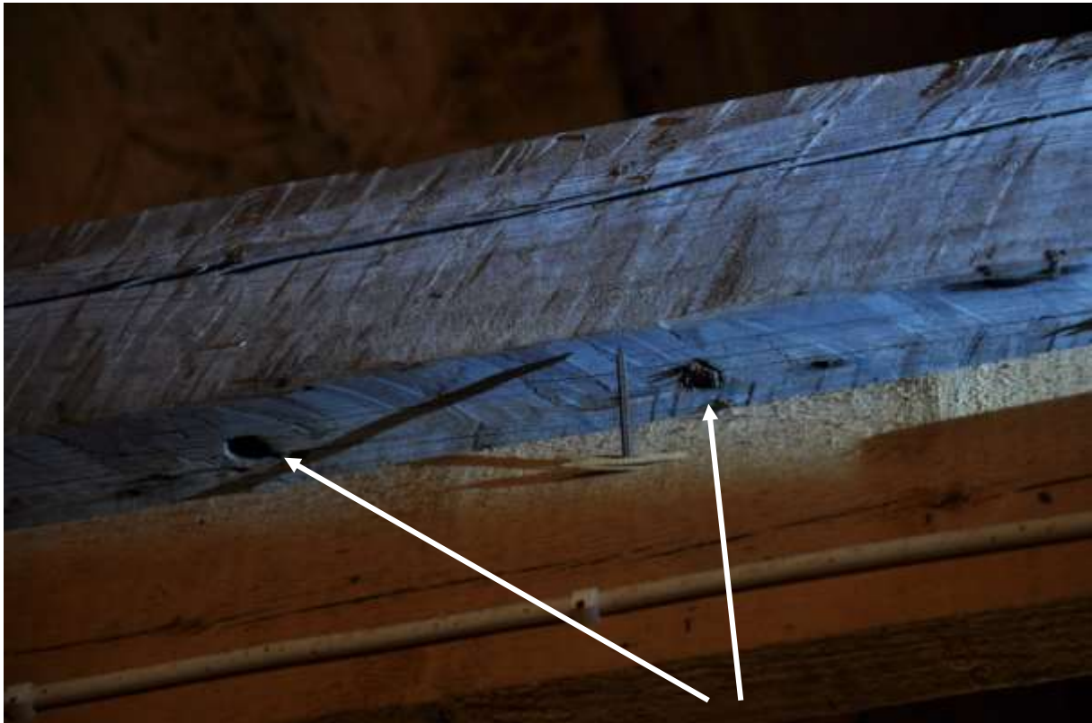
Ursprungligt högben. Sprätthugget till skarp kant och med dymlingshål för att fästa takbrädorna.
