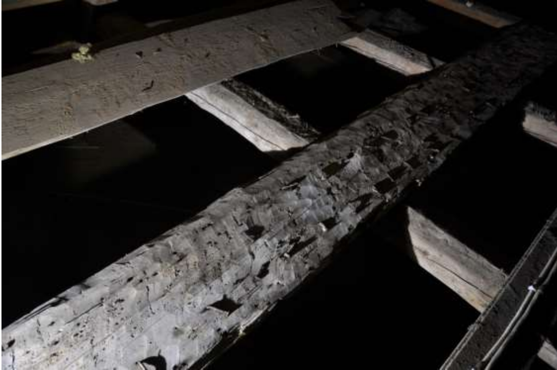
Tidigmedeltida yttertaksbräda med markant sprätthuggning, gjord med en liten kortegged yxa. Ett stort antal spik från yttertakstäckningen finns kvar.
