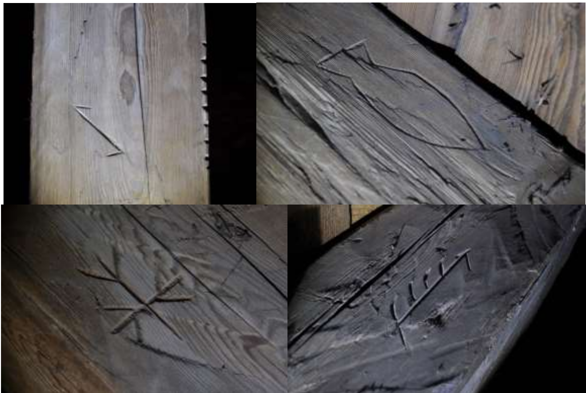
Några exempel på det intressanta märksystemet. På bilden överst till vänster syns nio jack i bjälkens kant. Kanske timmermannens sätt att hålla räkningen på något i byggprocessen.
