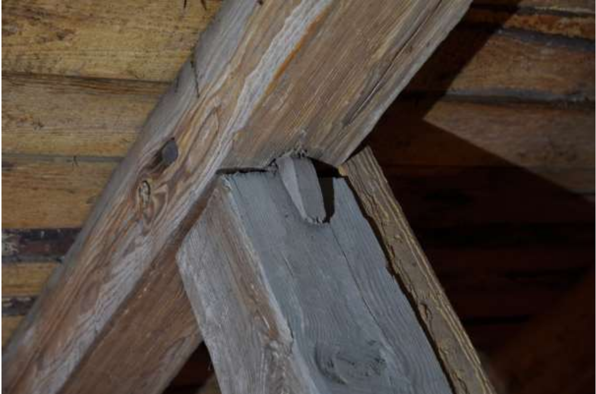
Flera av tapphålen har gjorts för stora och lusats i med en kil.
