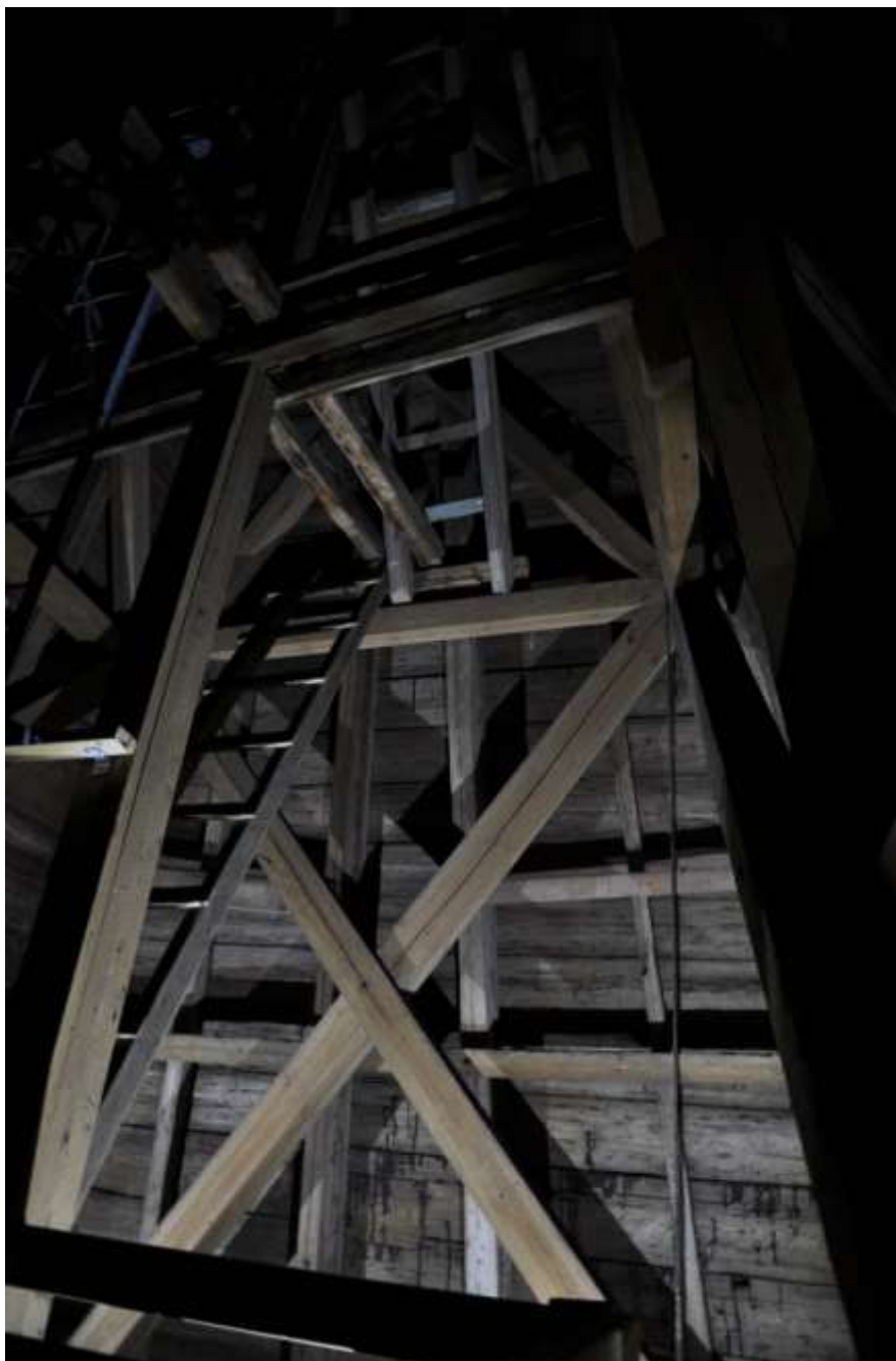
Översiktsbild från tornhuven. Många sentida förstärkningar har gjorts men längst bort i bild syns den ursprungliga konstruktionen med sparrar och taktro. De två stegarna är troligen tillverkade av återanvänt virke från det äldsta taklaget.
