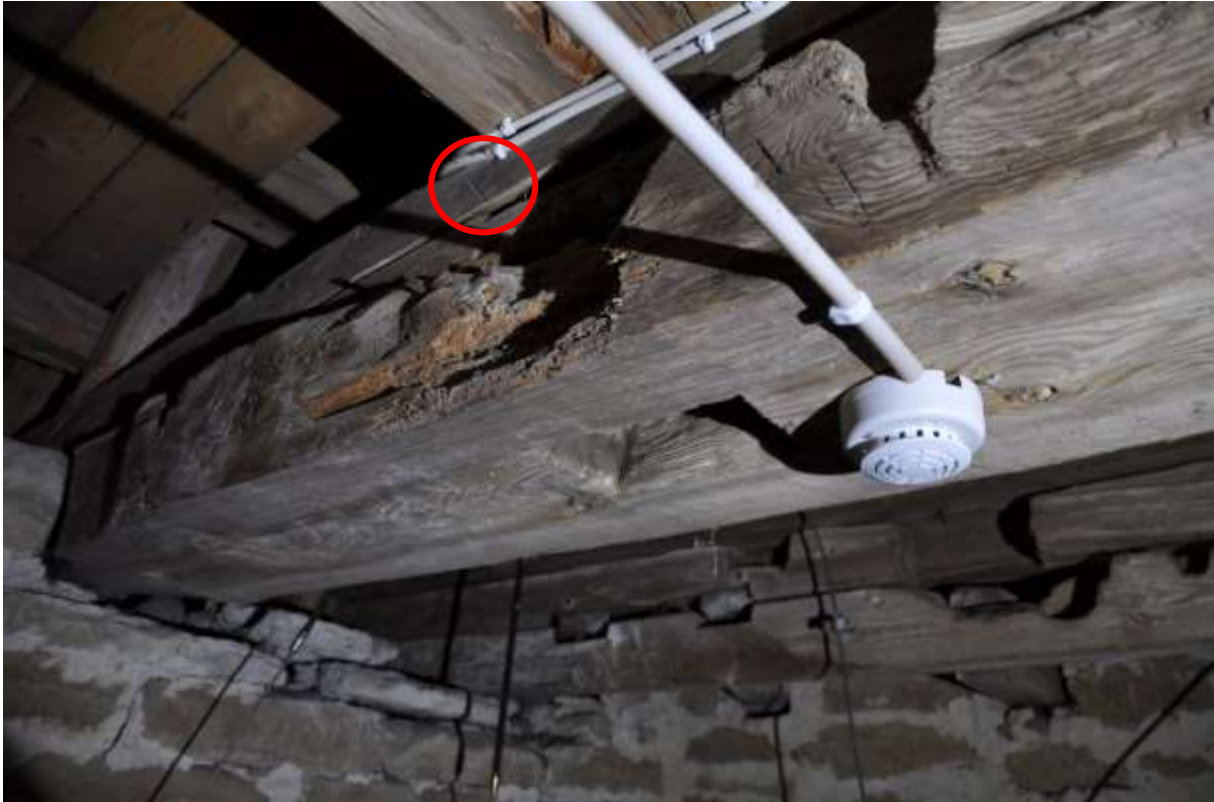
Den mittre bjälken med tapphål i mitten för den tidigare tornspiran. Ovanpå ligger en sekundär bjälke som hör till den nyare tornhuven. Lägg märke till timmermansmärkningen.
