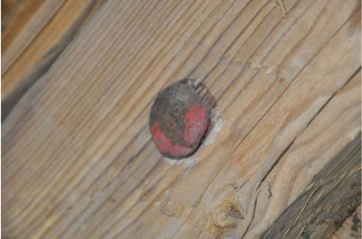
Rödmålad spikskalle. Under spiken syns rester av vit färg.
