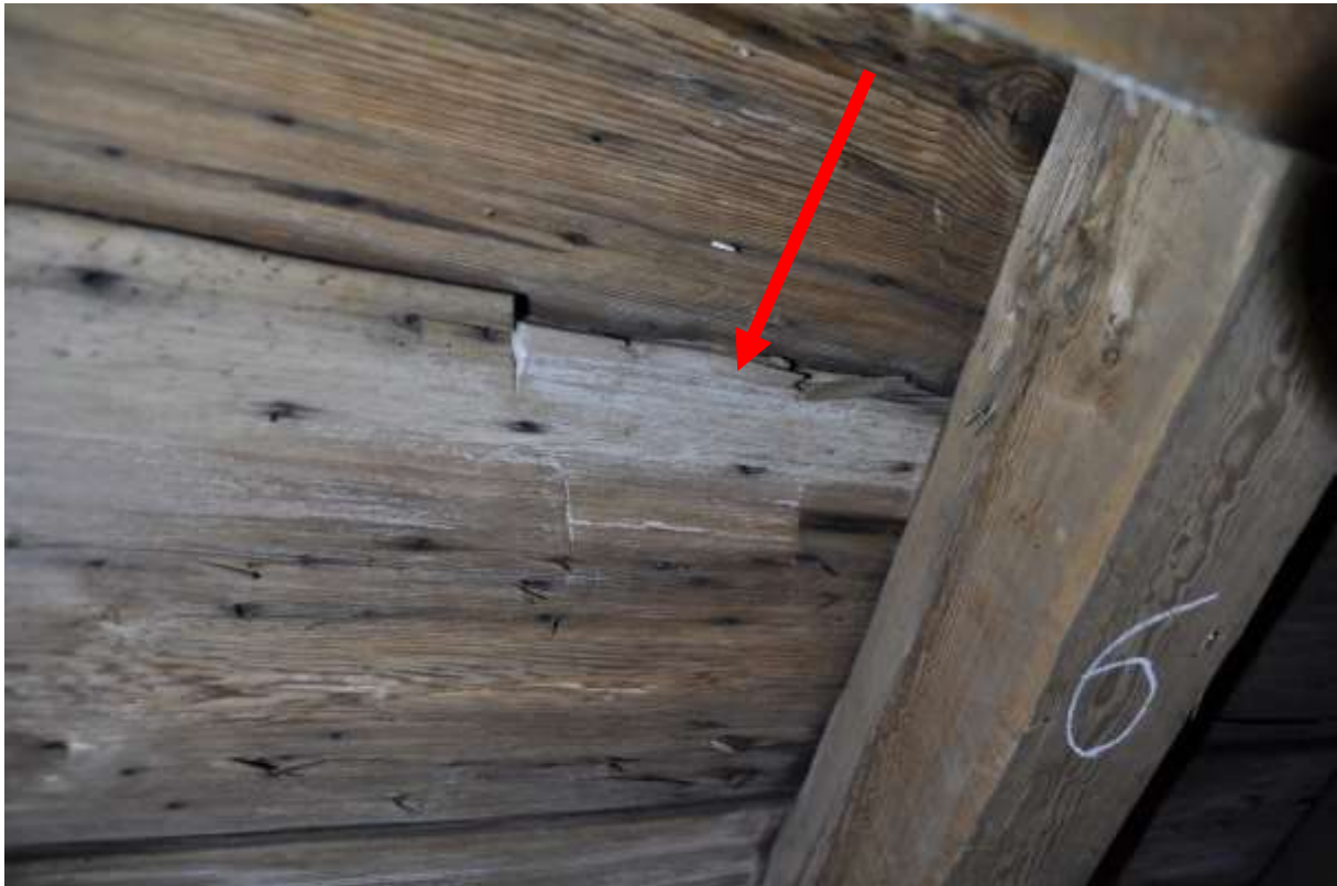
Vit färg på undertaket tyder på att det är ursprungligt.
