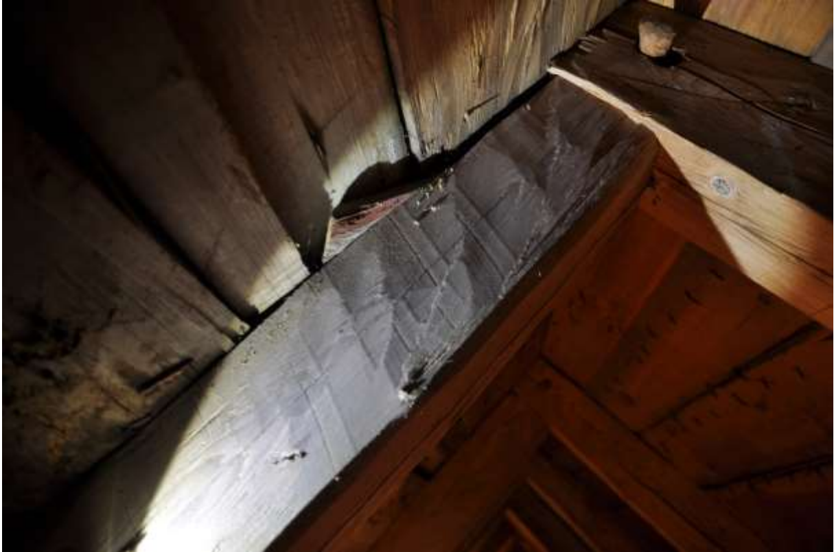
Virket är skrätt nästan vinkelrätt mot fibrerna.
