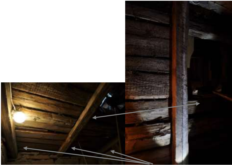
I det översta bjälklaget är alla tre bjälkarna ursprungliga.
