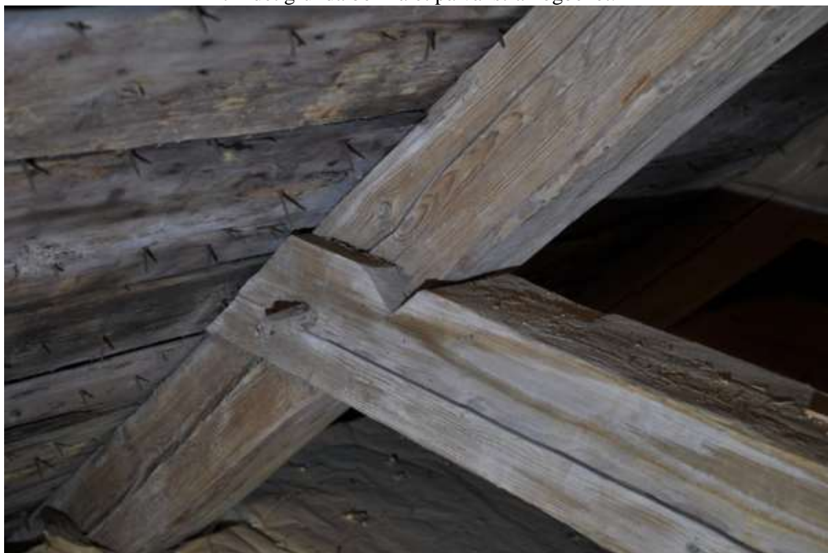
Hanbjälkens infästning i högbenet består av en bladning med nacke.
