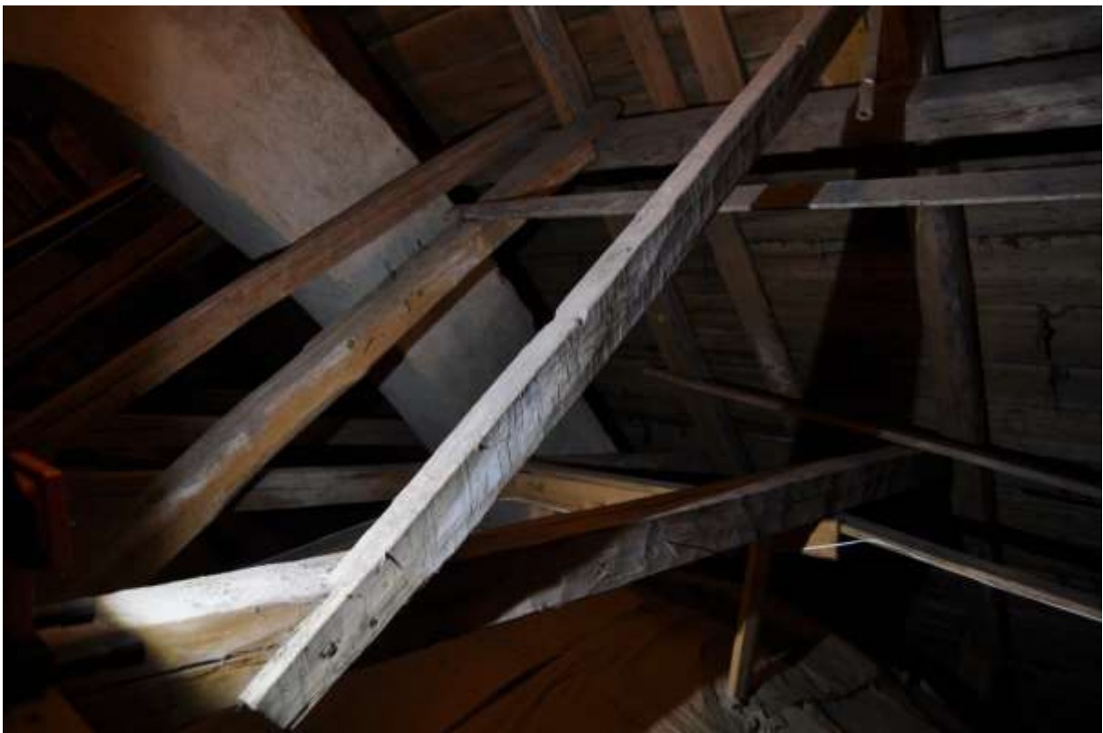
Ett återanvänt stödben, ursprungligen från det tidigmedeltida taklaget. Sprätthugget, och med en helt annan färg än strävorna i bakgrunden.
