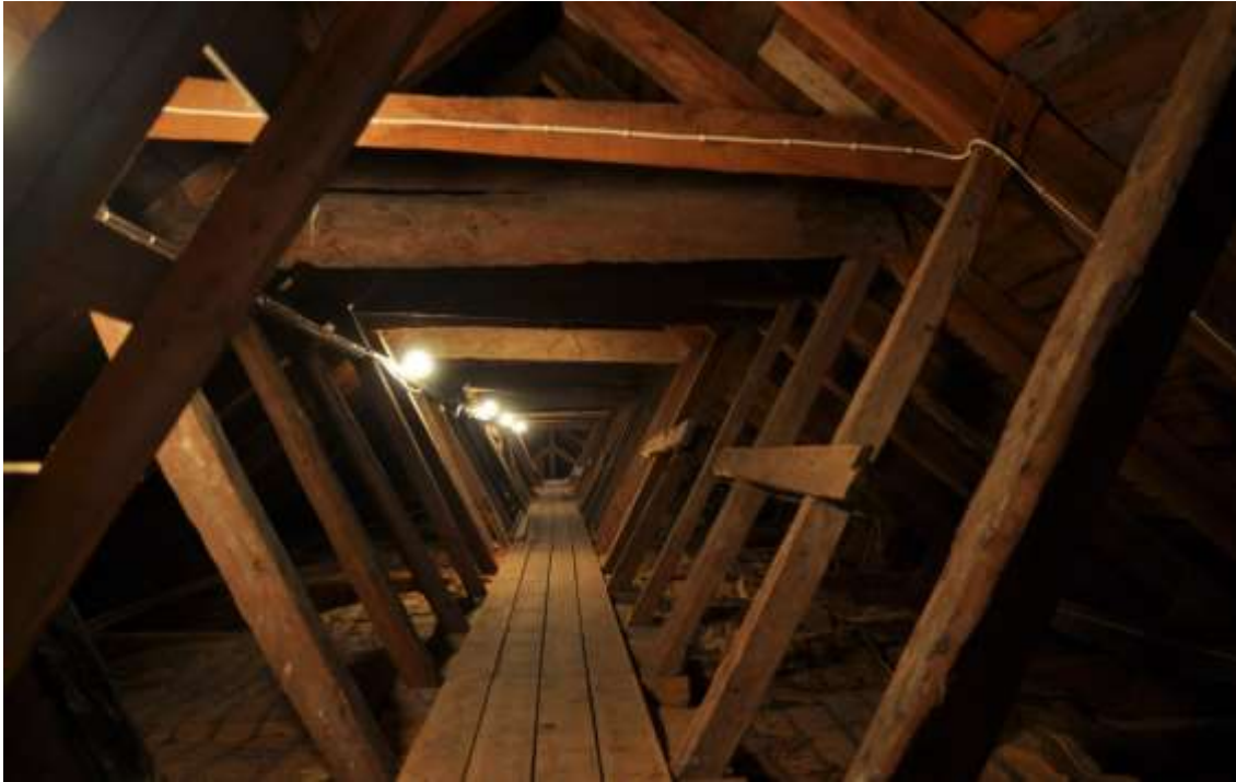
De stödben som finns på var sida om bryggan består av återanvänt virke.
