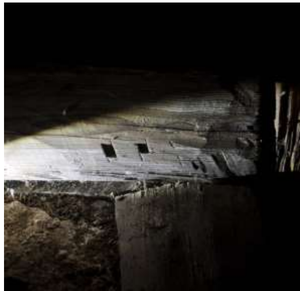
Två olika typer av timmermansmärkning.
