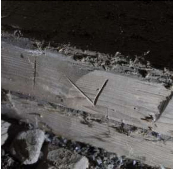
Två olika typer av timmermansmärkning.
