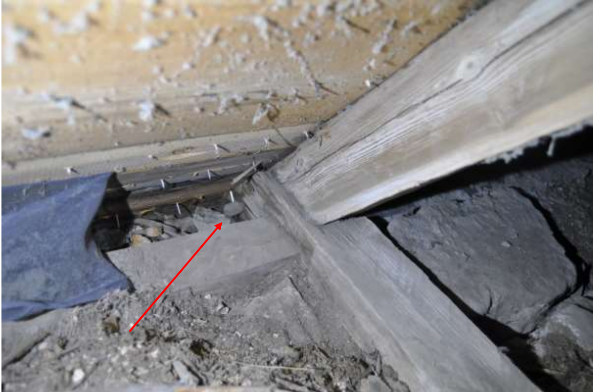
Takstolarna står på ett yttre remstycke. I knutpunkten bindbjälke/högben syns en dymling med täljd skalle.
