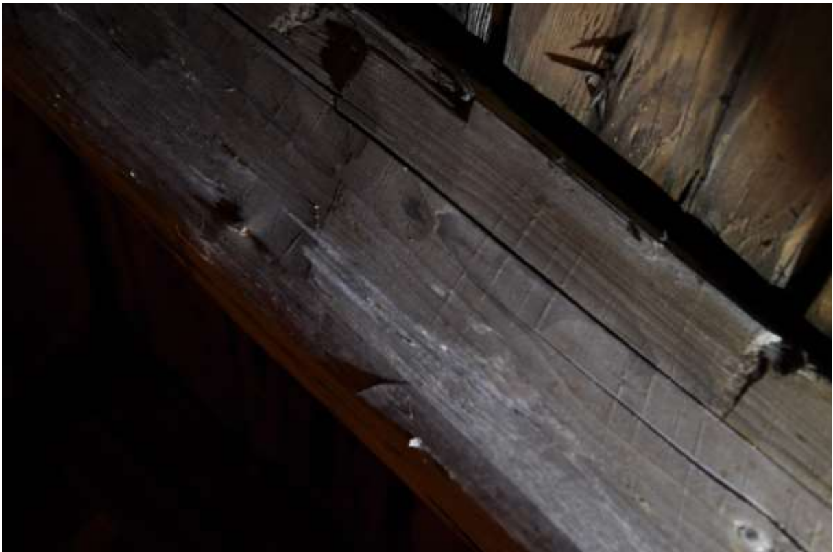
Skador i yxans egg ger repor som visar att virket bearbetats tvärs fibrerna.
