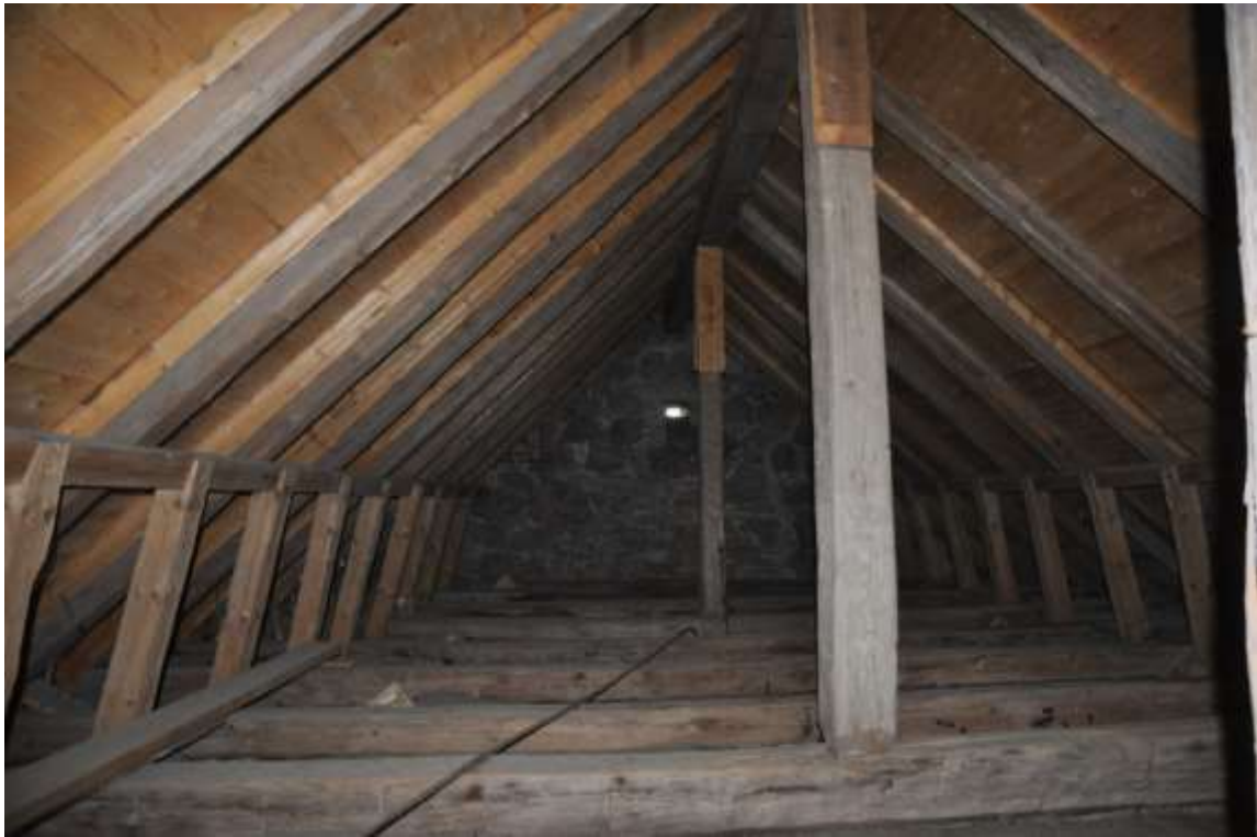
Långhuset har någon gång fått ett helt nytt taklag som nu är kompletterat med sentida förstärkningar.
