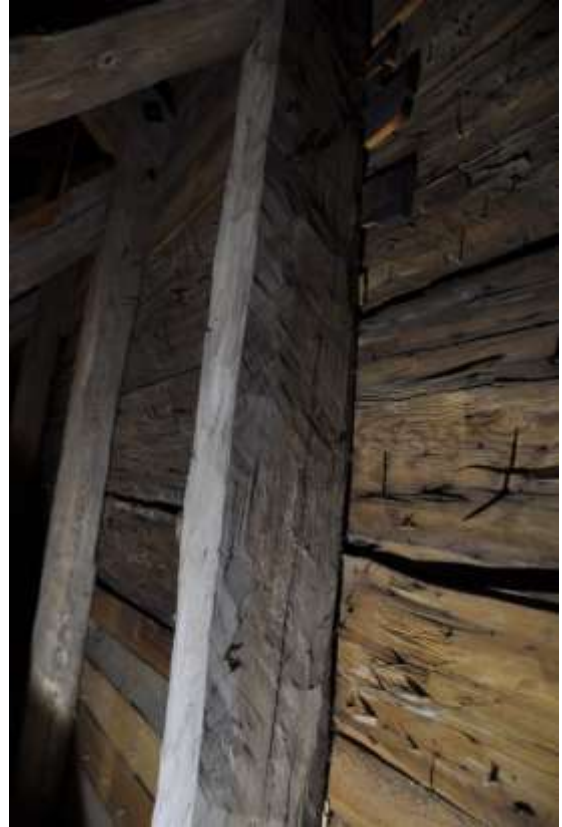
Virket är slinthusget, ofta med tydliga drag av sprätthuggning.
