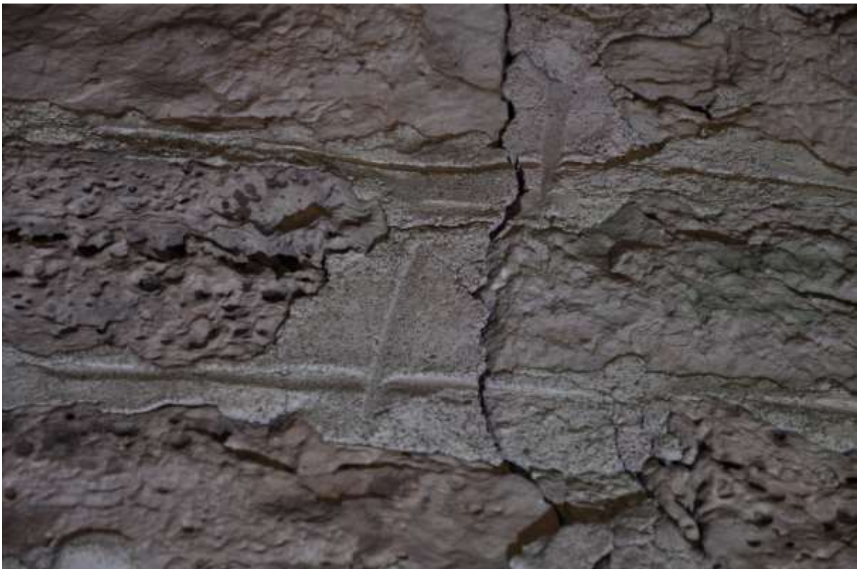
Ritsade fogar i tornets murverk.
