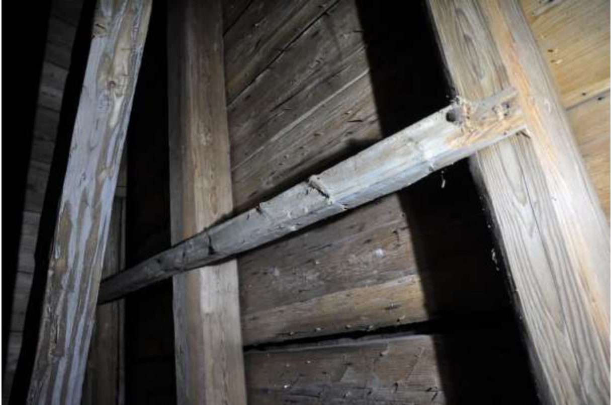
Sparre som troligen utgjort upplag för ställningsplank. Biten är framkluven ur ett grövre ämne som varit sprätthugget och bearbetat med skave. Ett antal mindre bitar sitter på olika platser i tornhuven.
