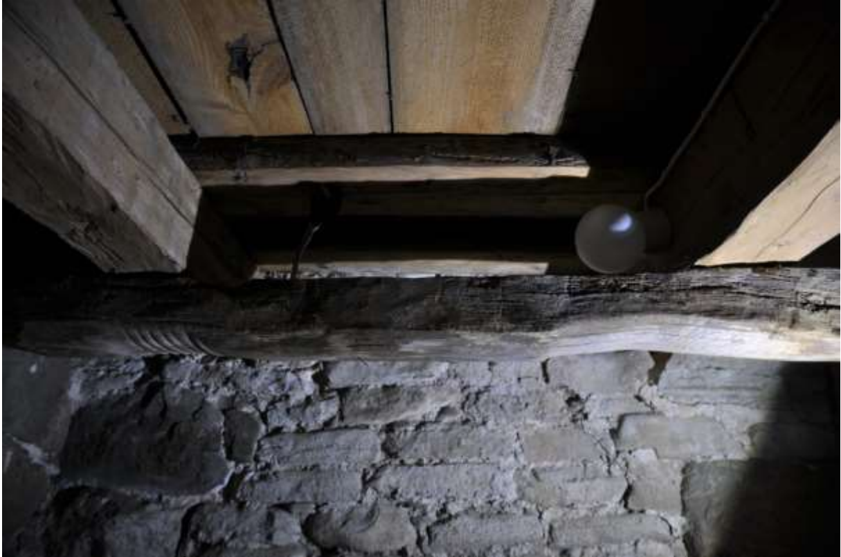
Återanvänd ekbjälke med tydligt slitage på undersidan.
