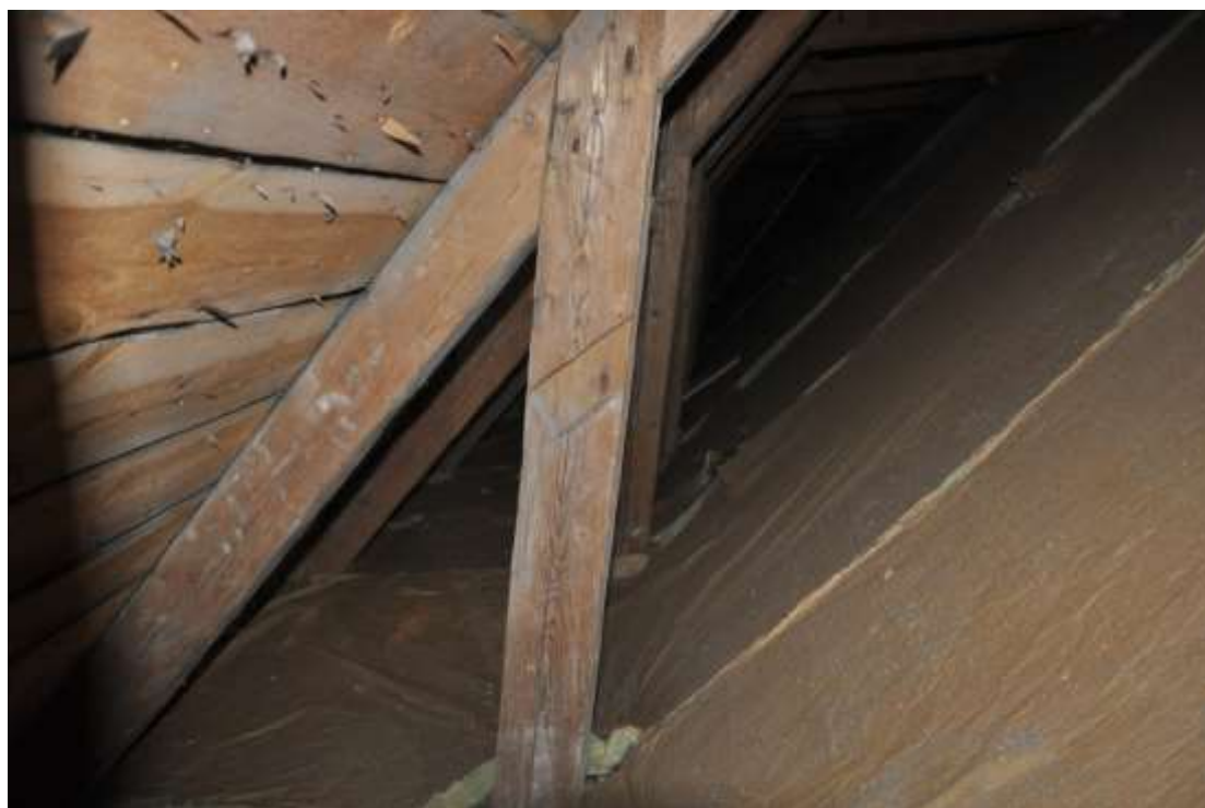
Möjligen en äldre återanvänd del. Knutpunkten kan också vara en rest av en tidigare valvkonstruktion eller en tillfällig byggnadsteknisk konstruktion.
