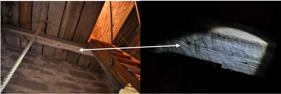
En ursprunglig bjälke med sprätthuggning, sedd från tornkapellet.
