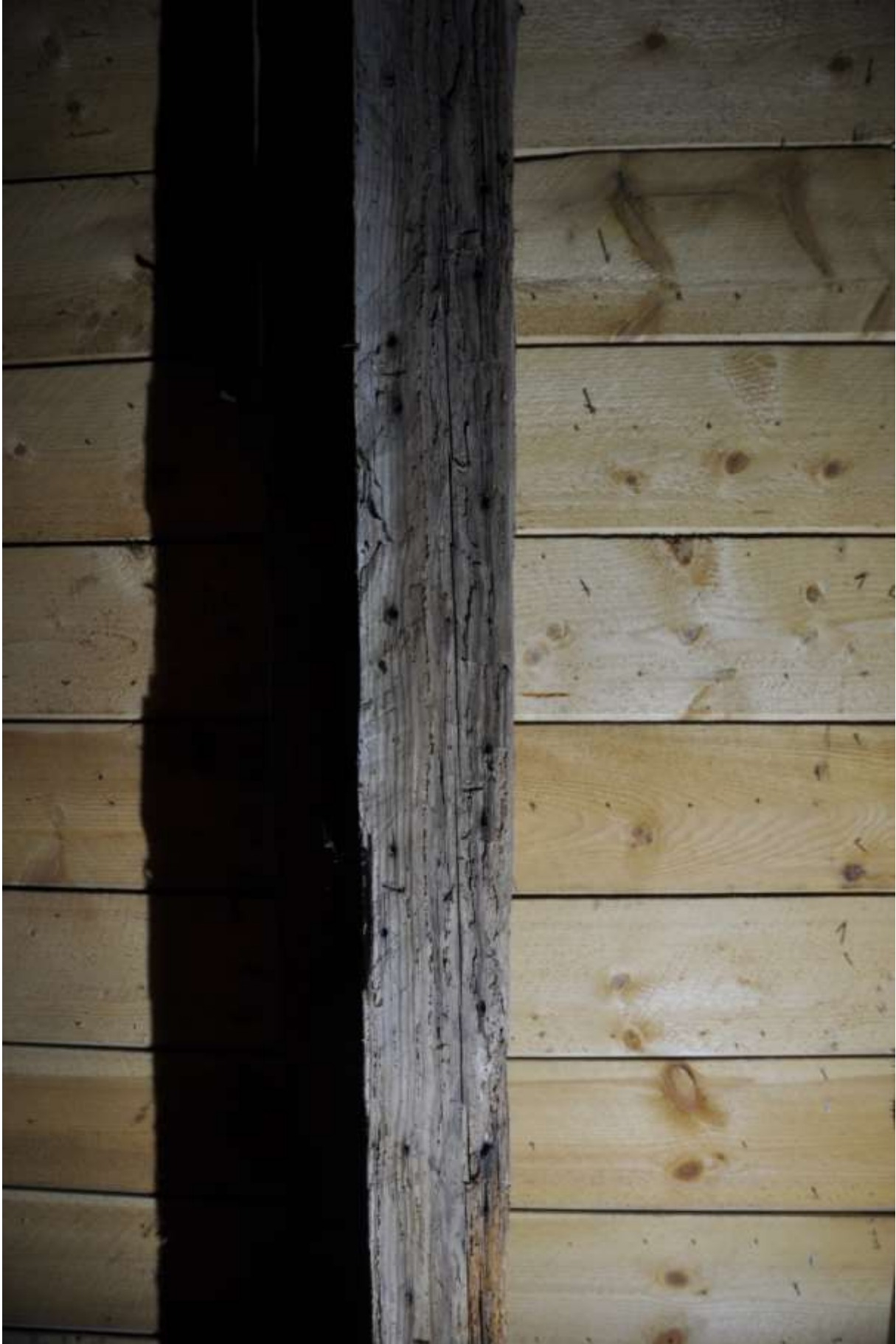
Ett av högbenen är återanvänt. Det har spikhål på sin insida.
