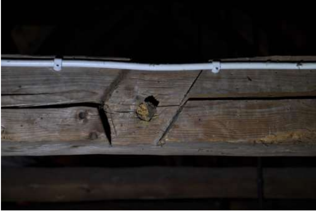
Knutpunkt med nacke. Dymlingen sitter fortfarande kvar.
