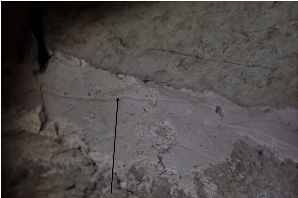
Färgrester och ristningar i trappan.
