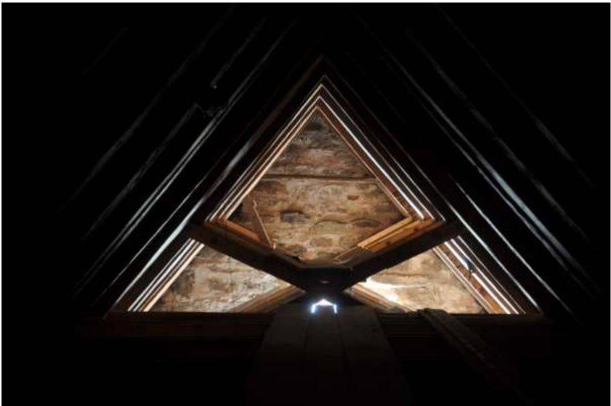
Längst bort syns takstolar med saxsparrar över koret, dendrodaterade till ca 1575.
