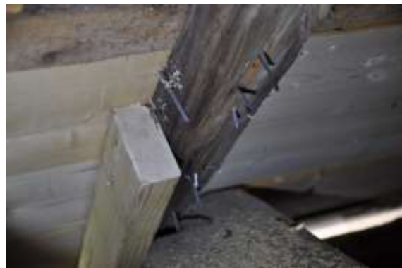
Mycket ovarsamma lagningar med alldeles för långa spik och skruv.
