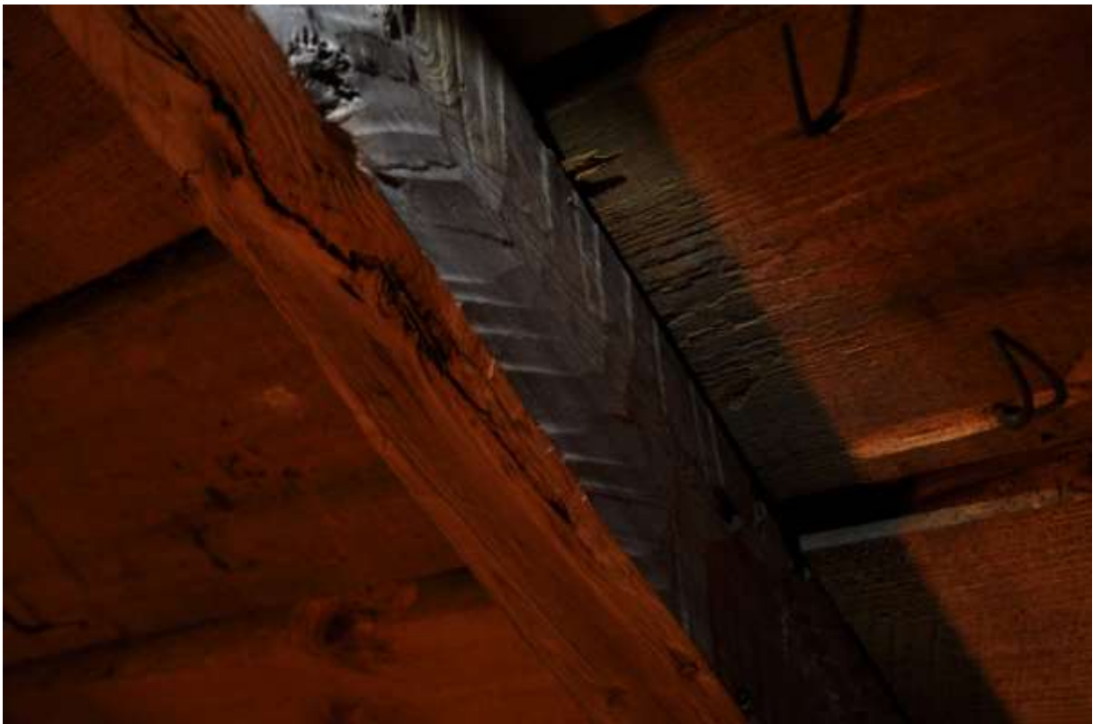
Sprätthuggning på högben. På undersidan syns att trädet haft en gammal skada.
