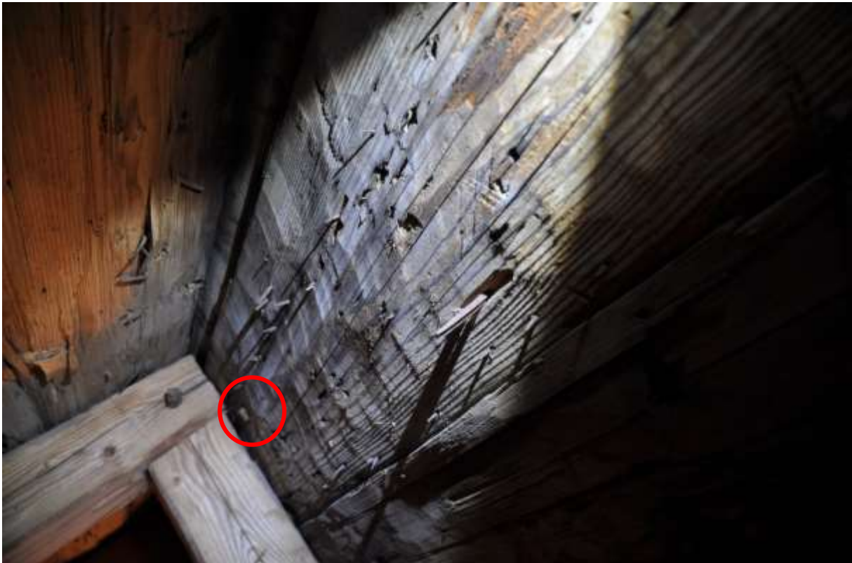
Vissa av takbrädorna har markant språthuggning och är troligen från tiden när kyrkan uppfördes. Brädorna bär spår av att tidigare varit fästa med tränaclar.
