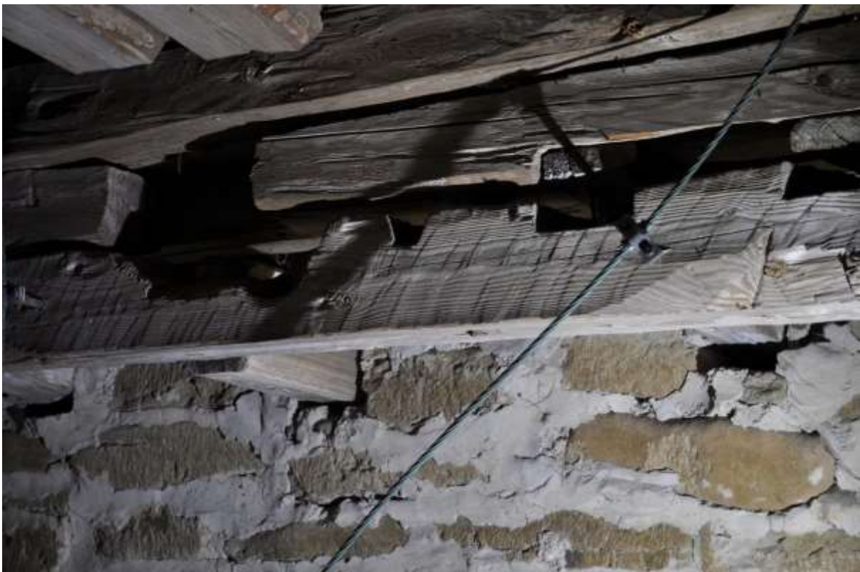
Sprätthuggning på den nedre bjälken.
