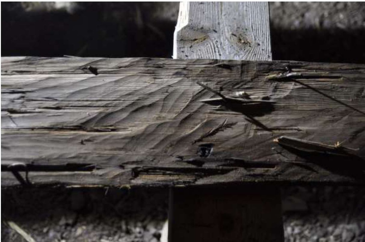
Här har en skave använts diagonalt och tvärs fibrerna, kanske för att justera en ojämnhet vid monteringen av brädan. Notera reporna från en skada i yxans egg.
