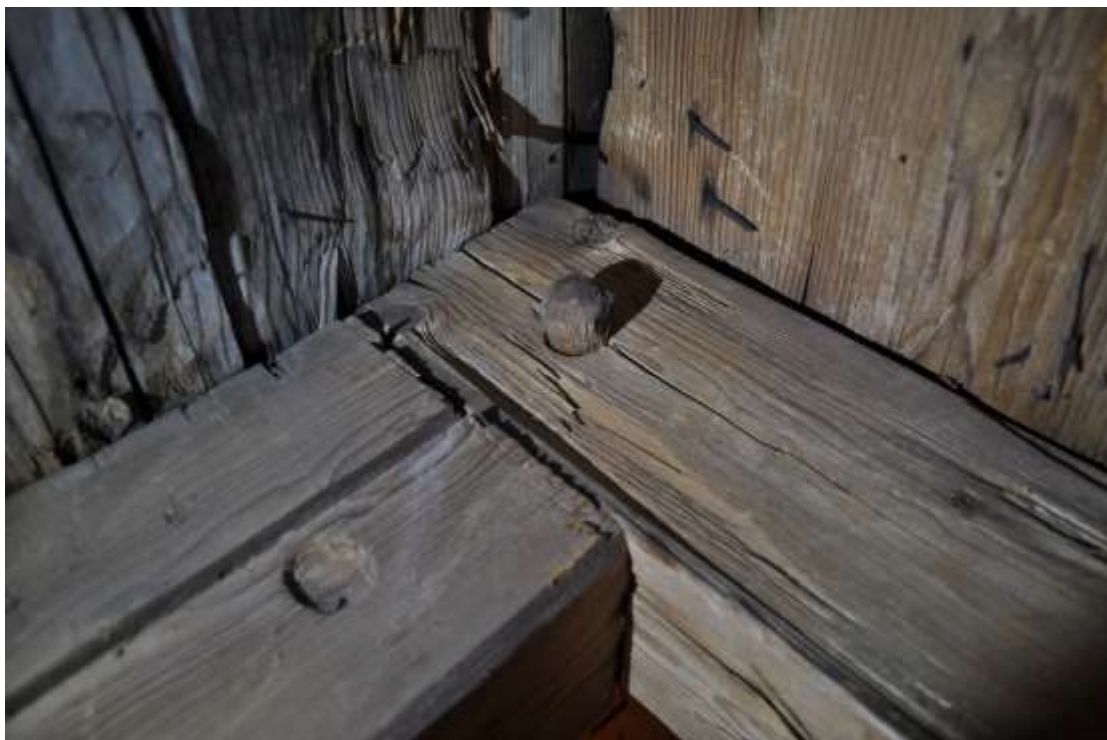
Högbenens sammanfogning i nock med tapp och slits samt en fint täljd dymling. Lägg märke till det grunda borrhålet på vänstra högbenet.
