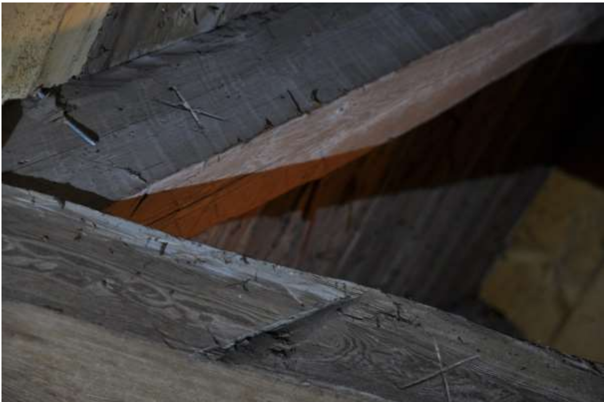
Märkning med "X" på högben och hanbjälke. Hanbjälken har mer utpräglad sprätthuggning. Nederst i bildens mitt, spår av ett för djupt inhugg vid grovbearbetningen av timret.
