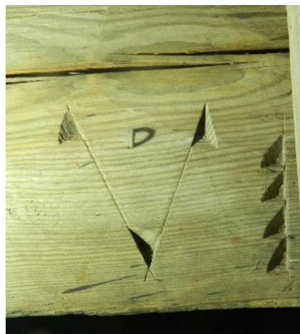
I klocktornet finns medeltida bjälkar men ingen sprätthuggning. Denna märkning är förmodligen gjord på 1700-talets slut. En extremt välgjord timmermansmärkning finns att avnjuta.
