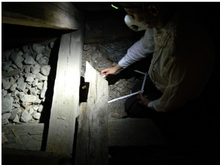
Tomas undersöker en bindbjälke med urtag för enkelt remstycke
