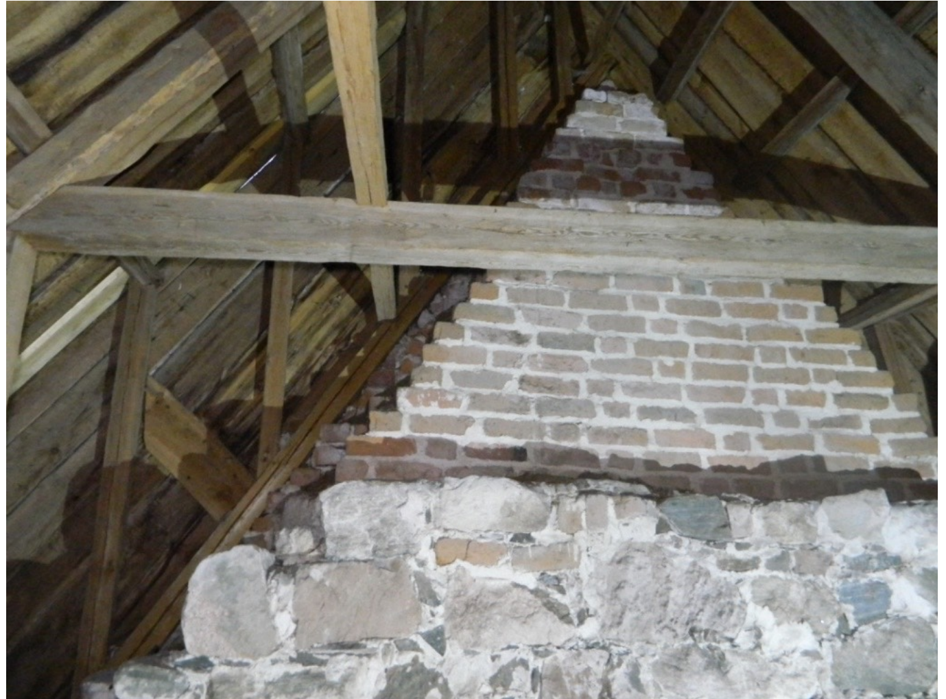
Korets gavel. Ovanför muren ses takstol som kan vara 1400-tal. På denna bild syns hur gaveln blivit påbyggd för att få in både kor och långhus under samma takfall.
