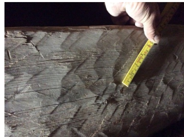
Det finns ett äldre remstycke i långhuset, 12 meter långt och med urtag för en takstol på cc 90 cm.
