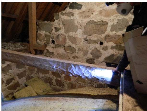
Ett antal bindbjälkar över långhuset är sprätthuggna och återbrukade i detta taklag.
