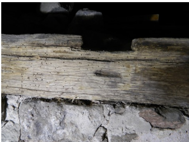
Remstycke av ek med knut för en äldre takstol.
