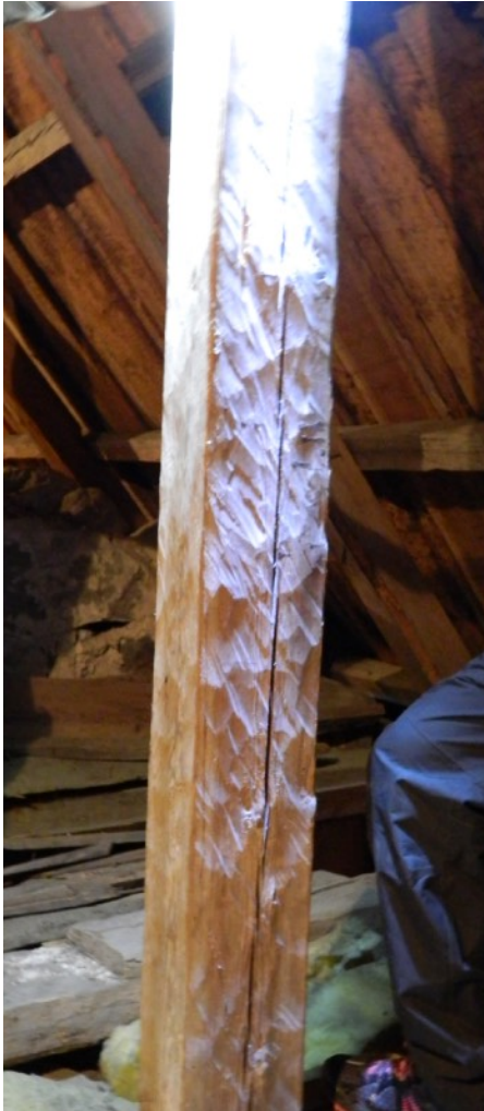
I koret finns flera sprätthuggna delar återväända i den nya gotiska konstruktionen.
