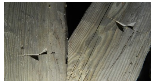
I klocktornet finns medeltida bjälkar men ingen sprätthuggning. Denna märkning är förmodligen gjord på 1700-talets slut. En extremt välgjord timmermansmärkning finns att avnjuta.
