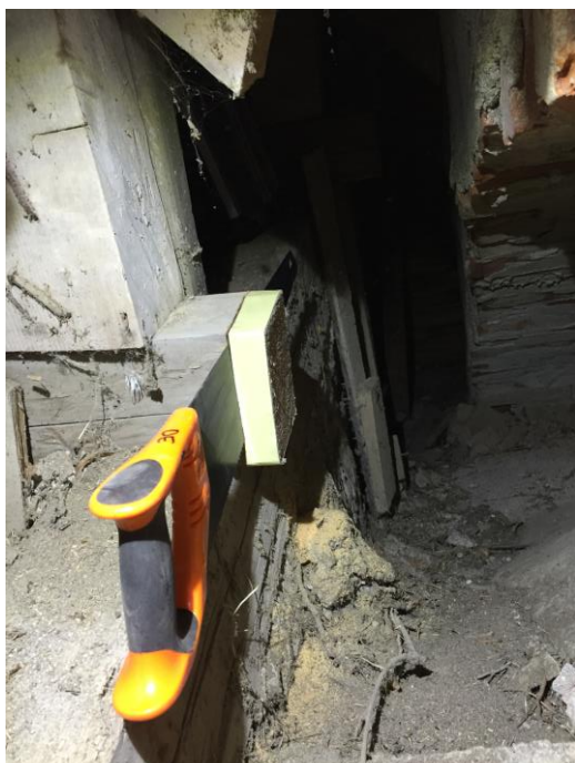
Remstyckena består av mer eller mindre rundvirke och utgör därmed ett bra dendrokronologiskt material. Bilden visar borrhålet för prov nummer fyra.
