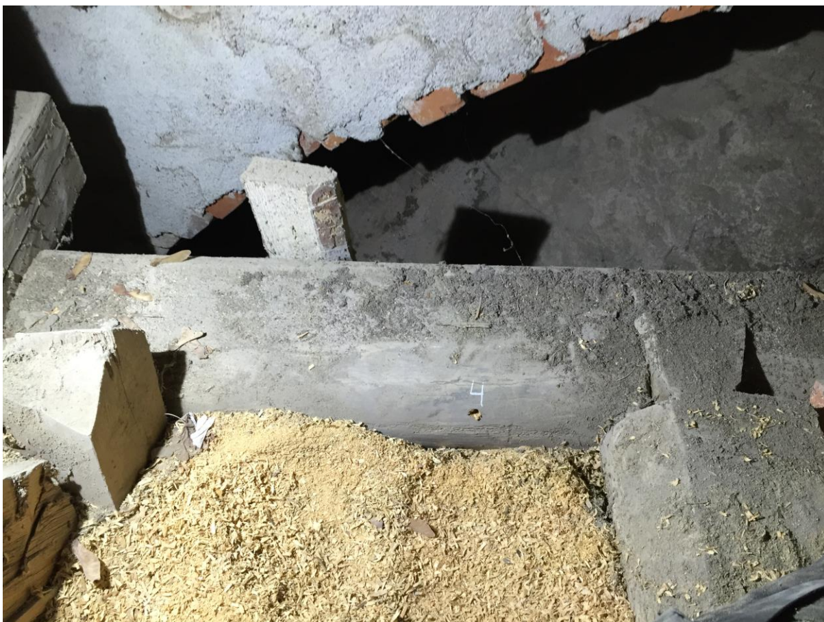
Remstyckena består av mer eller mindre rundvirke och utgör därmed ett bra dendrokronologiskt material. Bilden visar borrhålet för prov nummer fyra.
