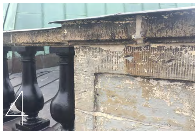
1. Balustraden före rengöring. 2. Balustradens plintar var målade i fasadfärg. Foto: 2012. 3. Numer är plintarna grå. 4. Plint och överliggare efter rengöring.
