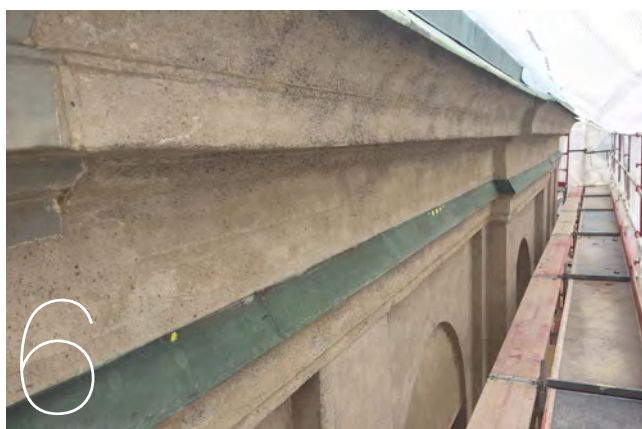
3. Blästring av fönsterblindering. 4. Fasaden efter blästring och innan tvätt. 5. Takfot under pågående blästring. 6. Takfot efter blästring.
