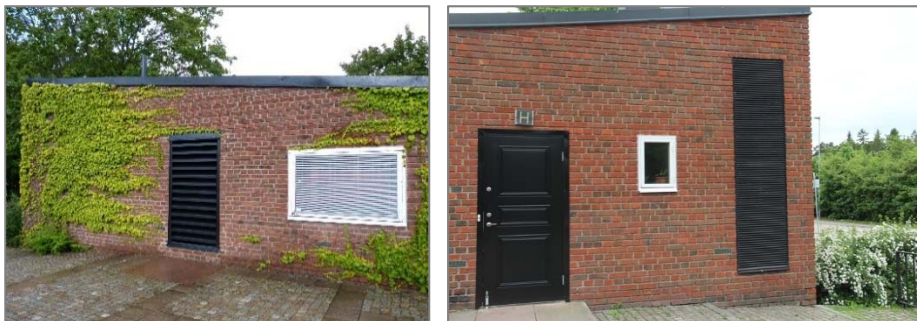
Figur. Nyttillkommet galler för luftintag ersatte tidigare dörröppning. Foto: Helén Sjökvist.
