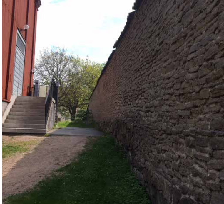
Muren mot Örlogshamnen renoveras. Foto Michaela Linge
