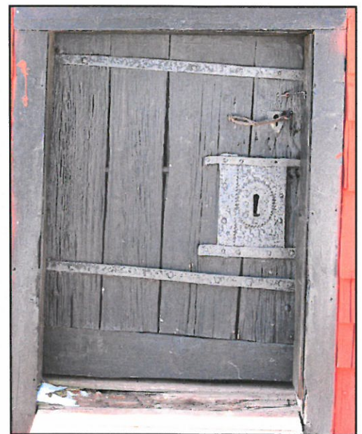
Boddörren har ett medeltida utseende med sina grova plank och sitt smide. Det tunna fodret är sentida. Dörren är även påbyggd i nederkant, troligen vid flytten kring 1914. Tröskeln var tidigare mycket högre, se foto sidan 9.
