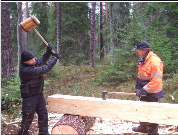
Klyvning och tillverkning av taktro.
