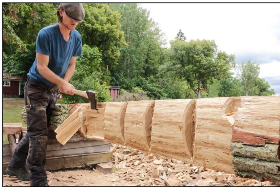
Frej Wike klamphugger ekstocken. Därefter bilas ytan slät i vinkel på ögonmått
