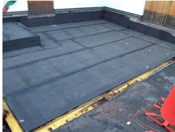
Tätning av fuktskada.
