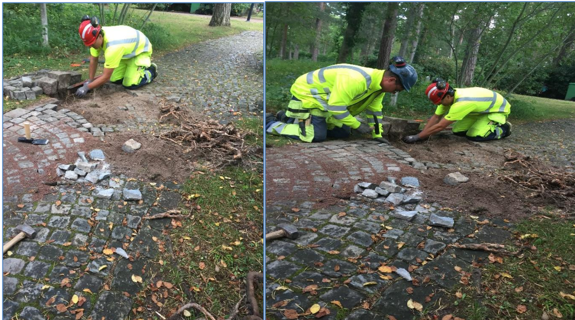
Tillgänglighetsanpassning av gångar pågår! Rötter plockas bort och stenbeläggningen jämnas till.
