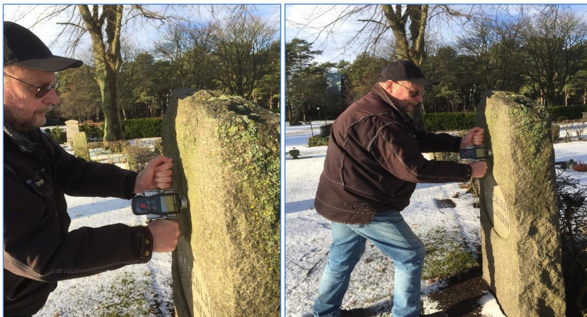
Säkerhetsbedömning av gravstenar ett pågående arbete. På bilderna provtrycker arbetsledaren Ove Nilsson gravstenar som ska tåla ett tryck på 35 kg. Stenar som inte klarar detta krav läggs ned vid gravplatsen som skyltas. Eftersom gravstenen är enskild egendom kontakter vi gravrättsinnehavaren och rekommenderar att hen kontakter valfritt stenhuggeri som kan hjälpa till med att dubba och resa stenen på nytt.
