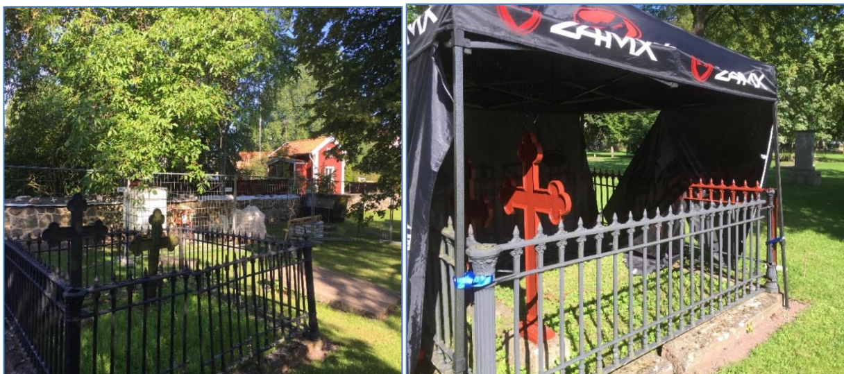
Pågående renovering av gjutjärnsstaket och kors under 2017-2018.
