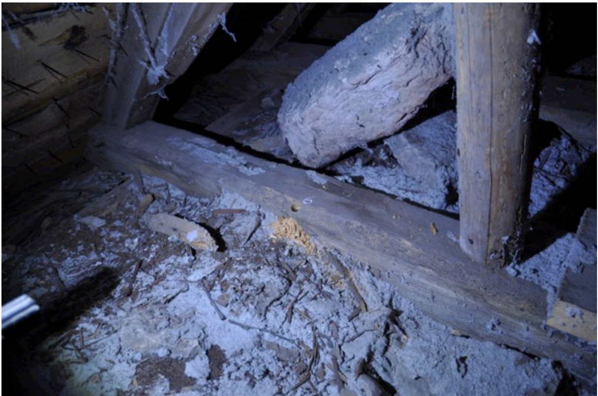
Borrprov sex i bindbjälke elva från väster, daterar det äldsta taklaget till 1131.
