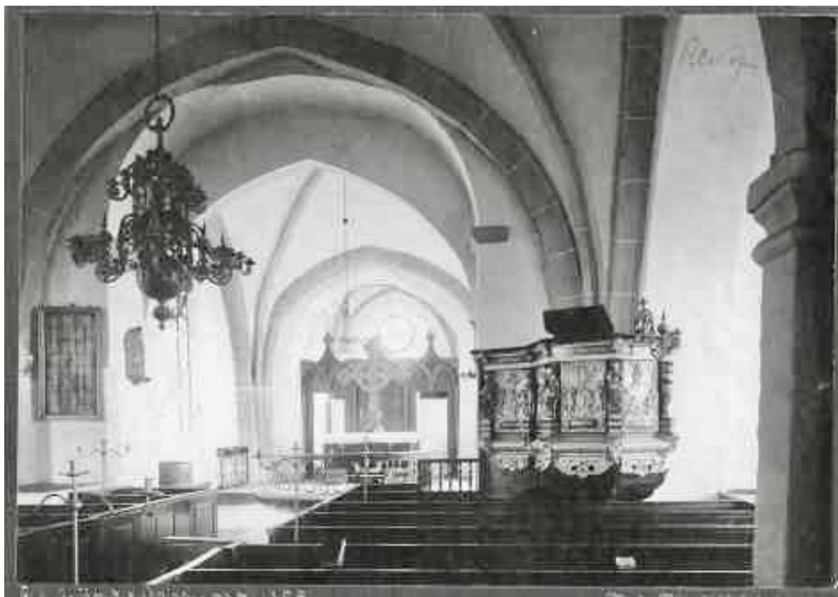
Kyrkorummet i början av 1900-talet med kvadermålade sköld- och gördelbågar och stängda bänkkvarter. Foto: Theodor Wählin. Bilden hämtad från Riksantikvarie- ämbetets bilddatabas Kulturmiljöbild.
