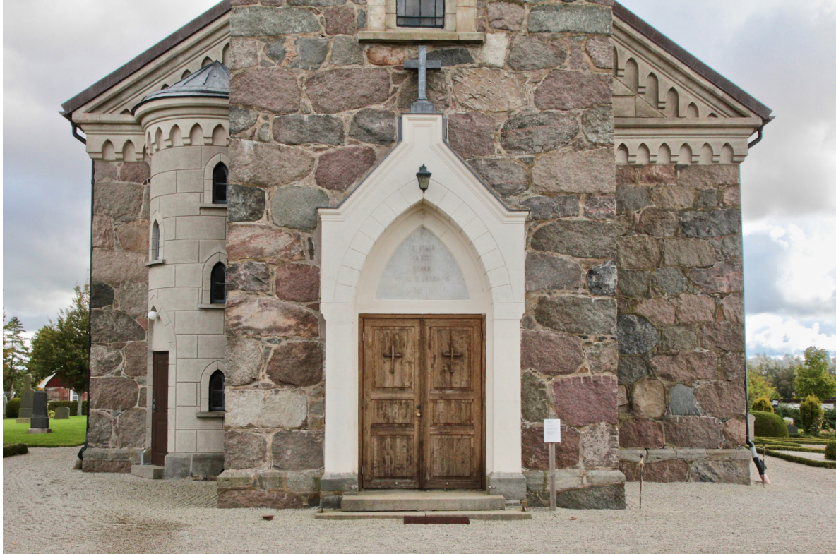
Kyrkans huvudentré i väster. Notera trappornets putsrustik, vars kontrast till naturstensmurverket får effekten att byggnadsdelen ger sken av att vara senare adderat.
