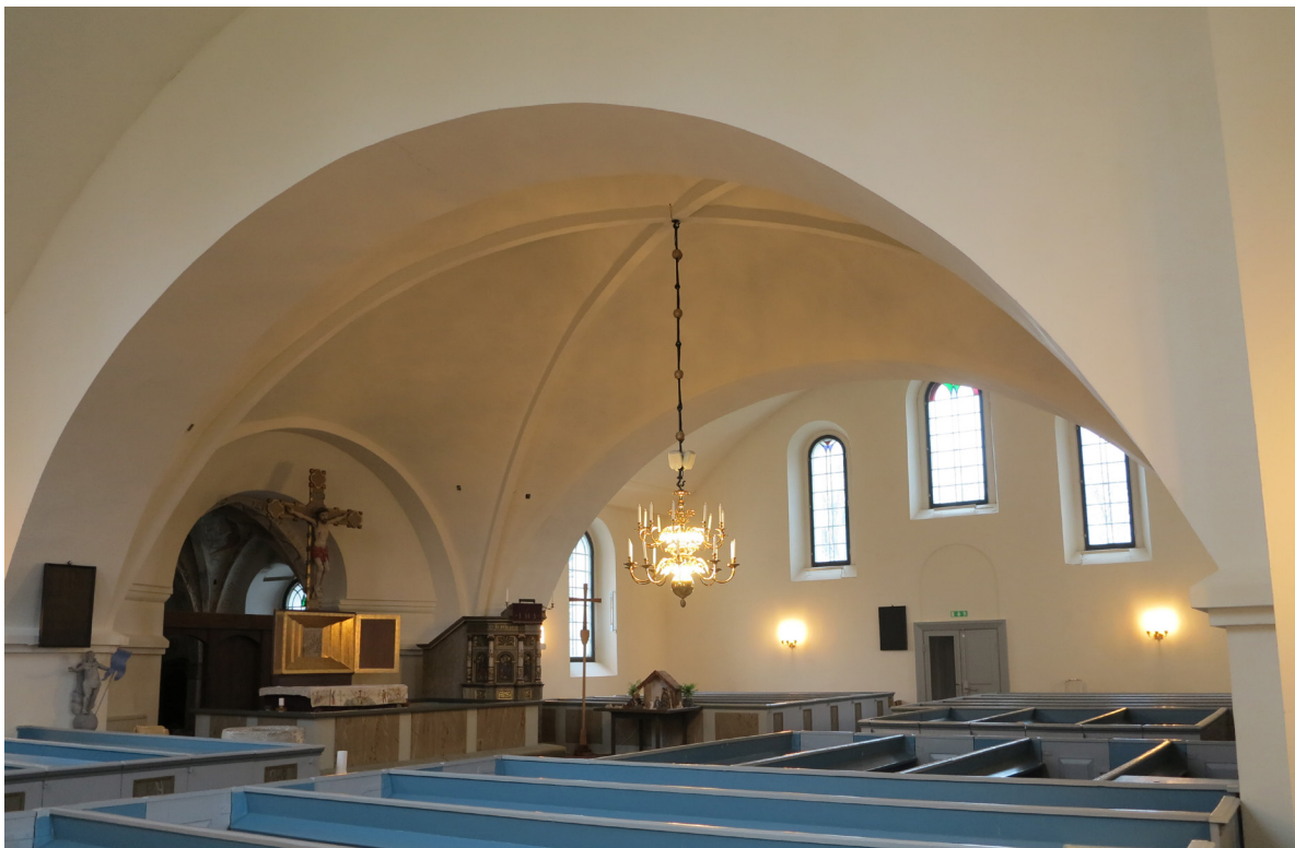
Kyrkorummet från nordväst. Långhusets kryssvalv tillkom i samband med korsarmarnas uppförande 1865.
