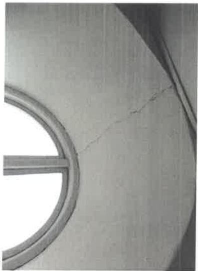
Spricka i tornets fönsternisch, utpenhuset med dörrar och trappa, sakristian med glasade dörrar, äldre dörrtrycke av mässing.
