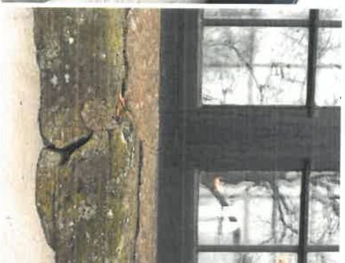
Foton på kyrkan med blyinfattat glas i fönster, släpptsad nisch med skador i puts, intäkningsplåt på sväpport, stenrappa, kyrkfönster med sättningspricka, solbänk av sten med sprickor samt skadad tröskel till sakristian.
