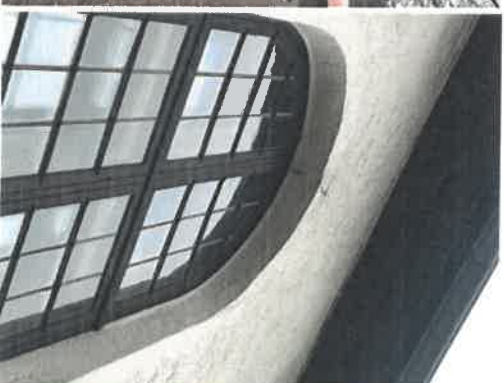
Foton på kyrkan med blyinfattat glas i fönster, släpptsad nisch med skador i puts, intäkningsplåt på sväpport, stenrappa, kyrkfönster med sättningspricka, solbänk av sten med sprickor samt skadad tröskel till sakristian.
