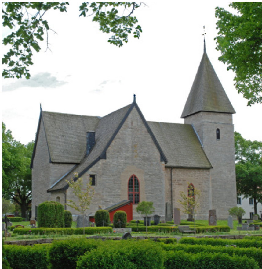
Kyrkans norra sida med korsarmen och sakristian. Fönstren från Lundbergs restaurering sitter i fasadlivet och de sandfärgade partierna runt dem visar var murverket har fyllts ut. Bakom tornet skimtar den gamla skolan med lärarbostad från 1920-talet.
