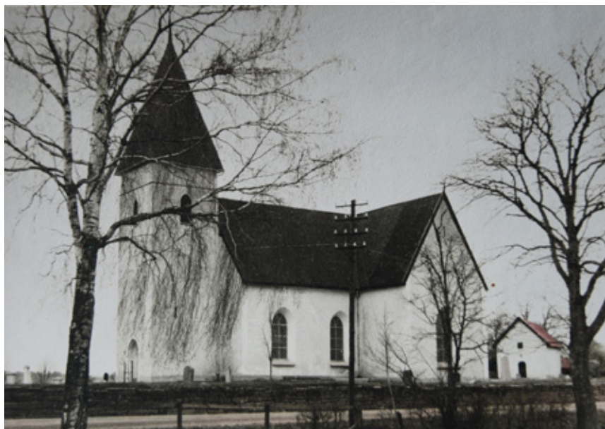
Kyrkan som den såg ut 1879–1958. Ingången är i väster, fönstren är indragna, vapenhus saknas och fasaderna är täckta av tjock spritputs. Foto förvarat i kyrkan.
