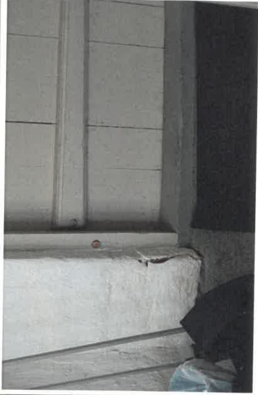
Foto från sakristia och sidorum där färgbortfall och putsskador är mer omfattande. Ena dörrtrycket behöver justeras.
