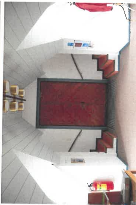
Foton på vapenhus i tornets bottenvåning, WC och el-central. Färgbortfall syns på synlig timmerkonstruktion samt på pardörr mot långhuset.
