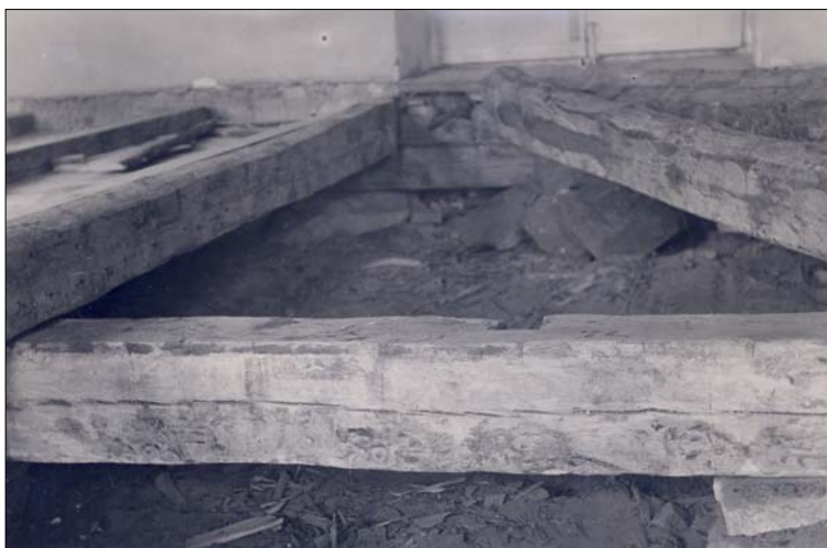
Timmer från en äldre bemålad takstol förra kyrkan ligger nu som delar av golvbjälklaget. Foto: Gotfrid Andersson, 1920, Jönköpings läns museum.
