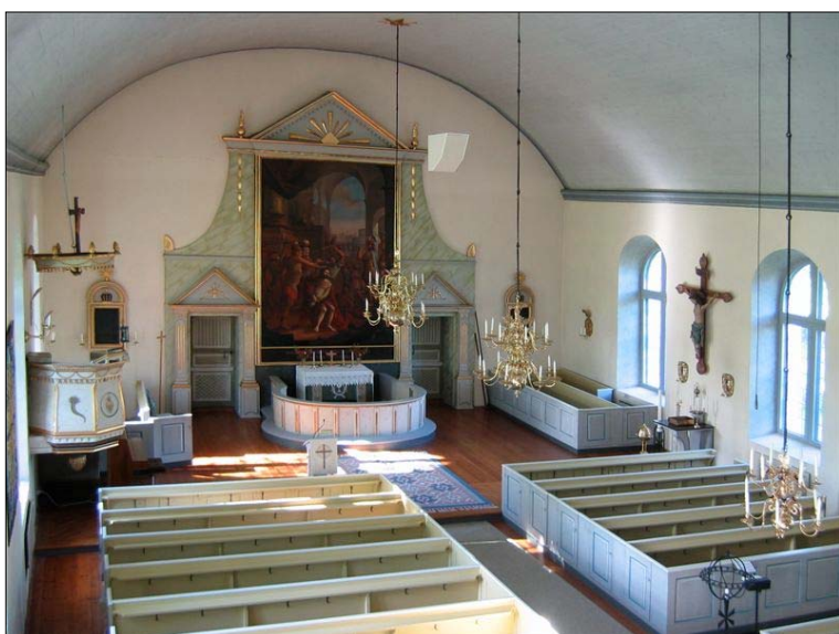
Vid renoveringen 1928, som leddes av arkitekt Göran Pauli, fick altartavlan en omfattning av plywood. Samtidigt överkalkades också en text på korväggen; Ära vare Gud i höjden. Bortsett från detta är interiören i stort sett oförändrad. Vy mot nordväst.
