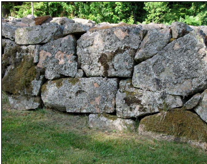
Del av östra muren.
