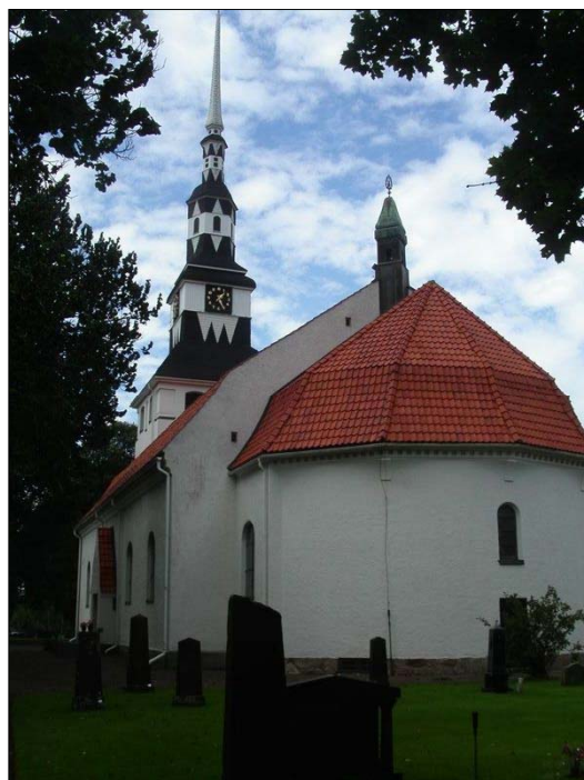
Efter branden 1911 uppfördes kyrkan igen på de gamla grundmurarna, bortsett från koret som uppfördes på nya. Jämfört med gamla kyrkan gjordes yttermurarna högre och takfallet bröts.
