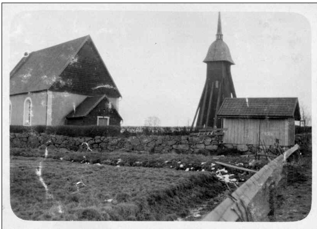
Bild av Mellby kyrka tagen från nordväst. Kyrkan är inte vitkalkad utan färgad i någon kulör, troligen i spritputs förutom omfattningar kring muröppningar och hörn. Foto från okänt årtal i ATA's arkiv.
