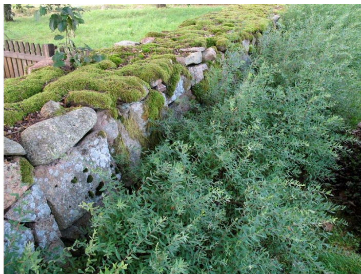
Del av muren längs med kvarter A.
