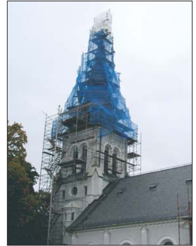
Kyrktornet på Nykroppa kyrka skall renoveras. Bilden är från renoveringen som gjordes 2008.
