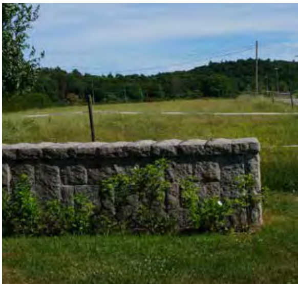
Entrén i nordväst markeras med en beklädnadsmur täckt med granitplattor. Här finns också en rosenplantering.
