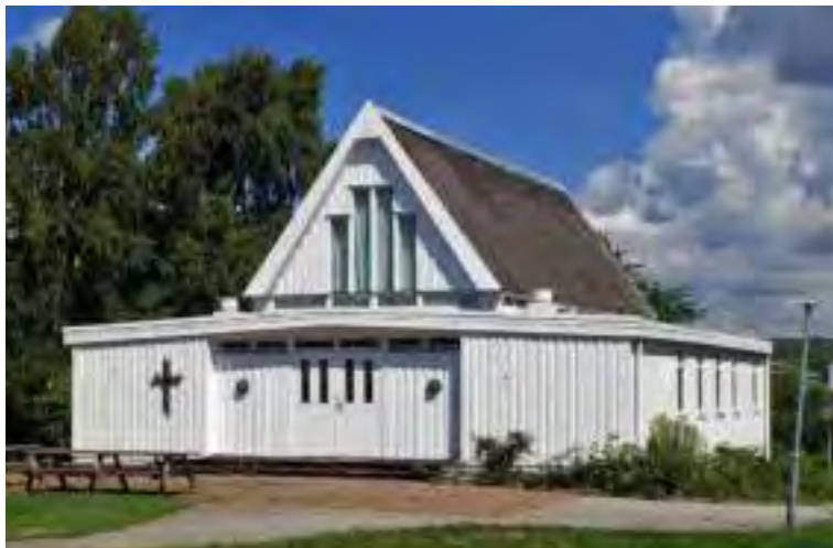
Foto på den provisoriska vandringskyrkan som stod uppförd i anslutning till kyrkogårdens huvudentré. Den monterades ned 1983 och såldes till en frikyrkoförsamling i Stenungsund.
