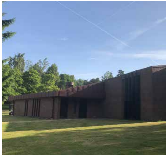
Nuvarande kapellet, som idag används som ceremonilokal ersatte den provisoriska vandringskyrkan.
