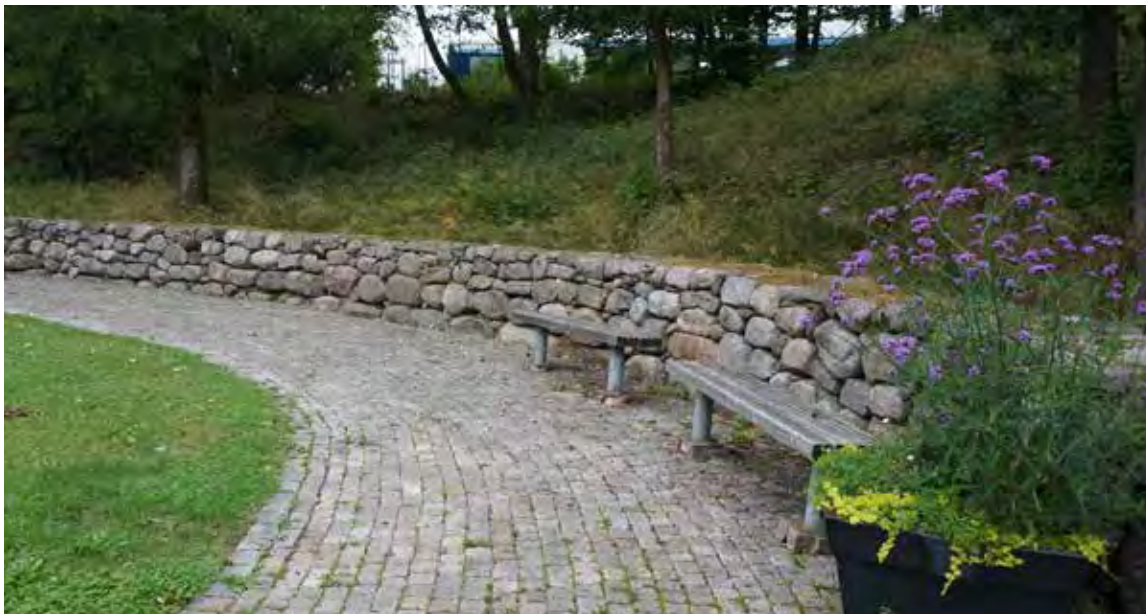
Inom minneslunden finns en stödmur gjord av fältsten.
