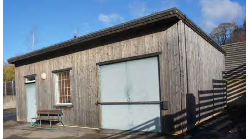
Kyrkogårdens enda byggnad, enkelt utförd med grå träfasad av järnvitriolbehandlad gran. Pulpettaket, är täckt med sedum.
