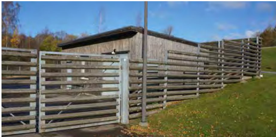
Området runt ekonomibyggnaden är ingärdat.
