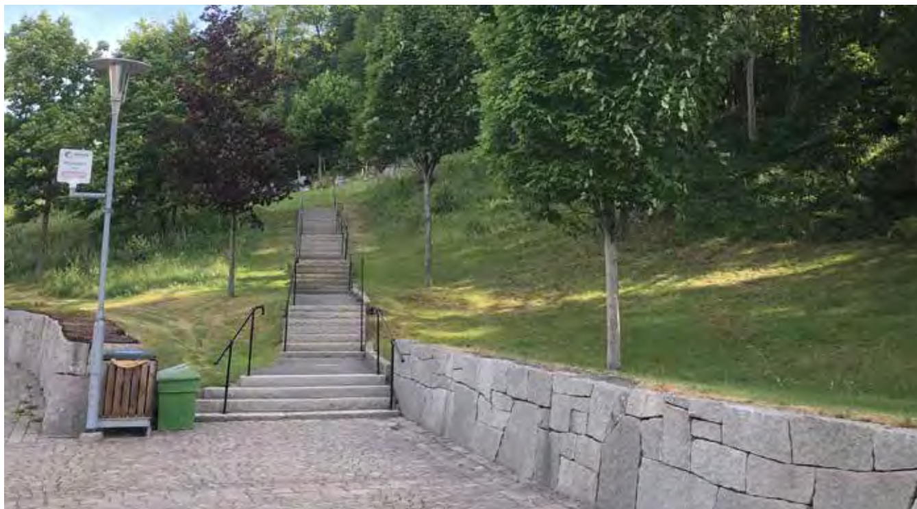
Kyrkogårdens entré ramas in med en kallmurad stödmur av granitblock i kryssförband. Trappa i granit leder vidare upp till urngravskvarter-
