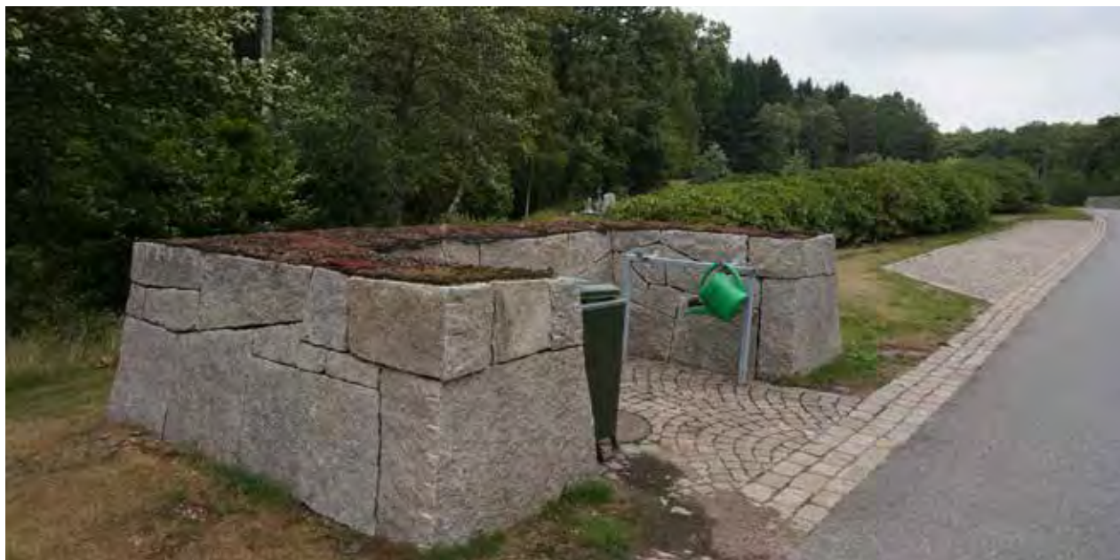
Servicestationerna är inramade med karaktärsskapande murar, kallmurar av granitblock i kryssförband.
