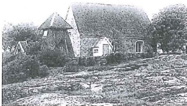
Fullestad kyrka efter renoveringen 1909-1913.
