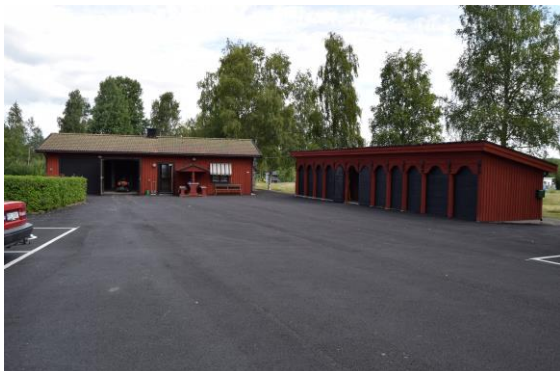
Kyrkstallar från 1883 och förvaltningsbyggnad från 1990.
