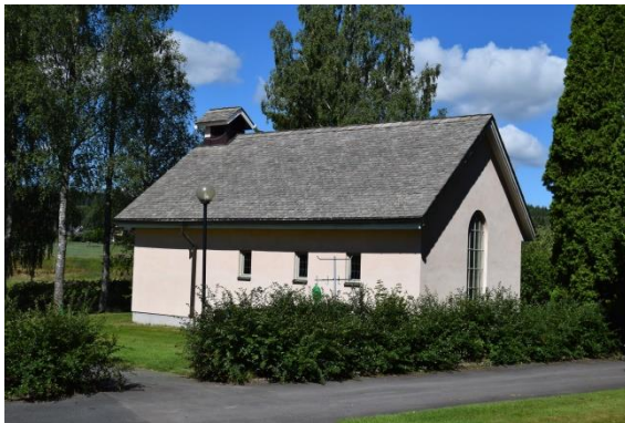
Gravkapellet från 1997, sett från sydost.
