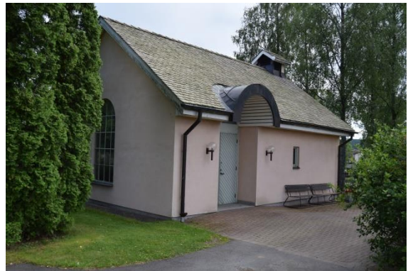
Gravkapellet sett från nordost.
