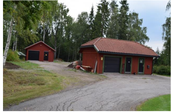
T.v. förrådet uppfört 2014 och t.h. förvaltningsbyggnaden uppförd 1986.
