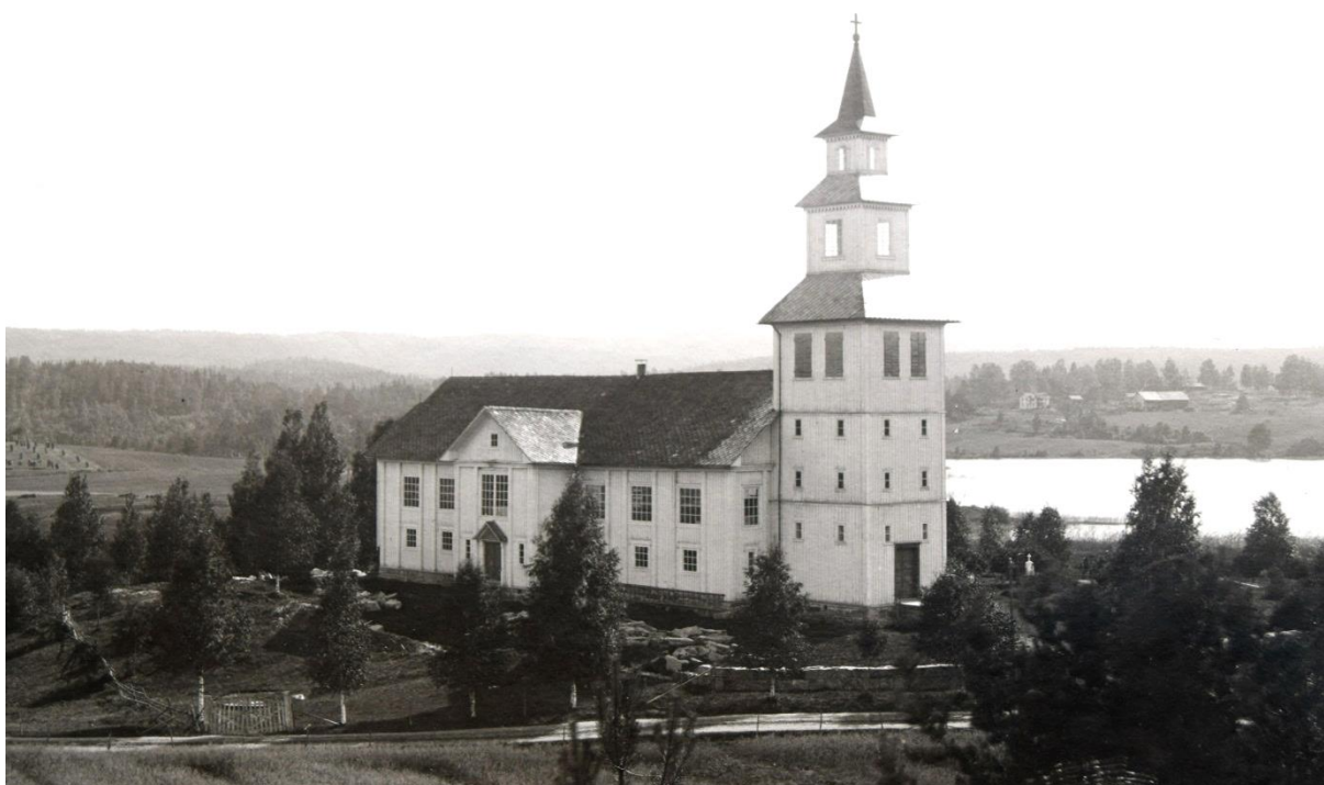
Östervallskogs kyrka sedd från nordväst vid 1900-talets början. Vid zoomning kan man se att en kyrkogårdsmur håller på att uppföras. Årtalet 1907 på ett par bevarade smidesgrindar vittnar om att muren färdigställdes detta år. Foto: Larsen & Ödvall, Arvika, Värmlands Museum.
