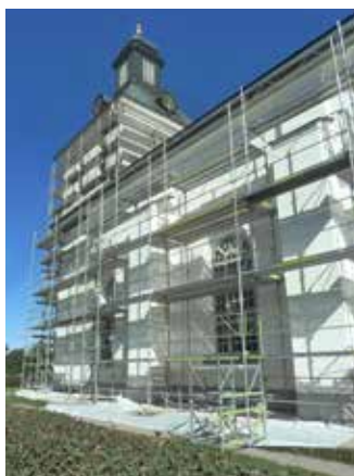
RENOVERING. Byggställningar vid Nora kyrka.
