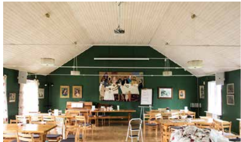
HÖSPÄNT. I höjd med taklamporna syns de stänger som håller väggarna på plats.
