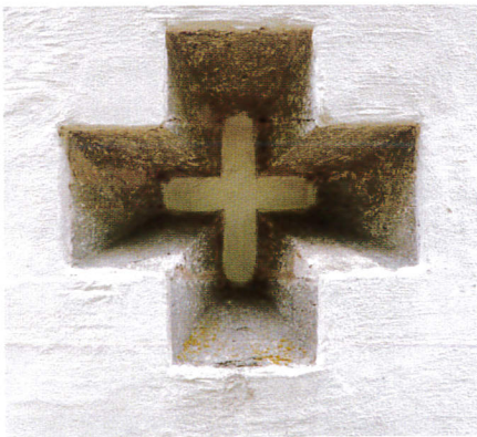
Absidens korsformade fönsteröppning, igenmurad vid okänt tillfälle.
