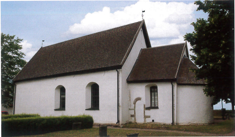
Kyrkan från sydöst. Den igenmurade korportalen lämnades oputsad vid renoveringen 1996, liksom det lilla korsformade fönstret på absiden, längst till höger.
