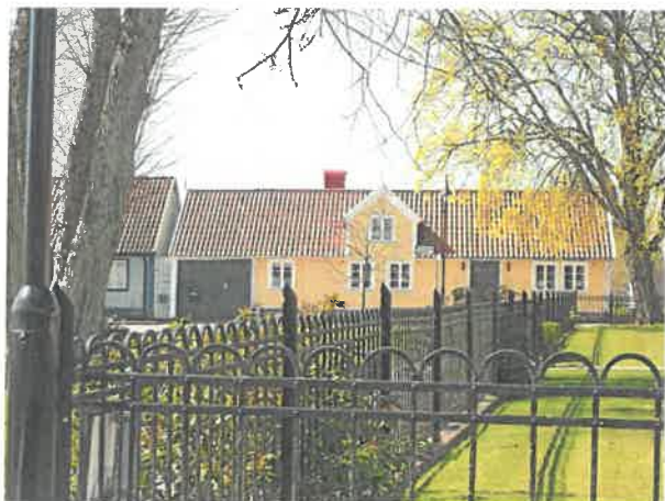
Staket från 1940 mot parken i söder
