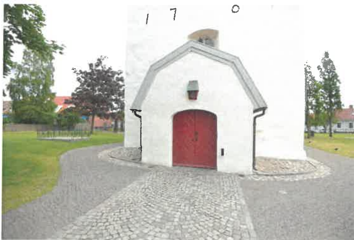
Entrématta i gatsten fram till västra entrén
