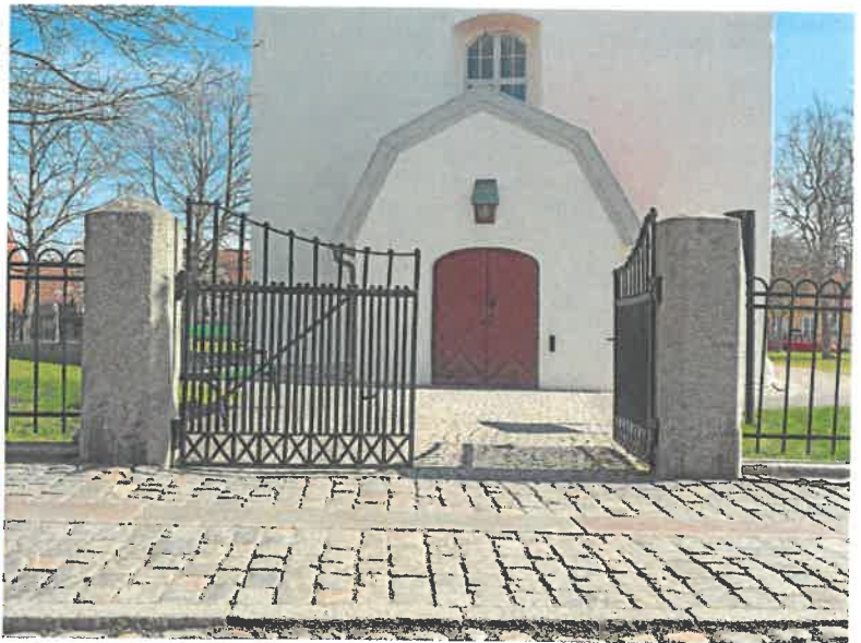
Pargrind mitt för Vapenhuset
