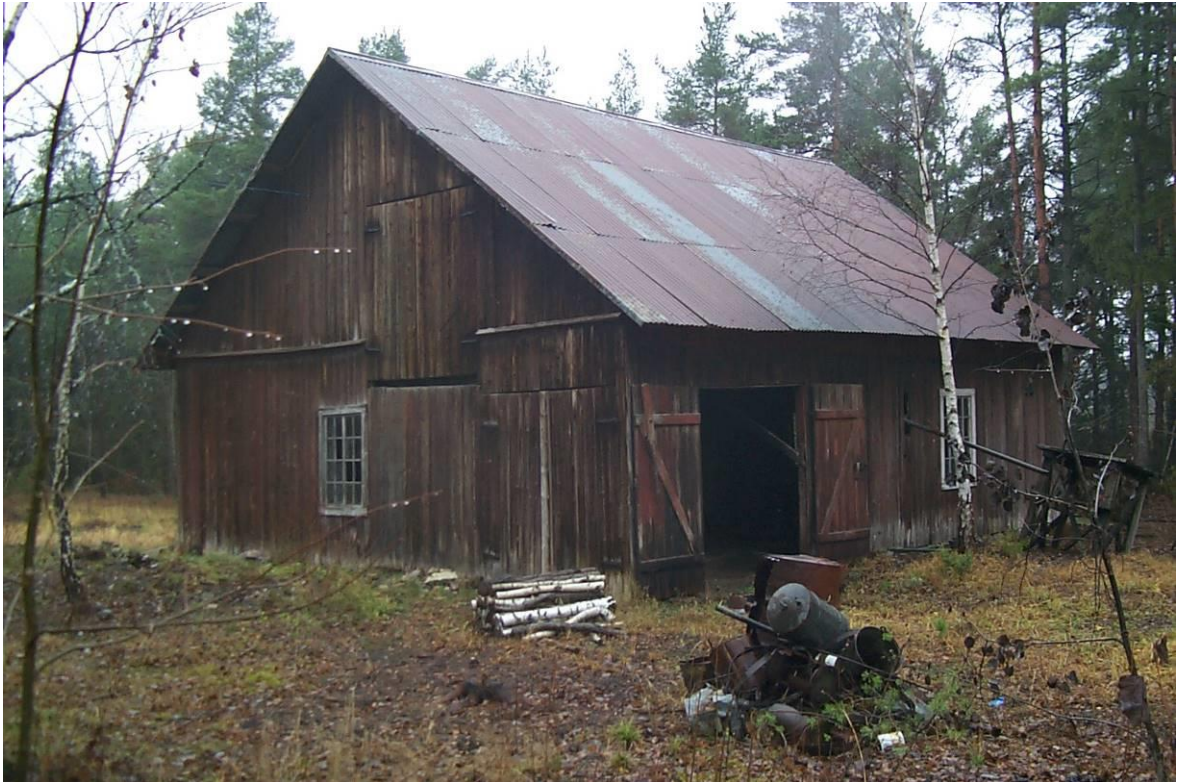
Fabriksanläggningen fotograferad från nordöst. För enkel åtkomst med skottkärra till övervåningen fanns det tidigare en ramp som ledde upp till dubbelporten i gavelspetsen.
