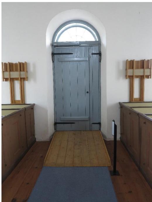
Ny dörr med automatisk dörröppnare i Fårö kyrka. Foto innan slutmålning utförts.
