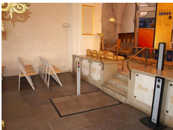
Golvlift i Växjö domkyrka. Ingreppet i golvet kan göras diskret.
