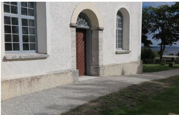
Korsarmsdörrens exteriör och den nya rampen som en förhöjning framför dörren.
