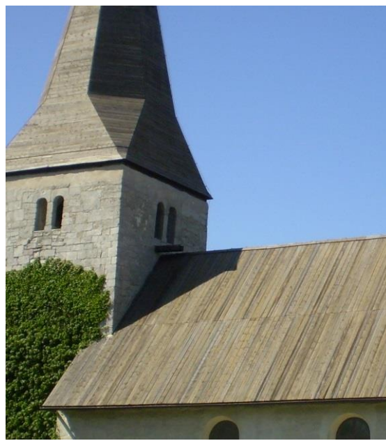
Figur 31: Fröjel kyrka med tjärat tak som solen sliter hårt på.
