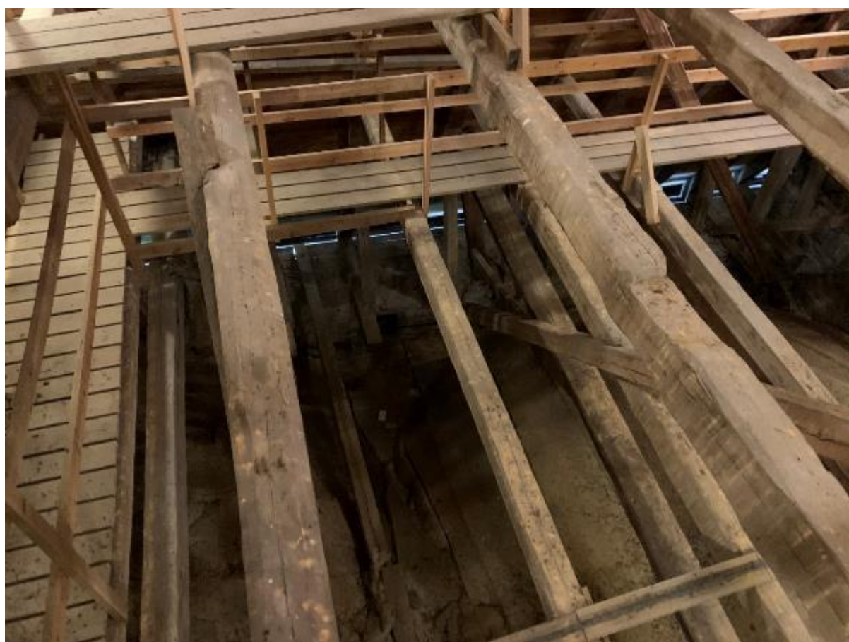
Långhusets vind sedd nedåt mot norr. Foto JL 2020.
