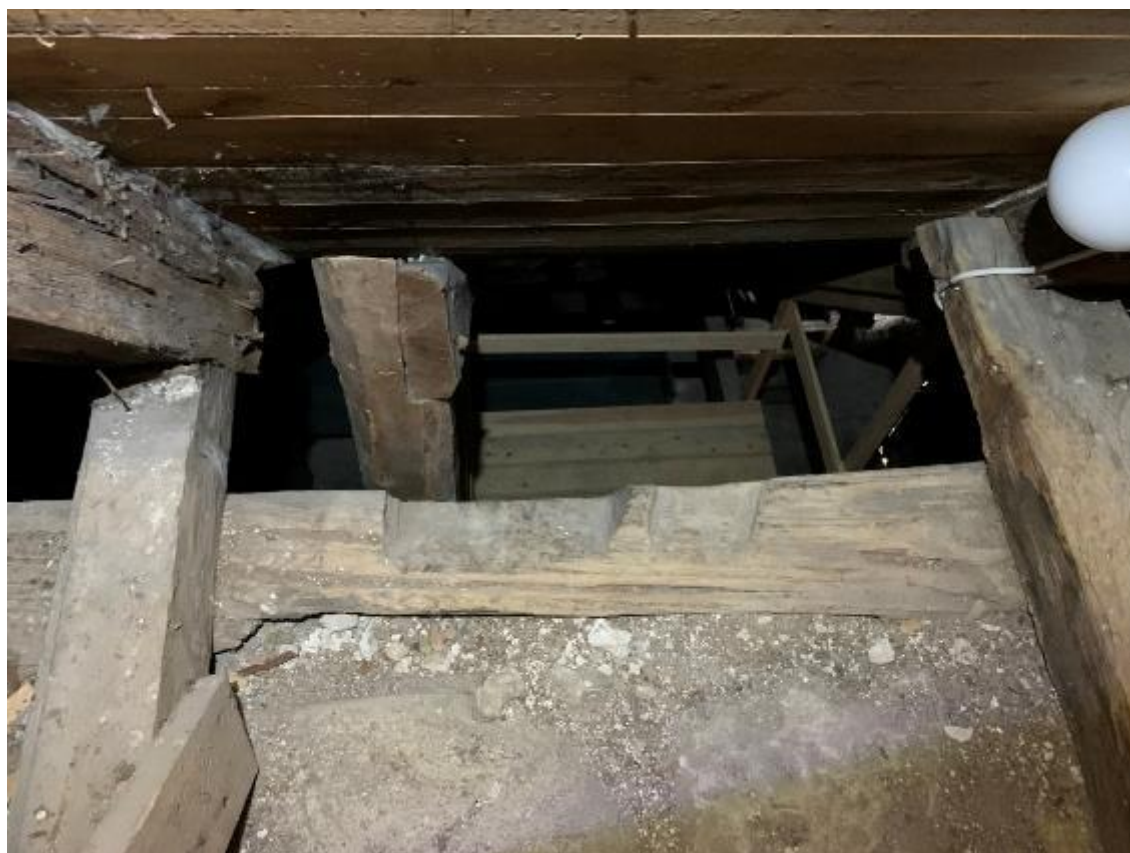
Korutsprångets norra takfot med öppning mot magasinets vind, varifrån stege ansluter som alternativ till den trånga muröppningen från koret. Remstycket bilat för passagen. Foto JL 2020.
