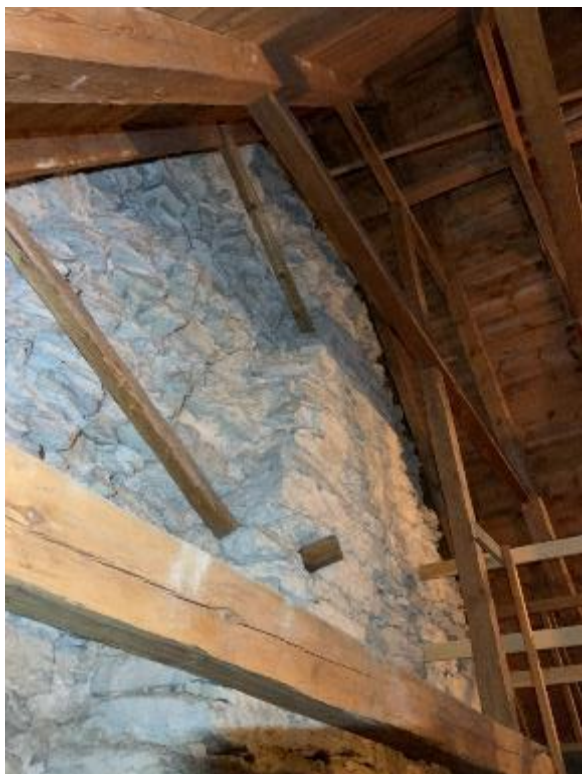
Korvindens östra del med gavelröstet mellan kor och korutsprång. Gavelns tidigare höjd framgår, innan den höjdes vid nuvarande långhusets tillkomst då koret också fick sitt nuvarande valv. Foto JL 2020.
