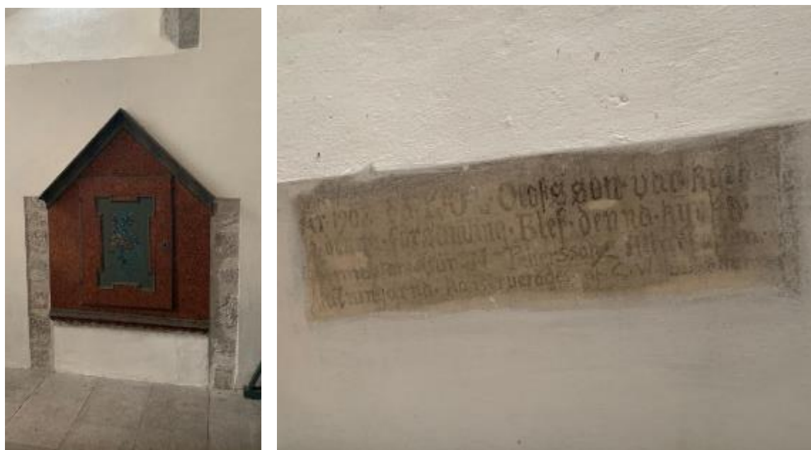
Korutsprångets södra sida med hörnedjor till den tidigare korportalen, använd till nisch. T.h. inskrift under östra fönstret, berättande om restaurering 1908. Foto JL 2020.
