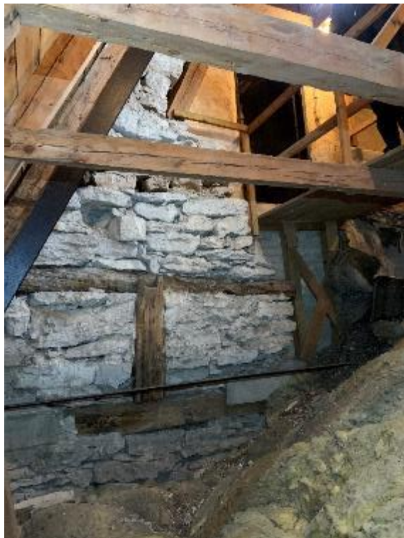
Korvinden sedd mot väster. Gavelröset mellan kor och långhus är förstärkt med timmer och senare med stålbalk och betong. Öppningen mellan vindarna murades igen vid 1970-talets restaurering och försägs med dörr. Skorstensstock ansluter från magasinsvinden i norr. Foto JL 2020.
