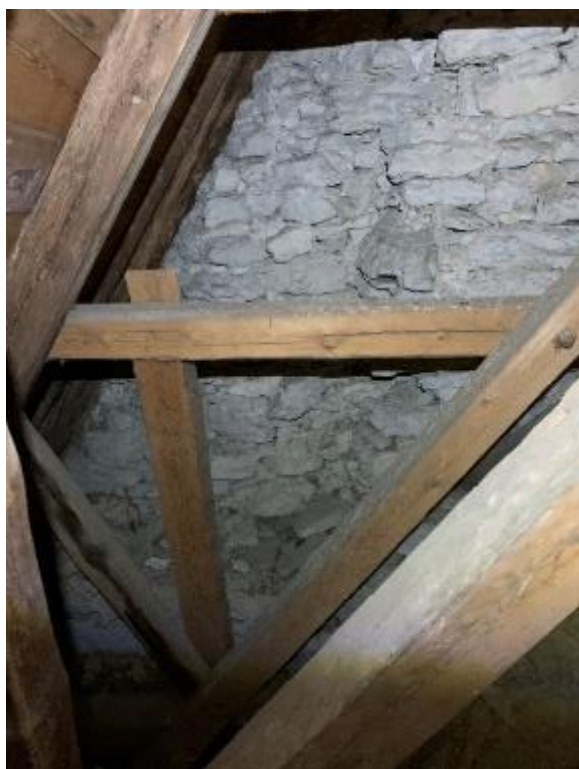
Korutsprångets östra gavelröste, sett mot öster. Murverket visar att gaveln är höjd och takfallet tidigare låg lägre, motsvarande putsavtrycken på gavelmuren i väster. T.h. ljusöppning i den omkr. 1300 förhöjda muren. Foto JL 2020.
