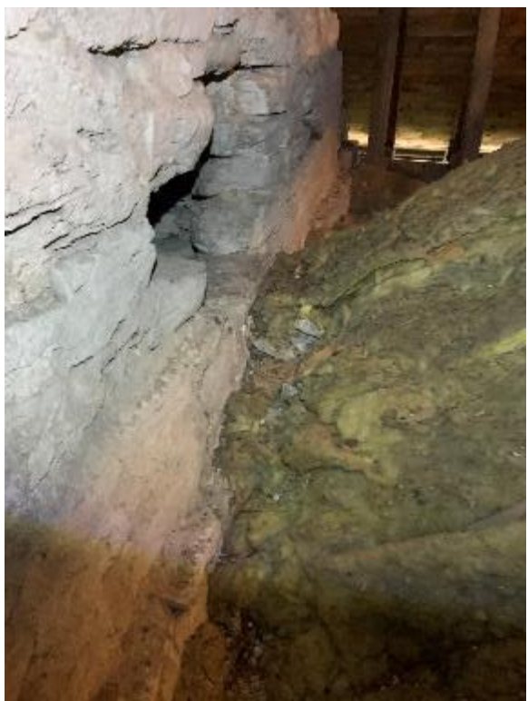
Korvindens östra gavelröstet med öppning till korutsprångets vind. Avsatsen under öppningen är möjligen en byggnadsskarv mellan korutsprångets byggnadsetapp, medan gaveln är samtidig med koret, om de inte är byggda samtidigt. T.h. remstycken på korets södra sida på den omkr. 1300 påbyggda sidomuren. Foto JL 2020.
