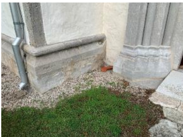
Långhusets sydöstra hörn med sockelns anslutning till kormuren med ej fortsatt förtagning mot koret. T.h. korets sydöstra hörn med anslutningen till korutsprångets sockel. Foto JL 2020.
