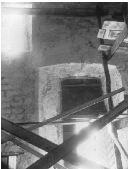
Muren kring korportalen under restaurering. Murytan bitvis renhuggen från puts. Foto 1909 i ATA, RAÄ, Kulturmiljöbild. T.h. inskriften från 1211 i dess restaurerade kontext med avvikande putskaraktär. Foto Johnny Roosval 1913, ATA, RAÄ Kulturmiljöbild. Vid restaureringen fick fogarna mörkare ton liksom sannolikt putsen, om detta inte berodde på kaminsot.
