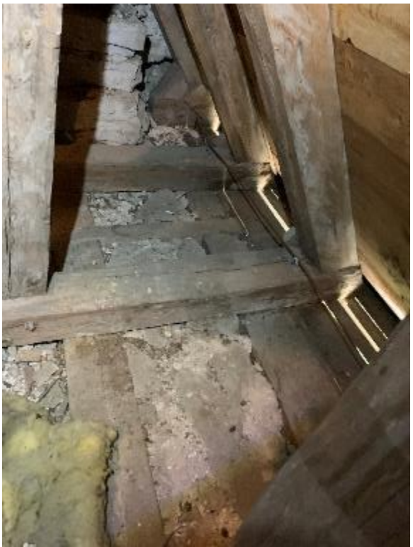
Korvindens östra gavelröstet med öppning till korutsprångets vind. Avsatsen under öppningen är möjligen en byggnadsskarv mellan korutsprångets byggnadsetapp, medan gaveln är samtidig med koret, om de inte är byggda samtidigt. T.h. remstycken på korets södra sida på den omkr. 1300 påbyggda sidomuren. Foto JL 2020.
