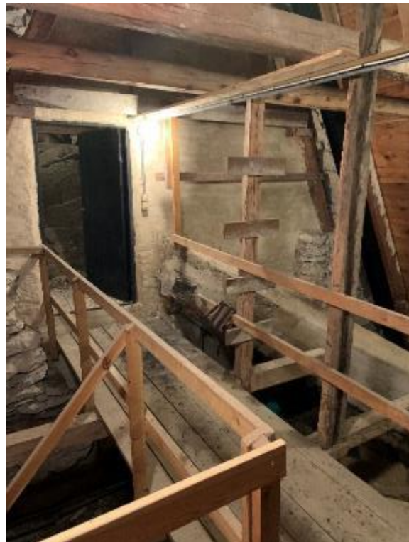
Korvinden sedd mot väster. Gavelröset mellan kor och långhus är förstärkt med timmer och senare med stålbalk och betong. Öppningen mellan vindarna murades igen vid 1970-talets restaurering och försägs med dörr. Skorstensstock ansluter från magasinsvinden i norr. Foto JL 2020.
