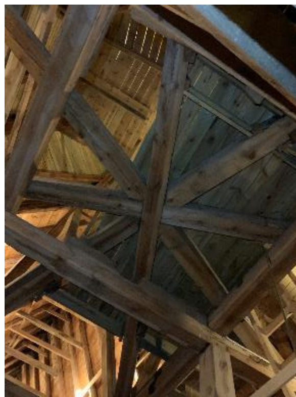
Takryttarens underkonstruktion, sedd nedåt mot norr samt uppåt mot sydöst. Foto JL 2020.
