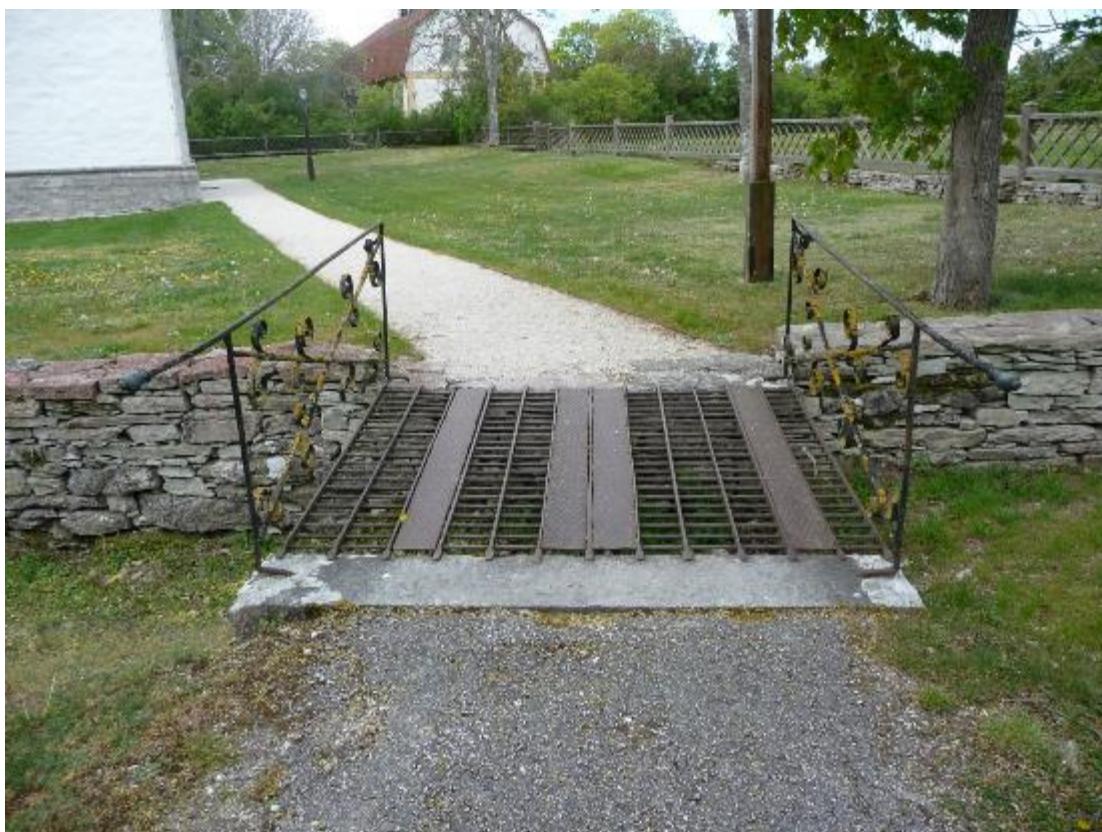
Den norra ingången med en färst (järngaller). Här syns också den västra delen av kyrkogården vilken saknar synliga gravar. Foto ES 2020.
