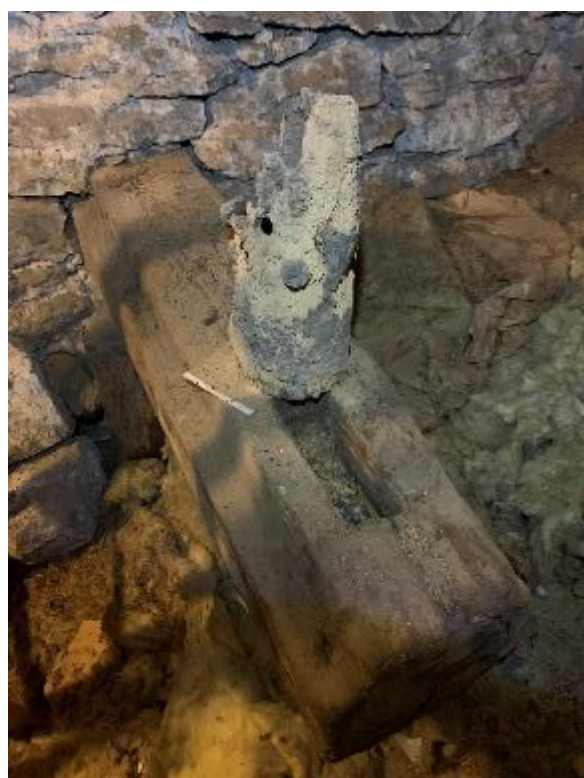
Utskjutande bjälkar från västra gavelmurens insida. Sannolikt rester av bärkonstruktionen för en ursprunglig takryttare. Den södra, bilden t.v., har kälade urskärningar i översidans ytterkanter. Båda har tapphål. Ovanpå den södra står rester av en sturk, den genomborrade träskoningen för klockrepet med utskjutande dymlingar som fäste i valvets murverk. Foto JL 2020.
