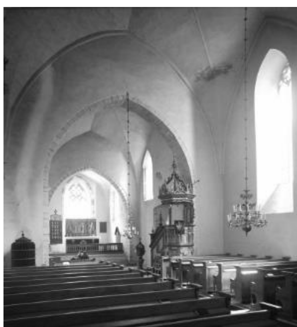
Interiör mot väster och öster. Foto Erik Bohrn 1938, ATA, RAÅ Kulturmiljöbild. Läktaren revs 1908 samtidigt som fönstret i väster togs upp. Norr om triumfbågen kamin från restaureringen vars rökrör i muren avspeglar sig i putsytan.
