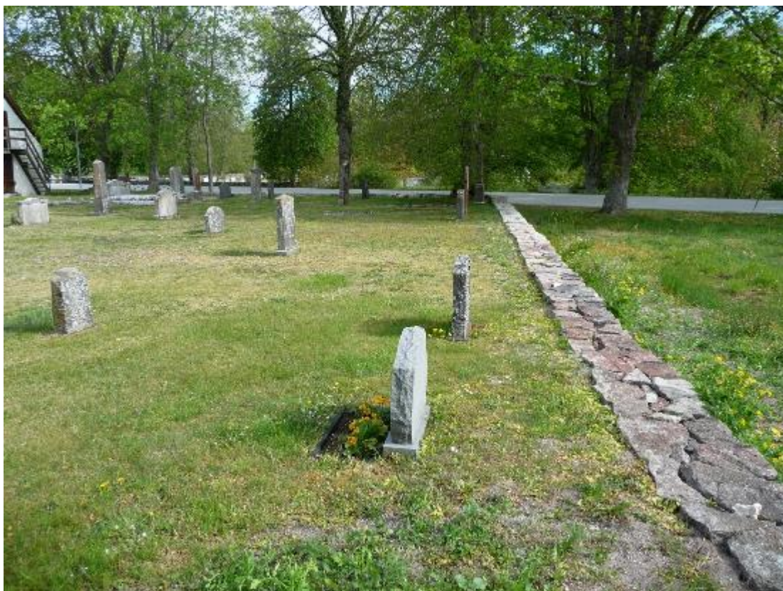
Den östra terrassmuren fotograferad från söder. Foto ES 2020.
