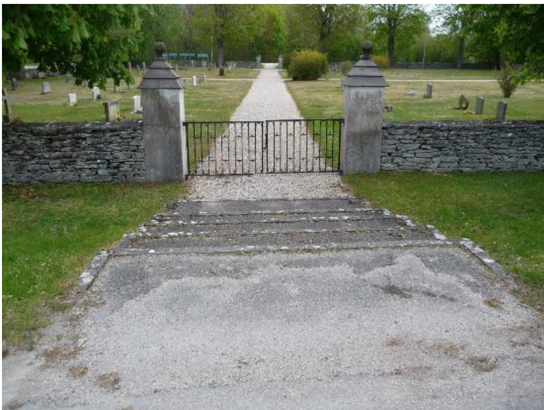
Den södra ingången har en trappa belagd med asfalt och grindar i smidesjärn med murade stolpar. Foto ES 2020.
