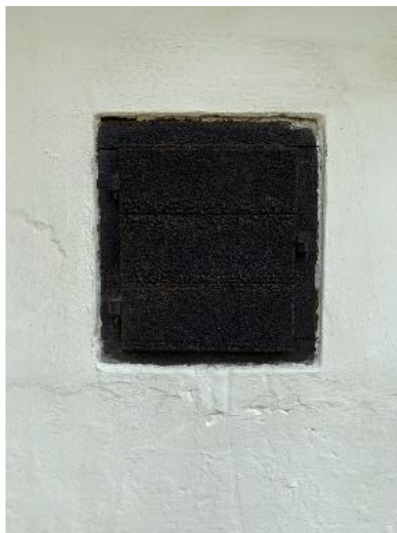
Sockenmagasinets östra gavel. T.h. ventil med trälucka i magasinets norra mur. Foto JL 2020.
