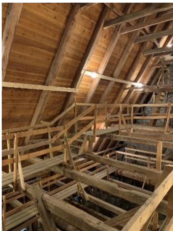
Långhusets vind med takstolen sedd mot nordöst och mot sydöst ned mot valvens ovansida och takfoten. Foto JL 2020.
