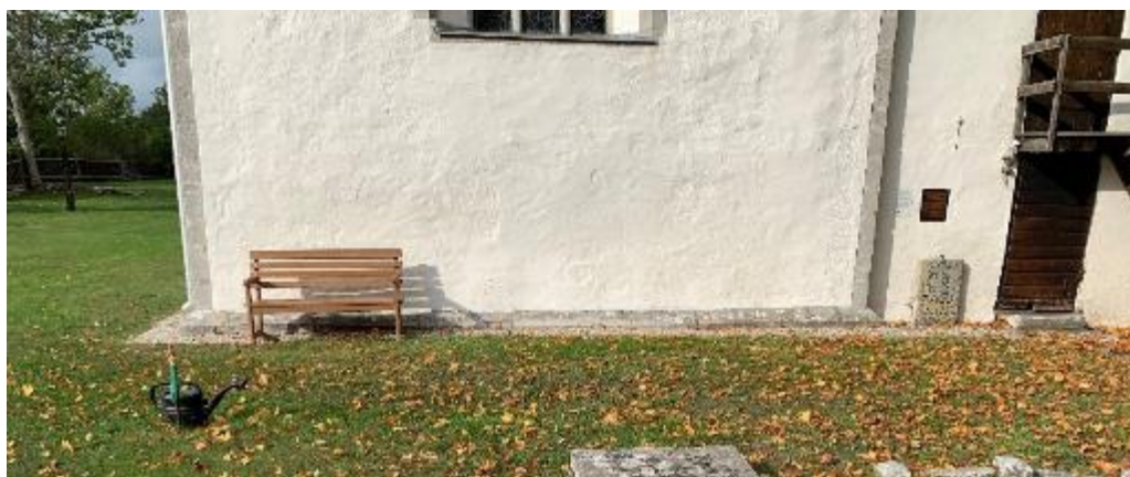
Korutsprånget östra sockel och läget för den tidigare absiden. Foto JL 2020.
