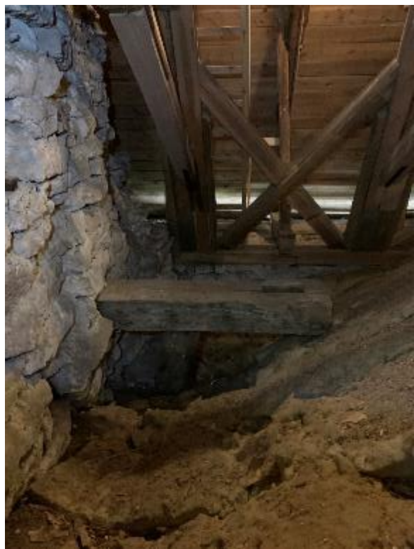
Utskjutande bjälkar från västra gavelmurens insida. Sannolikt rester av bärkonstruktionen för en ursprunglig takryttare. Den södra, bilden t.v., har kälade urskärningar i översidans ytterkanter. Båda har tapphål. Ovanpå den södra står rester av en sturk, den genomborrade träskoningen för klockrepet med utskjutande dymlingar som fäste i valvets murverk. Foto JL 2020.
