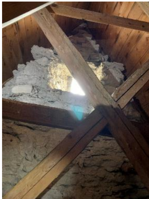
Korutsprångets östra gavelröste, sett mot öster. Murverket visar att gaveln är höjd och takfallet tidigare låg lägre, motsvarande putsavtrycken på gavelmuren i väster. T.h. ljusöppning i den omkr. 1300 förhöjda muren. Foto JL 2020.
