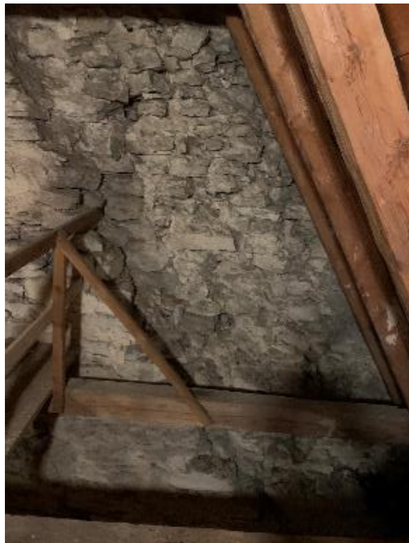
Korvindens östra del med gavelröstet mellan kor och korutsprång. Gavelns tidigare höjd framgår, innan den höjdes vid nuvarande långhusets tillkomst då koret också fick sitt nuvarande valv. Foto JL 2020.
