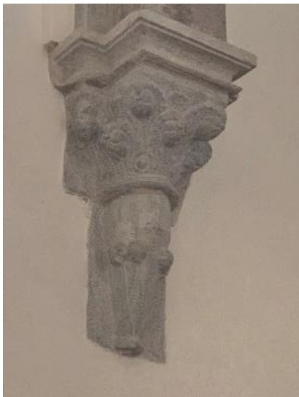
Valvkonsoler på södra och norra långhusmuren. Foto JL respektive ES 2020.
