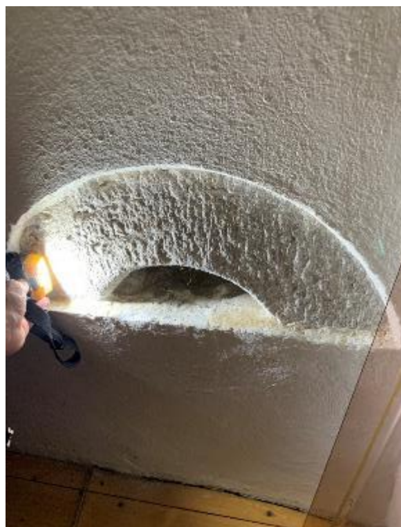
Ovan, nisch i sakristians norra mur. Nedan tidigare fönsteromfattning sekundärt infogad i sakristians norra mur. T.h. samma omfattning i släpljus. Dess svaga rundning talar för att den suttit i absiden som revs vid samma tid som sakristian byggdes. Foto JL 2020.
