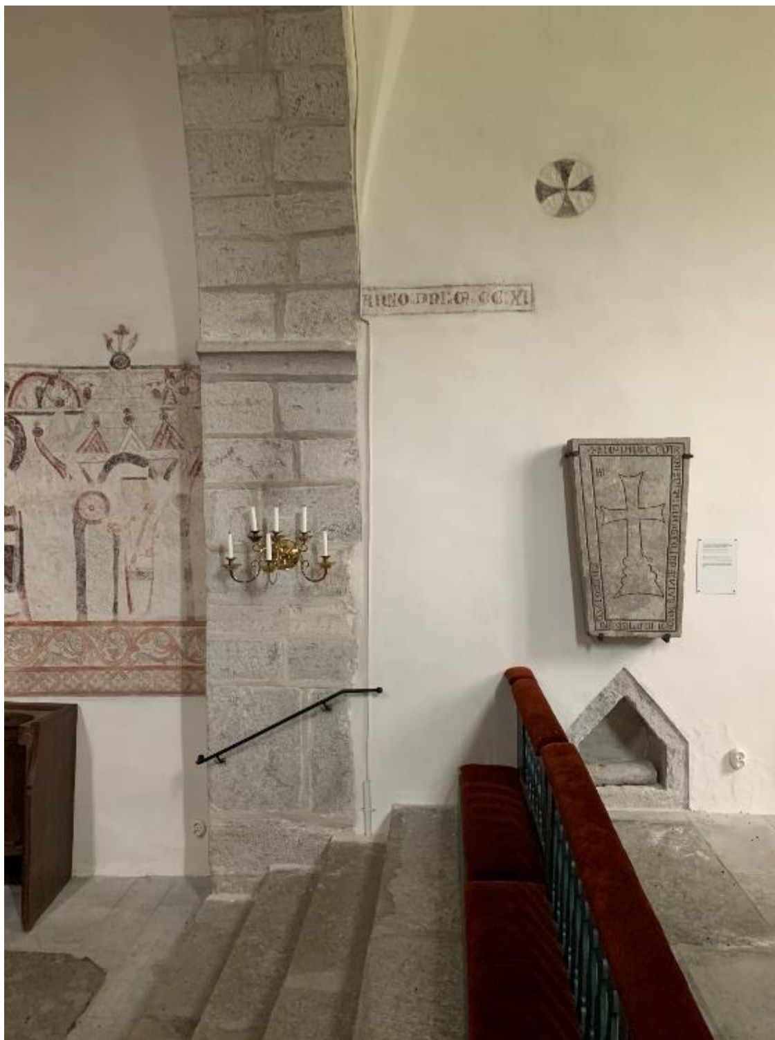
Korutsprånget och tribunbågen mot norr med inskriften om år 1211 (M CC XI), som sannolikt anger ett invigningsår, förmodligen för den romanska kyrkan med absid, kor (nu korutsprånget) och långhus (nu koret). Foto JL 2020.
