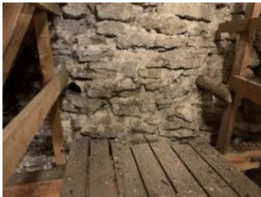
Långhusvindens östra gavelmur. Ovan t.v. alastningsbjälkar över tidigare öppning till korvinden, bakom skorstensstocken. Nedan t.v. bomhål från byggnadstiden, den högra med kvarsittande virke. T.h. vindens östra del sedd mot öster. Strax över valvet dörr till korvinden. Foto JL 2020.
