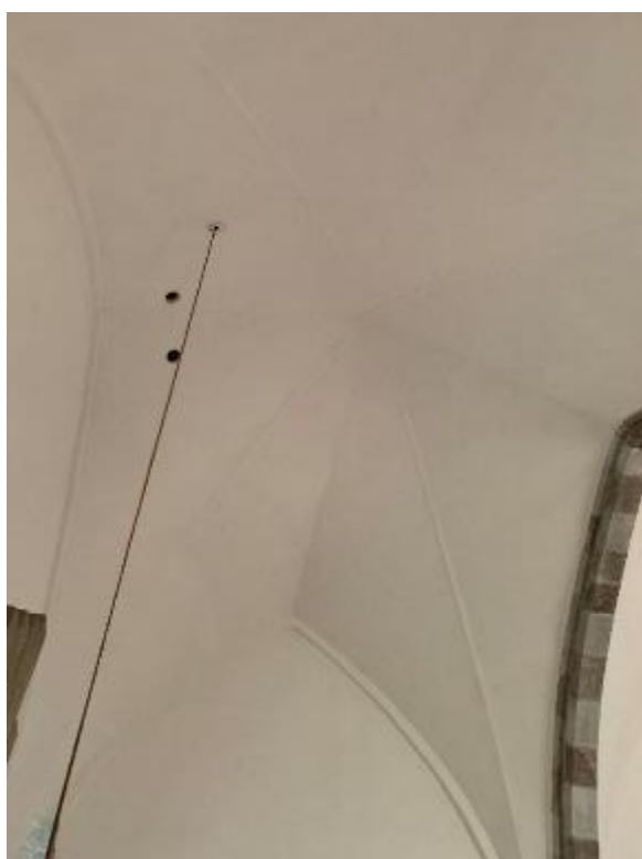
Långhusets västra valv sett underifrån mot norr med tidigare hål för klocklinor. T.h. anfang för de tunna sköldbågarna närmast muren i långhusets sydvästra hörn. Foto JL 2020.
