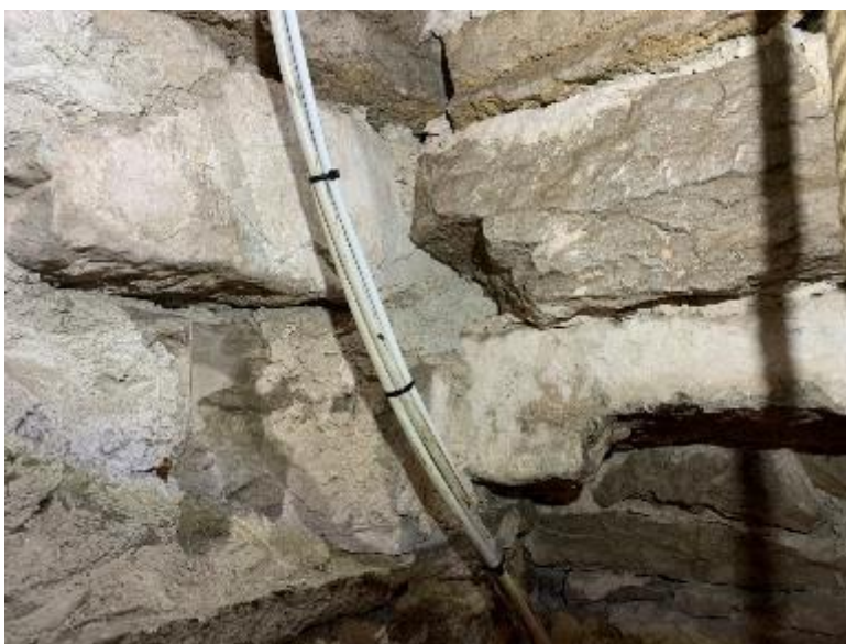
Övertäckning av murtrappan vid mynningen på kyrkvinden. Slåthuggna block med puts torde komma från de rivna delarna av den romanska kyrkans långhus, som alltså även ursprungligen varit putsat. Förekommer de i murarnas övre del, som här, tyder det på att långhuset stod kvar orört tills det nya var färdigt. Foto JL 2020.
