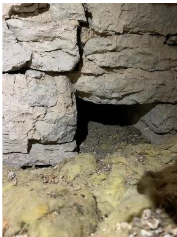
Gavelmuren mellan kor och korutsprång, sedd mot sydväst och väster, med igenmurad öppning strax nedanför den nuvarande uppbrutna passagen. Sannolikt övre delen av en tidigare passage mellan vindarna innan nuvarande valven tillkom omkr. 1300. Foto JL 2020.
