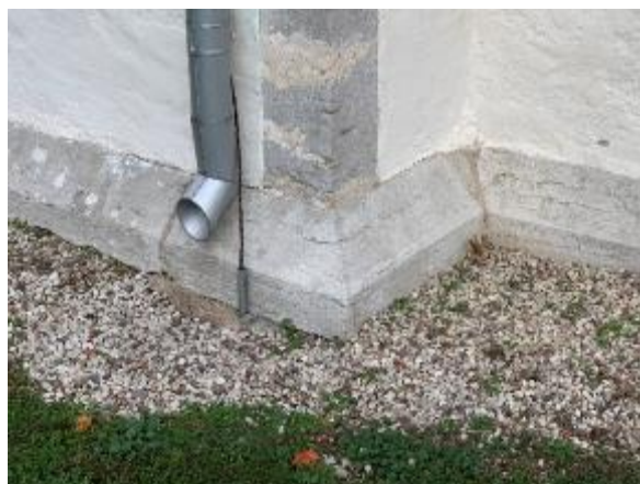
Långhusets sydöstra hörn med sockelns anslutning till kormuren med ej fortsatt förtagning mot koret. T.h. korets sydöstra hörn med anslutningen till korutsprångets sockel. Foto JL 2020.
