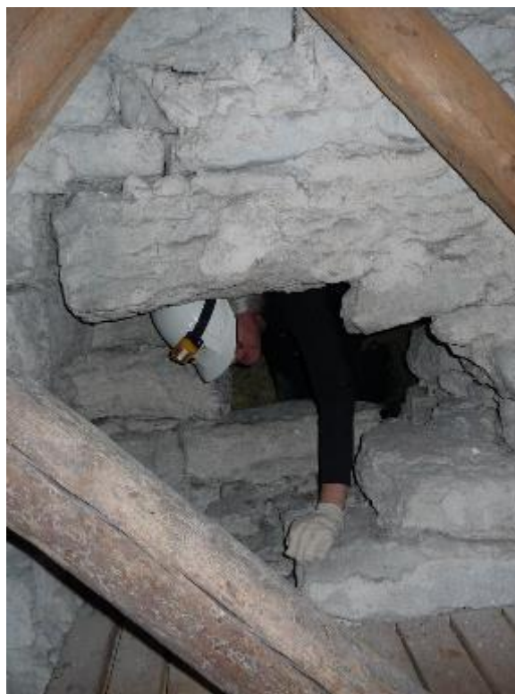
Passage mellan vindarna över koret och korutsprånget, uppbruten efter nuvarande valvens tillkomst, sedd från väster och öster. Foto JL resp. ES 2020.
