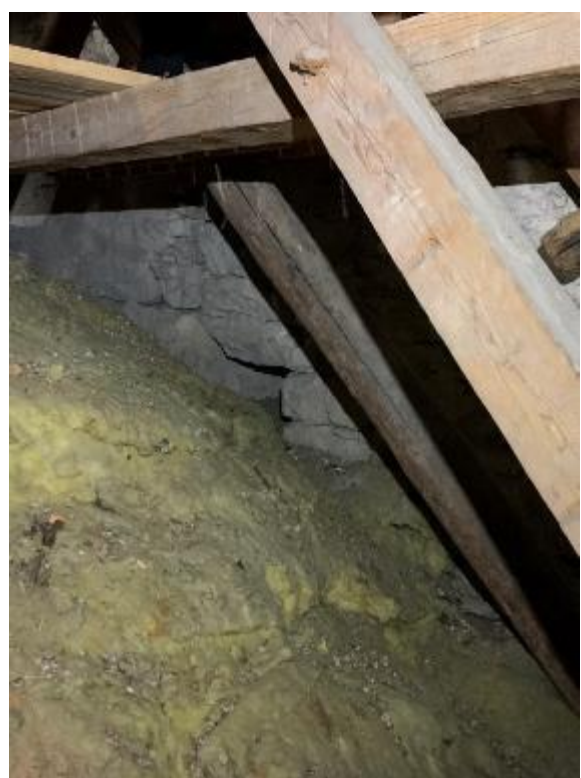
Gavelmuren mellan kor och korutsprång, sedd mot sydväst och väster, med igenmurad öppning strax nedanför den nuvarande uppbrutna passagen. Sannolikt övre delen av en tidigare passage mellan vindarna innan nuvarande valven tillkom omkr. 1300. Foto JL 2020.
