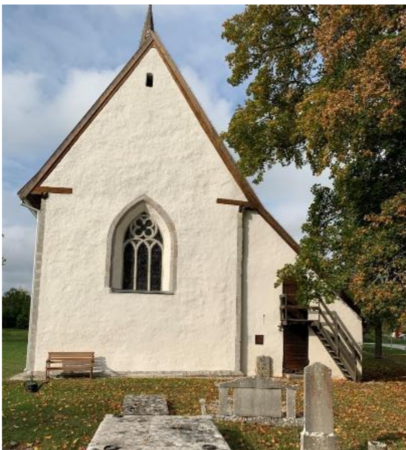
Korutsprångets östfasad. Den tidigare absidens grundmur ligger under gräset medan avtryck i fasaden efter absiden är svaga. Foto JL 2020.
