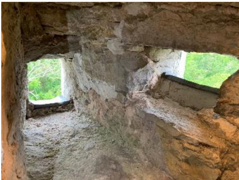
Murtrappan. Ljusluggar placerade i sydvästra hörnet. Foto JL 2020.
