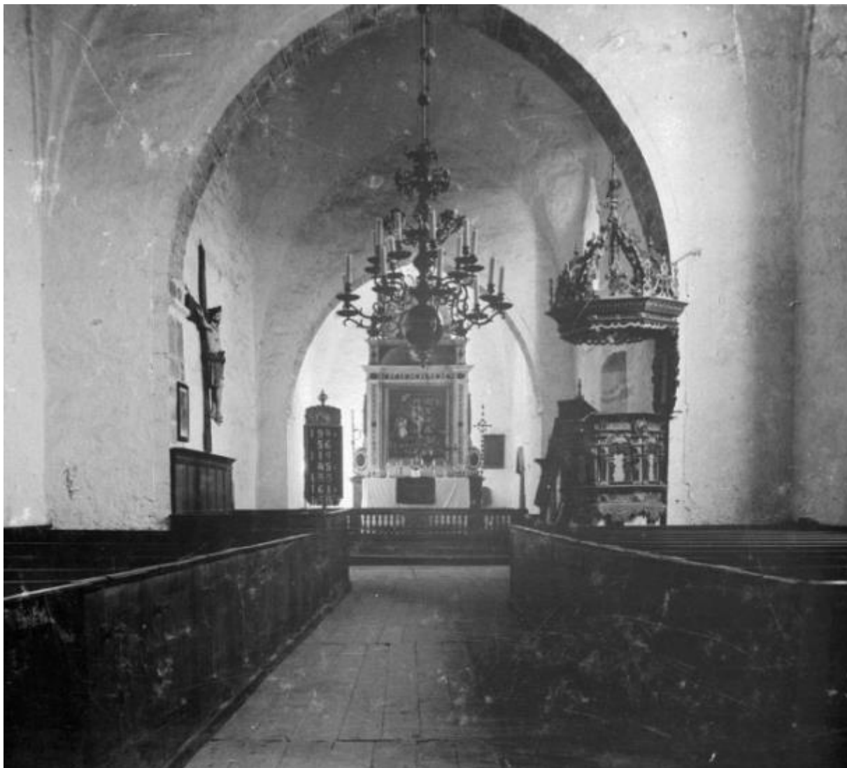
Interiör mot öster före restaureringen 1908. Av bilden framgår att bänkarna på södra sidan var högre än de på norra, att korbänken var stor och hade skärm mot väggen, att krucifixet hade en rik polykromi från 1700-talet före restaureringen och att altartavlan från 1820 hade stödjande pidestaler vid sidorna. Altaret flankeras av två majstänger (?). Foto från omkring 1890-1900 i ATA, RAÄ Kulturmiljöbild.
