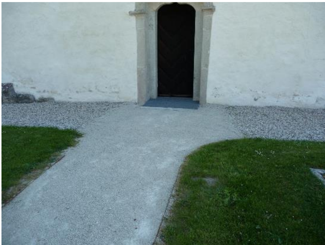
En grusgång, hårdgjord och belagd med finkornigt grus leder in till kyrkan från väster. I övrigt är gångarna belagda med grövre grus. Foto ES 2020.
