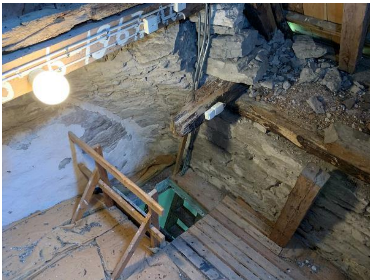
Luckan till vinden, sedd ovanifrån. Foto JL 2020.
