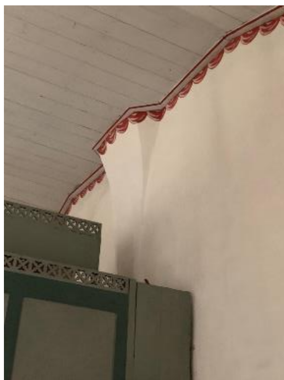
Kvarsittande konsoler från murade valv, t.v. i öster ovanför triumfbågen, t.h. i väster ovanför orgeln. Foto JL 2020.
