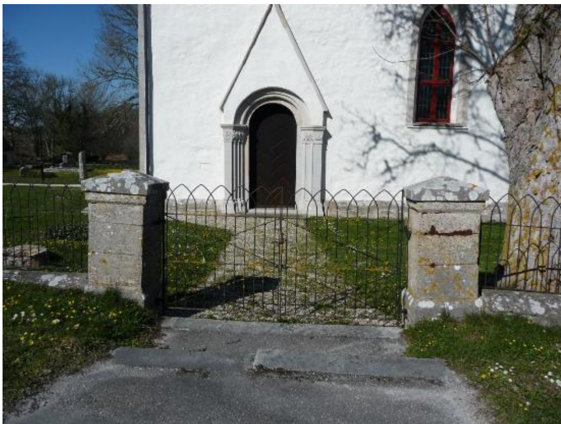
Den södra ingången med dubbelgrind i svartmålat smidesjärn, flankerad av murade kalkstensstolpar. Ett par trappsteg leder ned till kyrkogården. Till höger växer en äldre tysklönn. Foto ES 2020.
