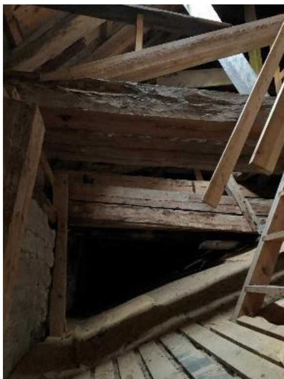
Trännertakets ovansida. T.h. del av murverket på långhusets västra gavel med tydliga spår av branden, sannolikt även väderbitet. Foto JL 2020.
