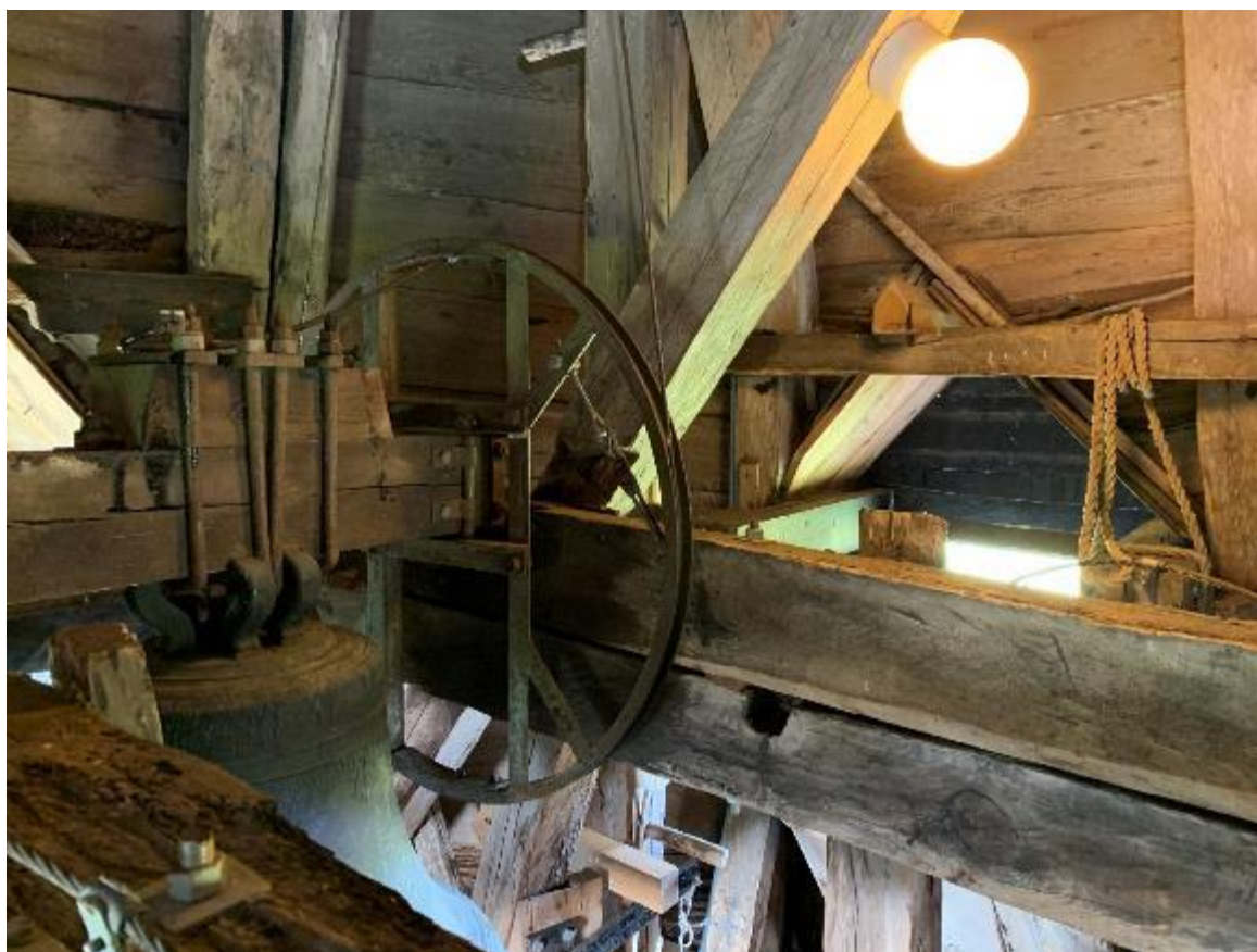
Klockvåningens övre del mot nordväst. Foto JL 2020.
