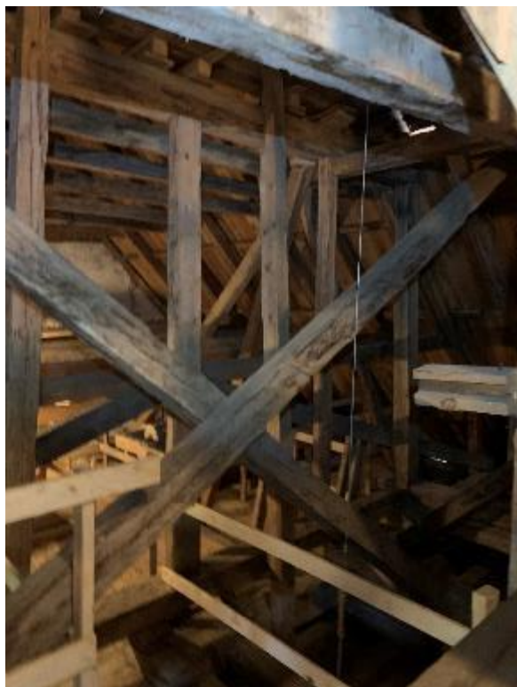
Kryssförstärkt stolpkonstruktion under takryttaren, sedd mot sydöst. Det urholkade trästycket i högerkanten är sannolikt en del från innertakets konstruktion. T.h. Takryttarens takstolar, lagda i stjärnform, sett underifrån mot sydöst. Foto JL 2020.
