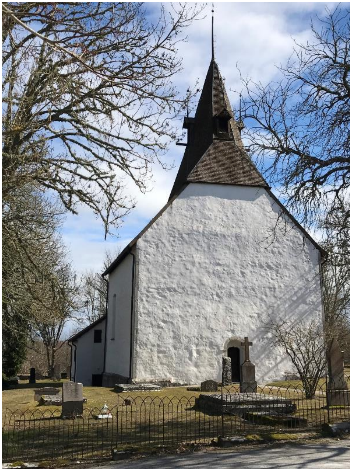
Exteriör från nordväst. Foto JL 2018.
