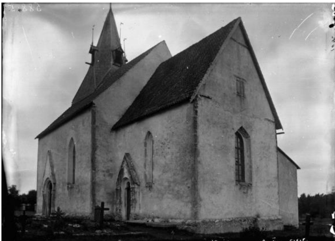
Exteriör från sydöst, troligen på 1890-talet. Foto Olof Sörling, ATA, RAÄ Kulturmiljöbild. Ny puts kring långhusfönstret visar att det nyligen förstorats.
