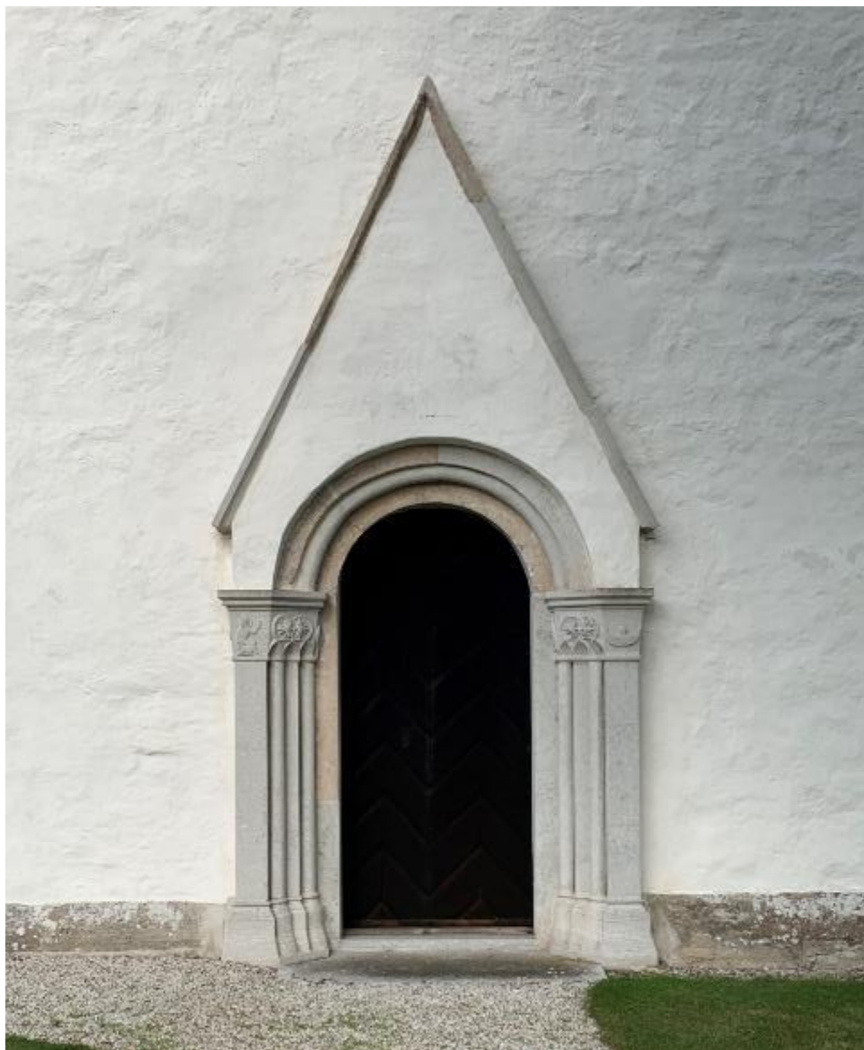
Långhusetets sydportal. Omfattningen till stor del nyhuggen 1978 efter förebild av den skadade ursprungliga. Foto JL 2020.
