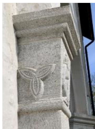
Långhusetets sydportal. Omfattningen till stor del nyhuggen 1978 efter förebild av den skadade ursprungliga. Foto JL 2020.
