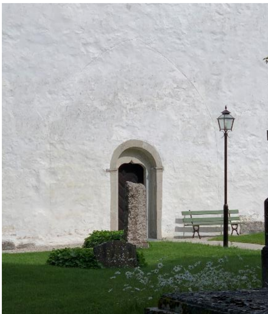
Långhuset från nordväst. Sockeln gör avbrott för det planerade men ej utförda tornet. T.v. den igenmurade tornbågen, sedan 1935 markerad i putsen. Foto JL 2020.
