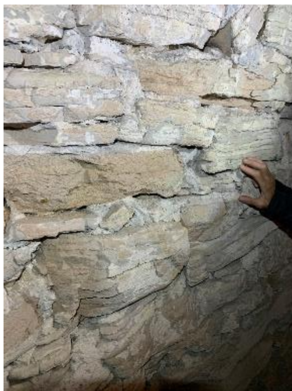
Trännertakets ovansida. T.h. del av murverket på långhusets västra gavel med tydliga spår av branden, sannolikt även väderbitet. Foto JL 2020.
