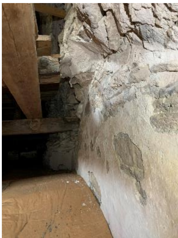
Rester av valven med kvarsittande puts på västgaveln. Foto JL 2020.
