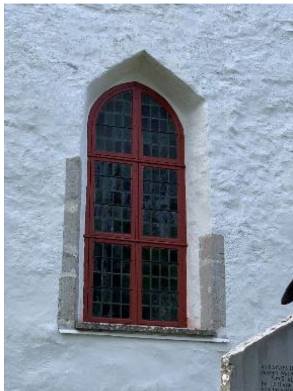
Korets östra gavel. Röstets murverk har annan karaktär än det nedre och är sannolikt nymurat vid återuppbyggnaden efter branden. T.h. östfönstret med delar av medeltida omfattning. Foto JL 2020.
