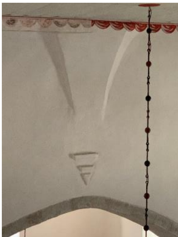
Kvarsittande konsoler från murade valv, t.v. i öster ovanför triumfbågen, t.h. i väster ovanför orgeln. Foto JL 2020.
