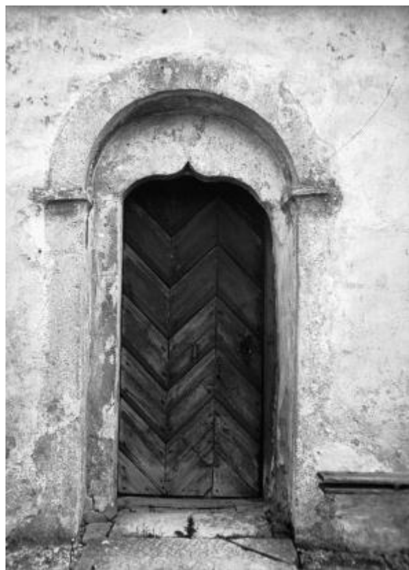
Långhusets västportal. Foto JL 2020 resp. Einar Erici 1916, ATA, RAÄ Kulturmjöbild. Den ovanliga kölbågigen förekommer i några kyrkor kyrkoportaler på Gotland vid 1200-talets mitt. Äldre bilden visar hur den södra posten vid något tillfälle slagits bort, sannolikt för att man under 1700- eller 1800-talet velat bredda gångöppningen. Detta återställdes, förmodligen vid restaureringen 1935.
