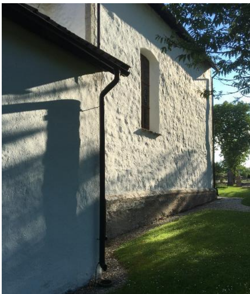
Långhusets nordöstra hörn med sockelns övergång till koret åt vänster. Sockel och hörnkedjor är bättre bevarade här än på kyrkans andra delar, vilket talar för att delar av taket inte rasade ned på denna sida. T.h. långhusets norra fönster från 1793. T.v. nordfasaden i släpljus varvid murverkets struktur framträder. Foto JL 2020 och, t.v., 2016.
