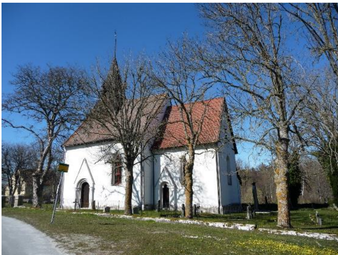
Kyrkogården omges av en terrasmur med betongfundament och ett järnstaket. Kring den äldre kyrkogården finns en trädkrans. Foto ES 2020.
