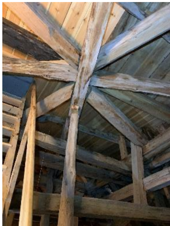
Kryssförstärkt stolpkonstruktion under takryttaren, sedd mot sydöst. Det urholkade trästycket i högerkanten är sannolikt en del från innertakets konstruktion. T.h. Takryttarens takstolar, lagda i stjärnform, sett underifrån mot sydöst. Foto JL 2020.
