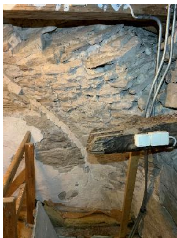
Trännertakets ovansida. T.h. del av murverket på långhusets västra gavel med tydliga spår av branden, sannolikt även väderbitet. Foto JL 2020.
