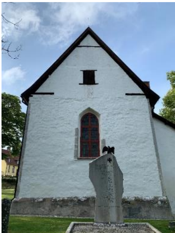
Korets östra gavel. Röstets murverk har annan karaktär än det nedre och är sannolikt nymurat vid återuppbyggnaden efter branden. T.h. östfönstret med delar av medeltida omfattning. Foto JL 2020.
