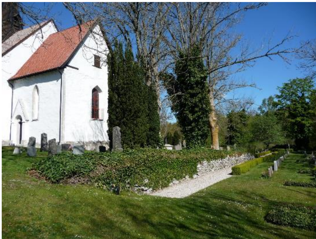
Kring den äldre kyrkogården finns terrassmurar i norr och öster till stora delar täckta av murgröna. Den östra terrassmuren. Foto ES 2020.
