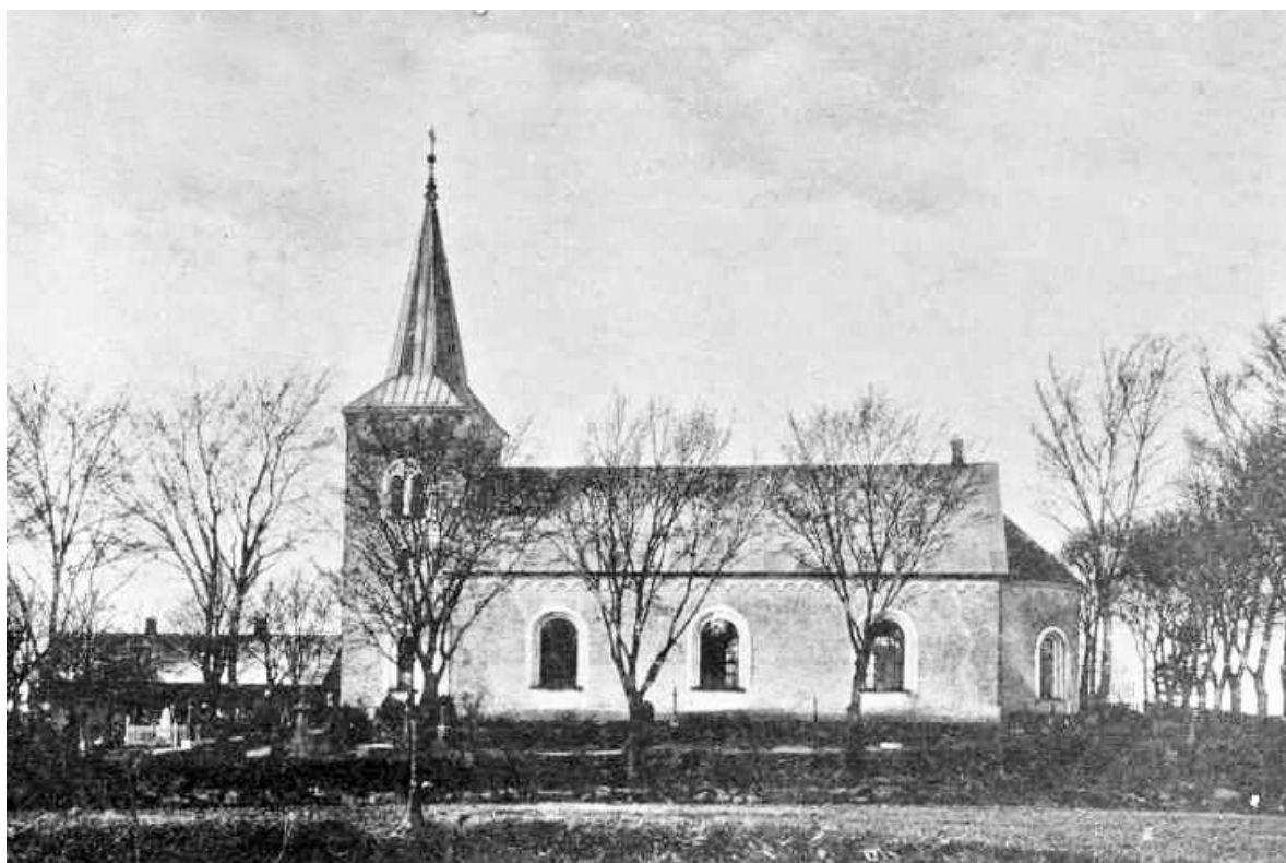
Katslösa kyrka vid okänd tidpunkt, troligen tidigt 1900-tal. Fasadputsens framstår som mörkare jämfört med de vita omfattningarna, vilket troligtvis även beror på att fasaderna är spritputsade. Nordväst om kyrkan syns den skolbyggnad som revs när gravkapellet uppfördes 1962. Bild från ATA, fotograf okänd.
