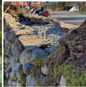
Muren fylls med småsten och makadam för att fylla ut hålrummet.
