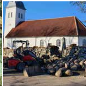
För att bygga upp muren behöver man först plocka ner den.
