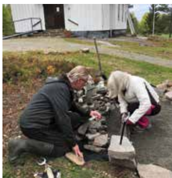
Arbetet är i full gång.
