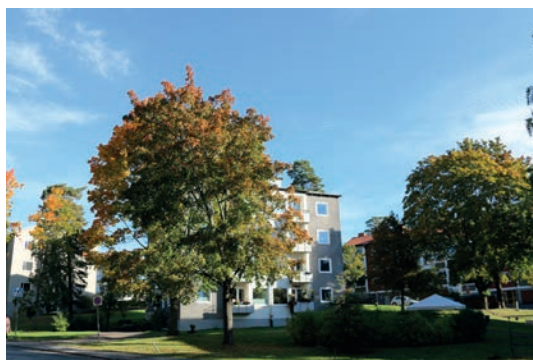
Örnstigen, Näsbypark. Byggt på 1950-talet.
