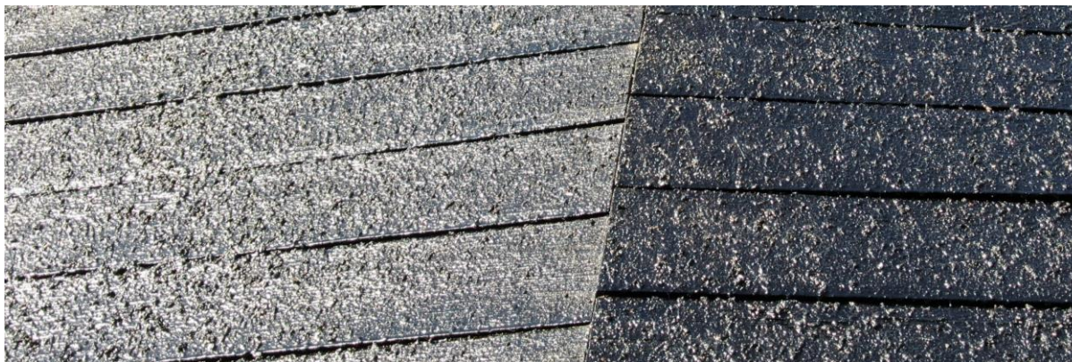
Närbild korabsidens takyta med dalbränd tjära från Ardre, malet kol och sand påkastat i samband med strykningen.
