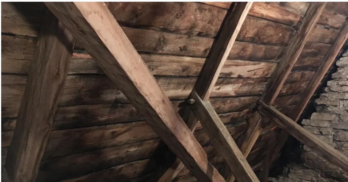
Underpanel till ett faltak tillverkade av ramsågade bräder.
