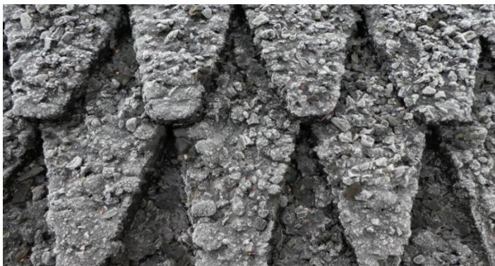
Røros kyrka och detalj på kyrktak, notera de grova kolbitarna.
