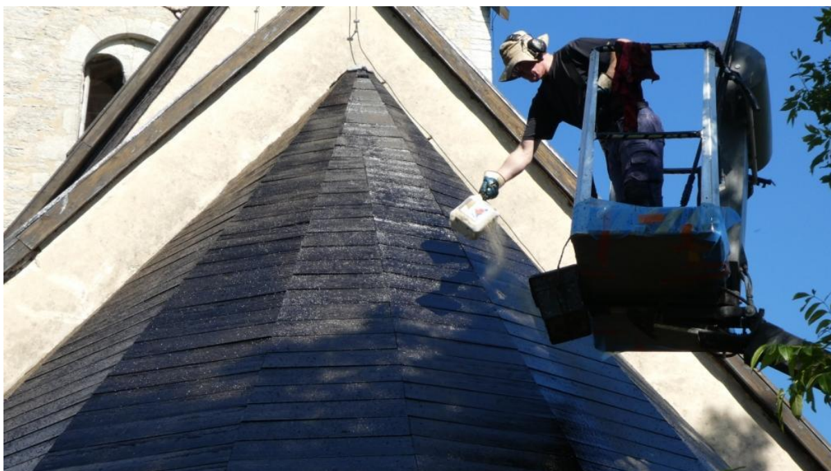
Tjärstrykare Johan Byh avslutar tjärstrykningen på korabsiden med att strö sand på det nytjärade taket.
