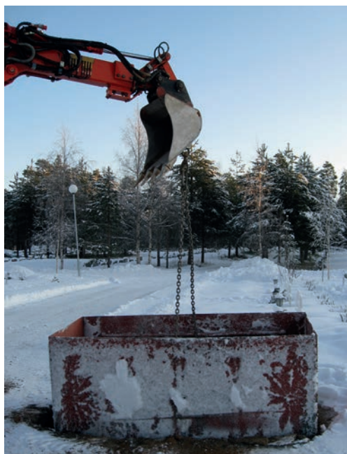
Egentillverkat rasskydd av järn i Nederkalix.
