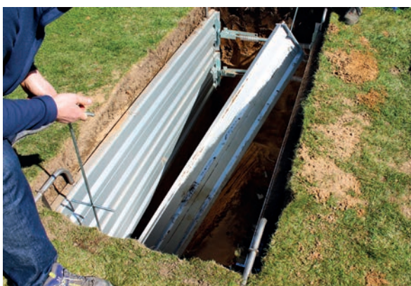
Används frigöringskrok kan rasskydden tas bort utan att någon behöver gå ner i graven. Foto: AB Orax
