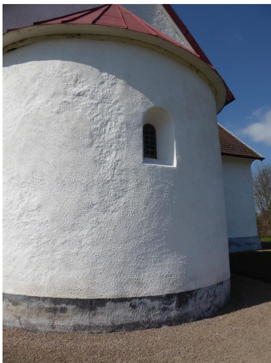
Kyrkans sockel är målad i kimröksgrå kulör. På kor och absid är sockeln endast målad, på övriga kyrkan är sockeln murad och skjuter ut utanför fasaden. Kyrkans fönster av gjutjärn har samtliga rundbågade och slätputsade omfattningar i tre språng. Slätputsen kontrasterar mot den övriga fasadens spritputs. De övre glasen i fönstren är färgade vilket ger ett intressant ljusspel i kyrkorummets interiör.
