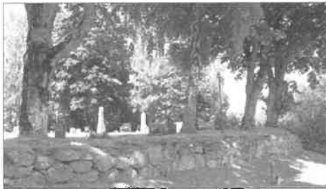
Överst: Trappa i stödmuren vid kyrkogårdens nordvästra hörn. Ovan: Kyrkogårdens omgärdning mot utvidgningen i sydost med stödmur och trädkerans.
