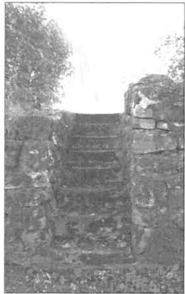
Stentrappa ledande ned till bäckeravinen norr om norra stödmuren.
